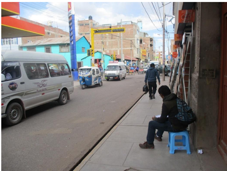
figura 69. Estado actual de la señalización horizontal de la intersección N° 6 Jr. Mariano Núñez – Jr. Huancané. Fuente: (Elaboración propia).
