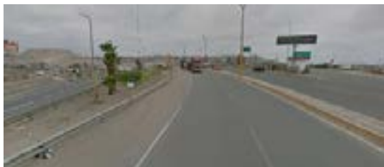
Figura N°82: Intercambio vial Mateo Pumacahua Fuente: Google maps, 2015
