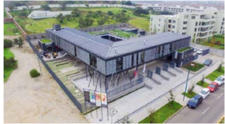
Figura N°72: Fachada principal del Centro Cultural el Tanque. Fuente: Archdaily,2017.
