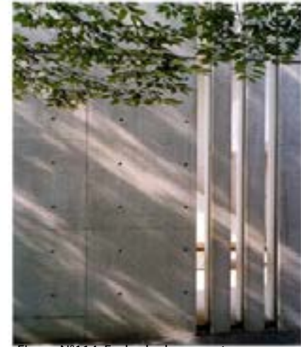
Figura N°114: Fachada de concreto Fuente: Archidally, 2016
