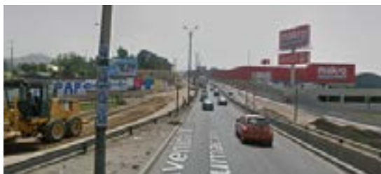
Figura N°83: Intercambio vial Villa Fuente: Google maps, 2015
