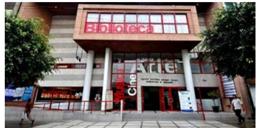
Figura N°47: Vista jerárquica Fuente: Google maps, 2016
