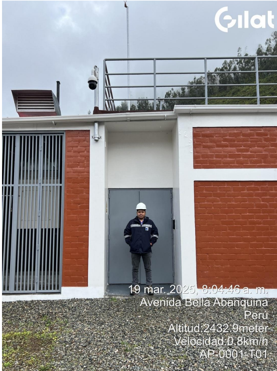
Vista exterior del Data Center en Abancay, región Apurímac, infraestructura que alberga equipos críticos de telecomunicaciones y energía.
