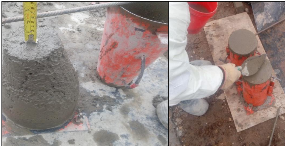
Se realizó el ensayo de asentamiento en concreto fresco (slump).
