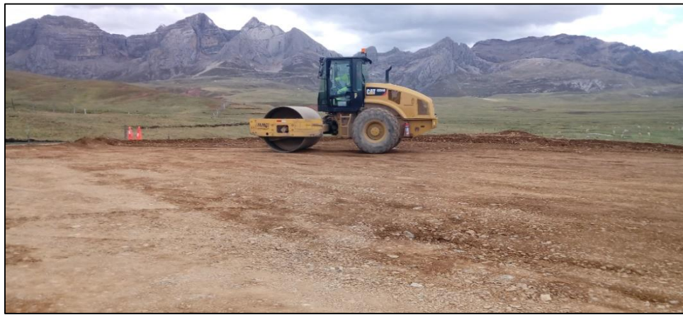
Compactación de material de relleno con rodillo.
