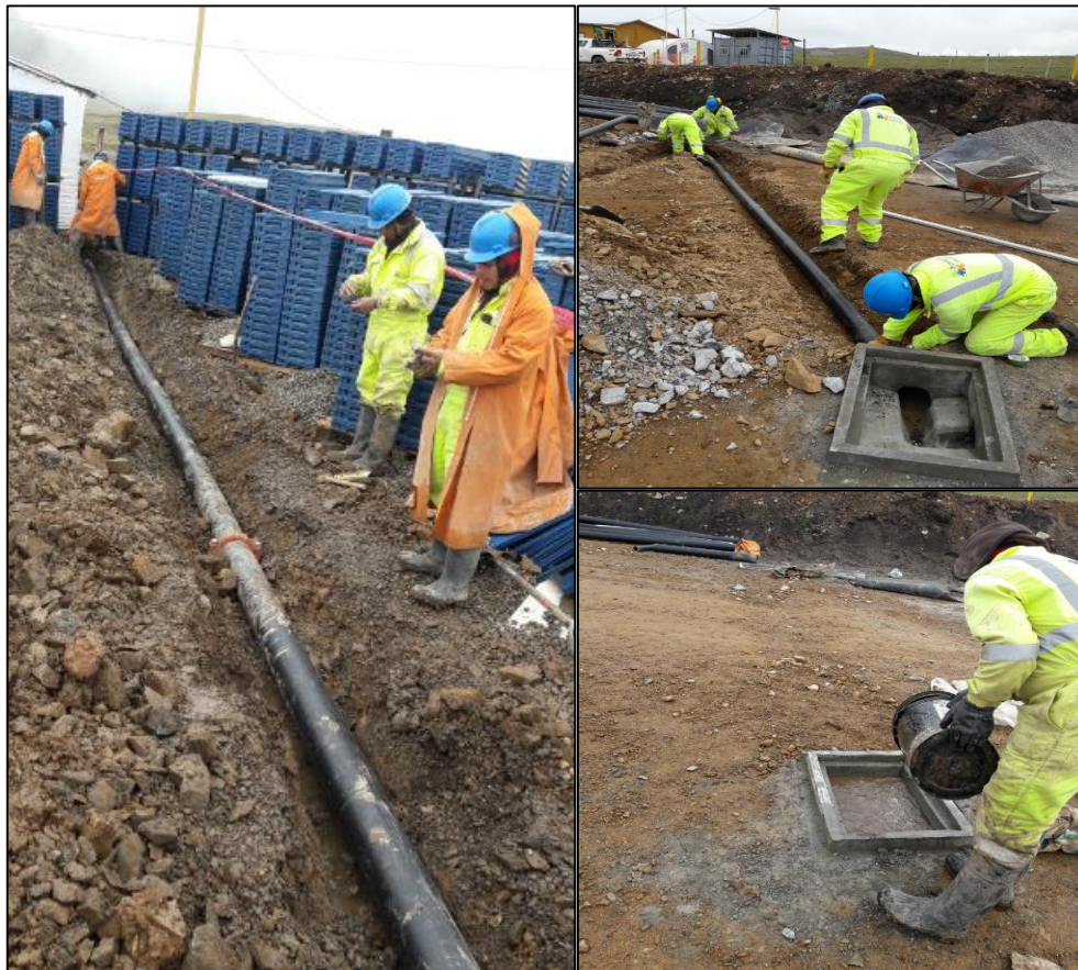
Colocación de tubería HDPE 4", construcción de cajas de registro y ejecución de la prueba hidráulica en Red Alcantarillado.
