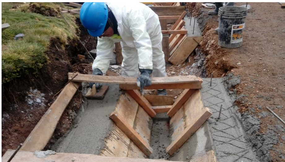
Vaciado de concreto en los paños del canal de coronación
