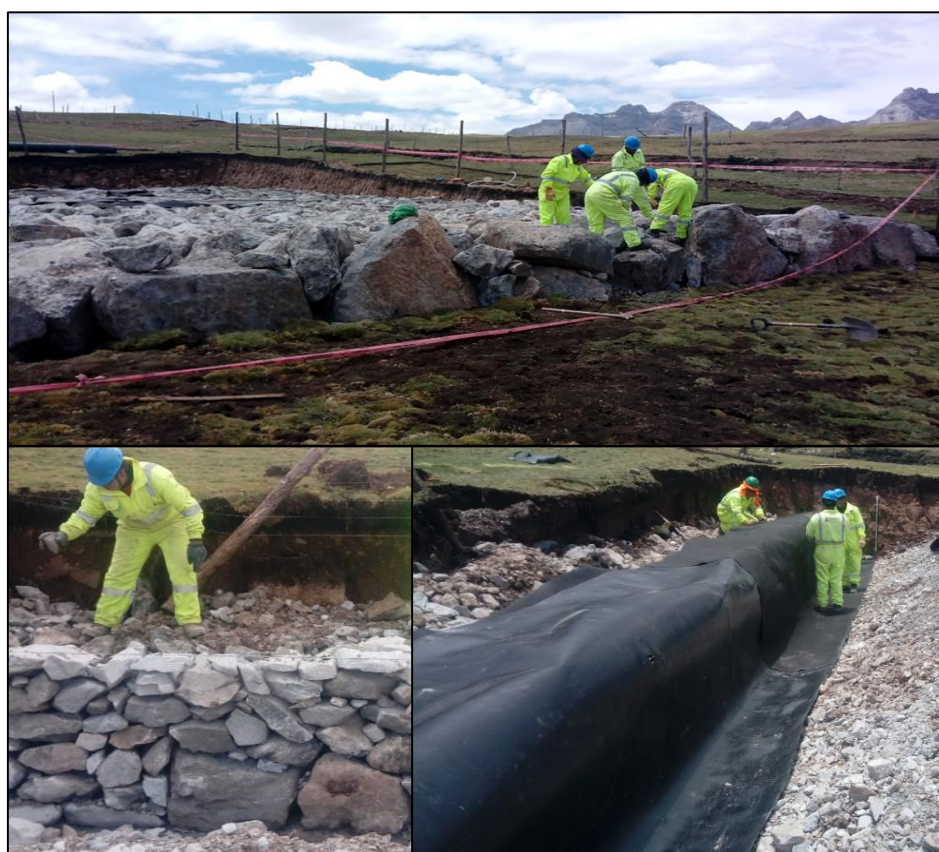
Conformación de enrocado, colocación de geomembrana y geotextil.
