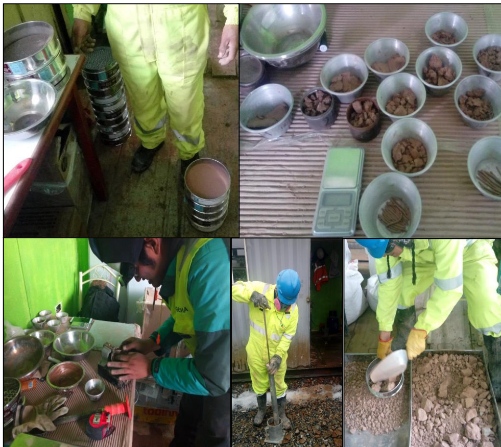
Ensayos geotécnicos: proctor modificado, granulometria y límites de atterberg.
