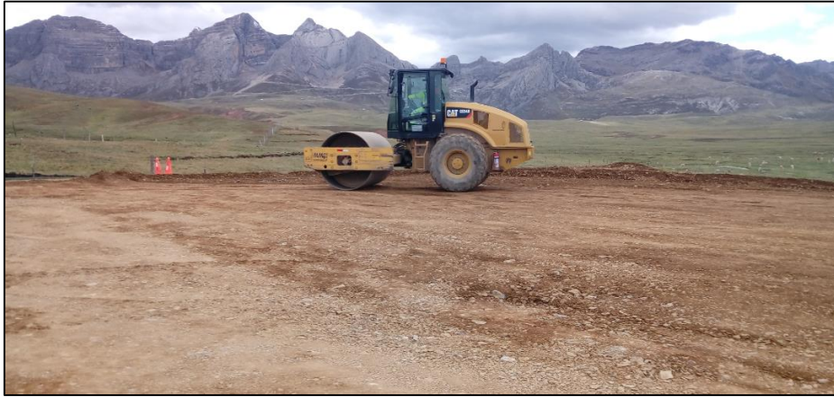
El rodillo realizo el compactado del material de relleno
