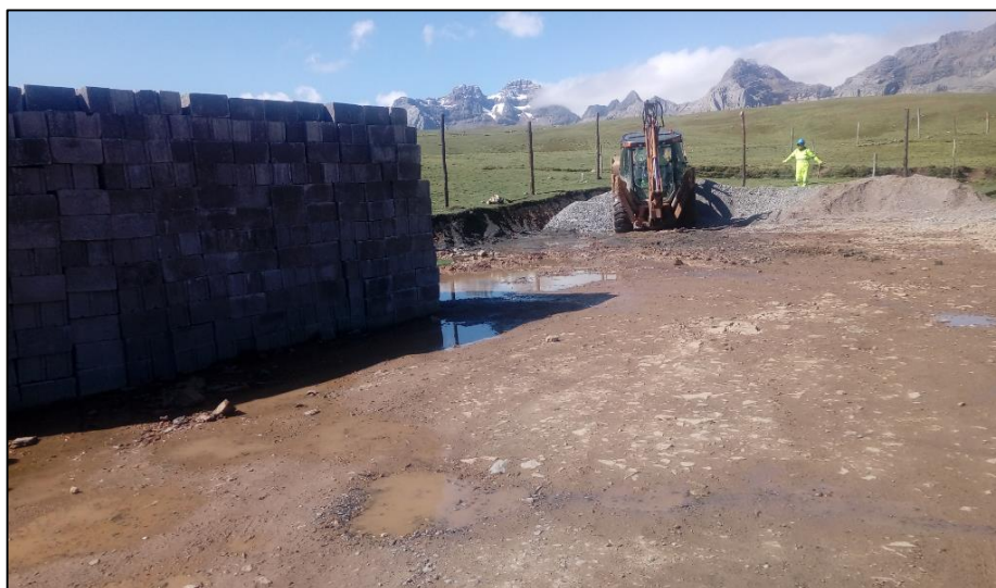
Vista de la Plataforma Yumpag con materiales de construcción ajenos al proyecto.
