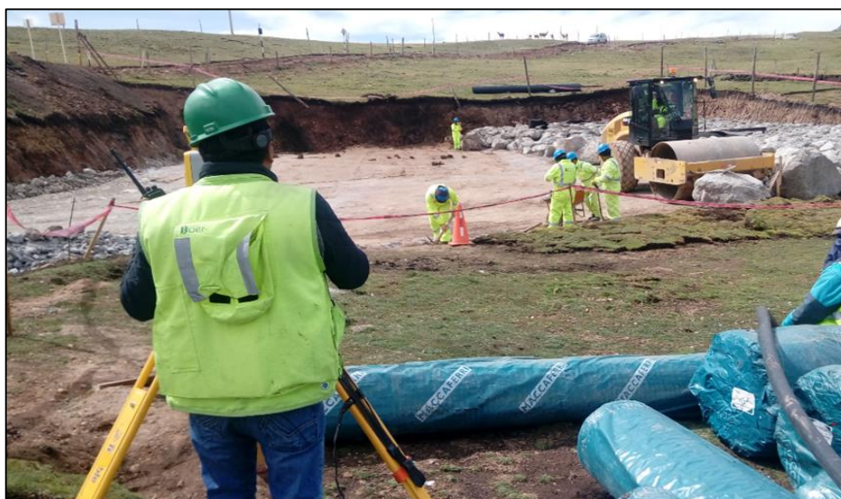
Control topográfico en la conformación de enrocado.
