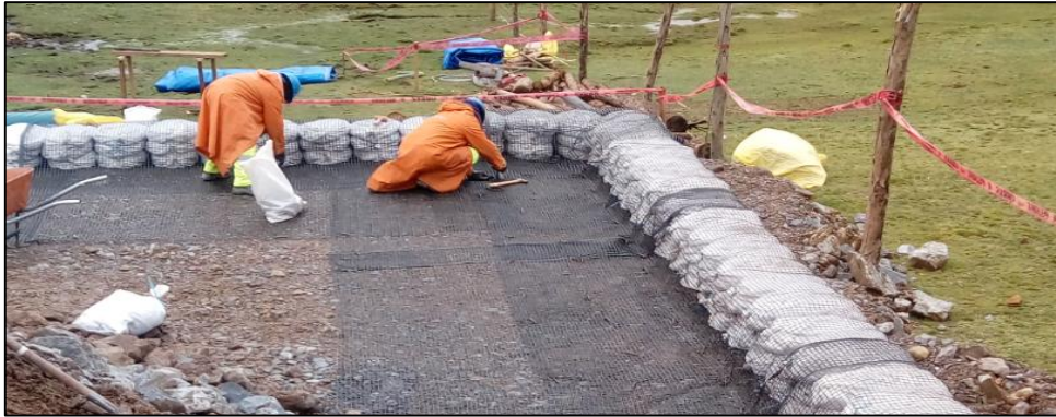
Colocación y Fijación de Geomalla
