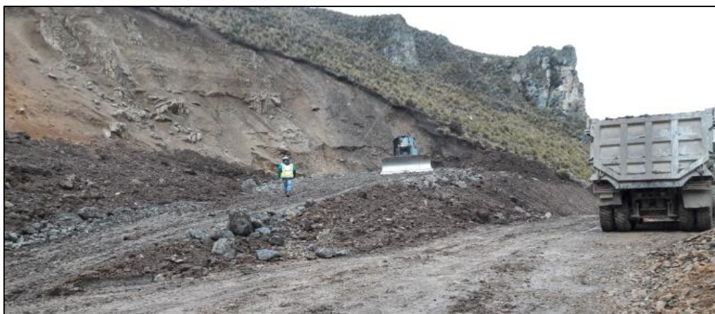
Zona de descarga de material propio en la cantera 01
