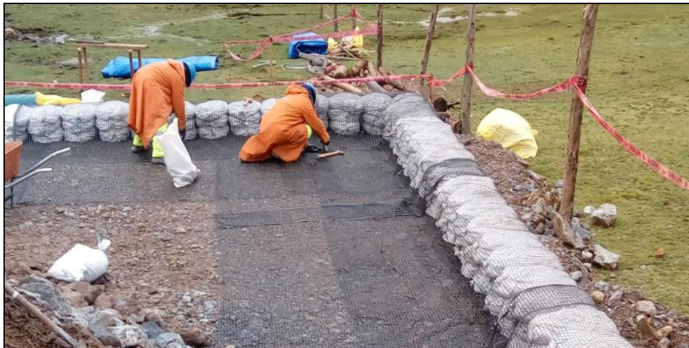
Fachada de sacos metaleros y fijación de geomalla en suelo reforzado.
