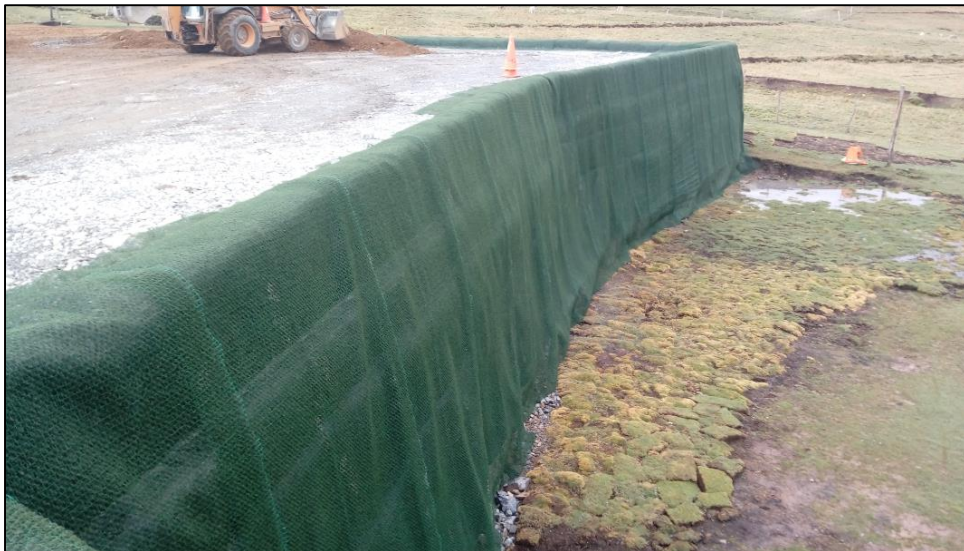
Colocación del Geotextil No tejido MACMAT en la fachada del muro.
