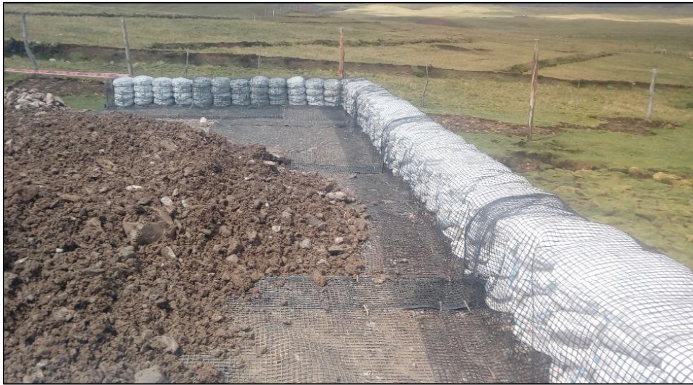
COLOCACIÓN Y FIJACION DE GEOMALLA
