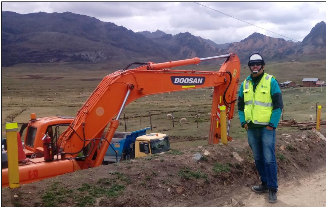
Inicio de los trabajos en plataforma Yumpag
