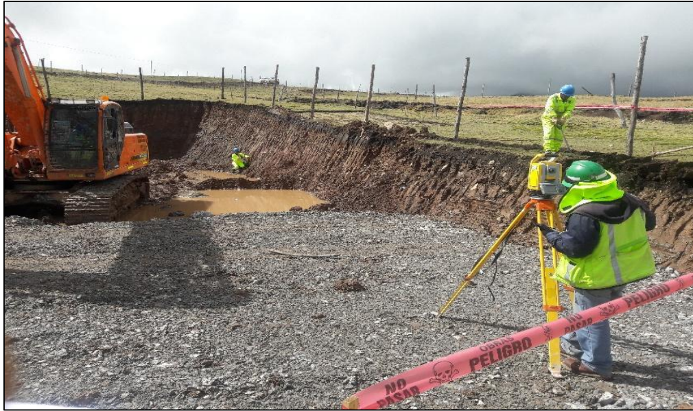
Control topográfico en plataforma
