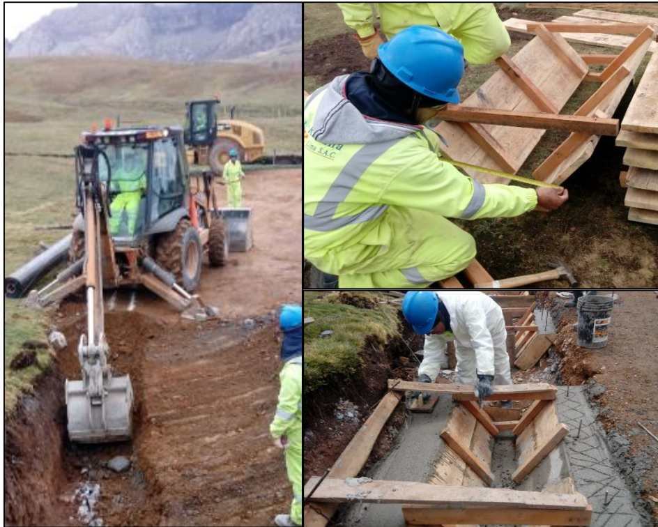
Exacavación, encofrado y vaciado de concreto del canal de coronación.
