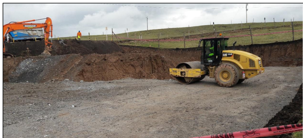
Compactacion con rodillo en subsante
