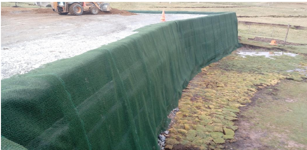
Colocación del Geotextil No Tejido MACMAT
