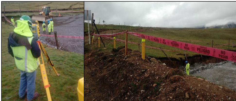
CONTROL TOPOGRAFICO Y DELIMITACIÓN CON CINTA DE PELIGRO EN LA PLATAFORMA 02.
