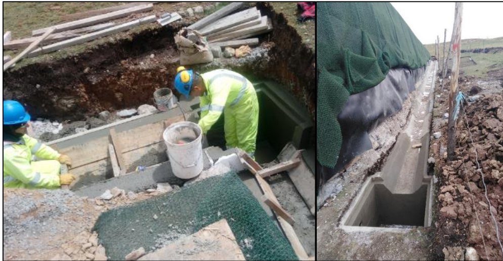
Construcción de las cajas de sedimentación N° 01 y N° 02.
