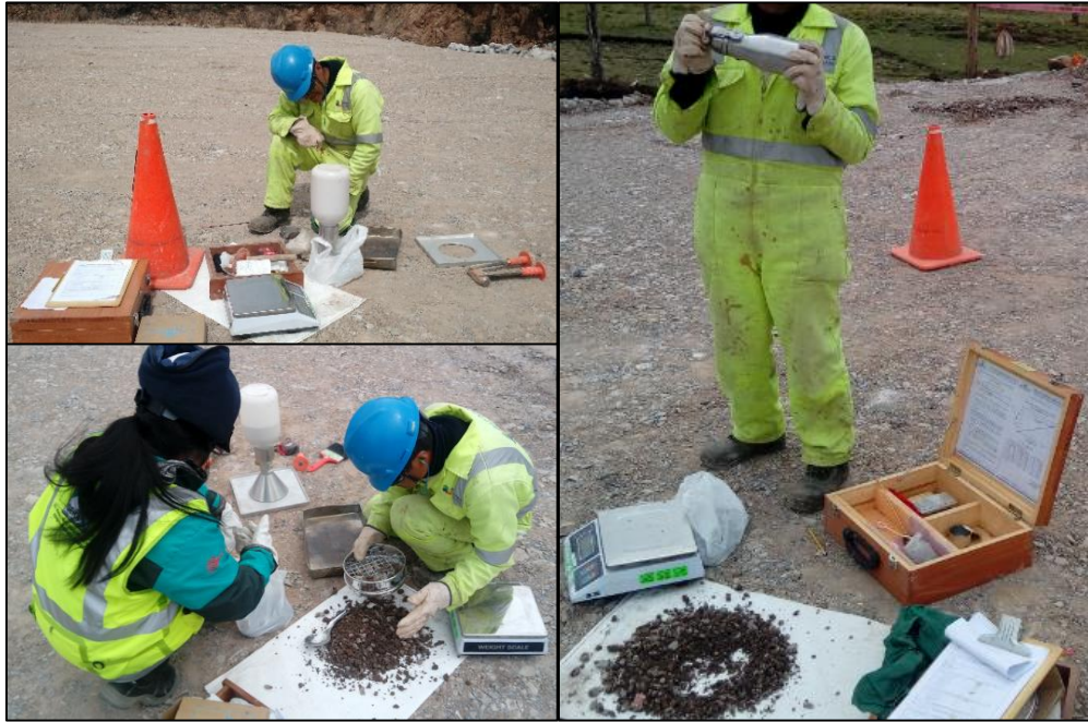
Ensayo de densidad humedad en campo
