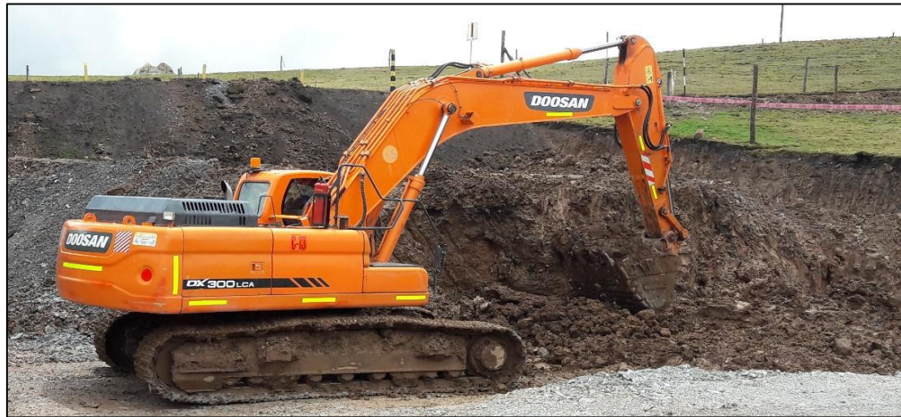
Corte y excavación de plataforma N° 02
