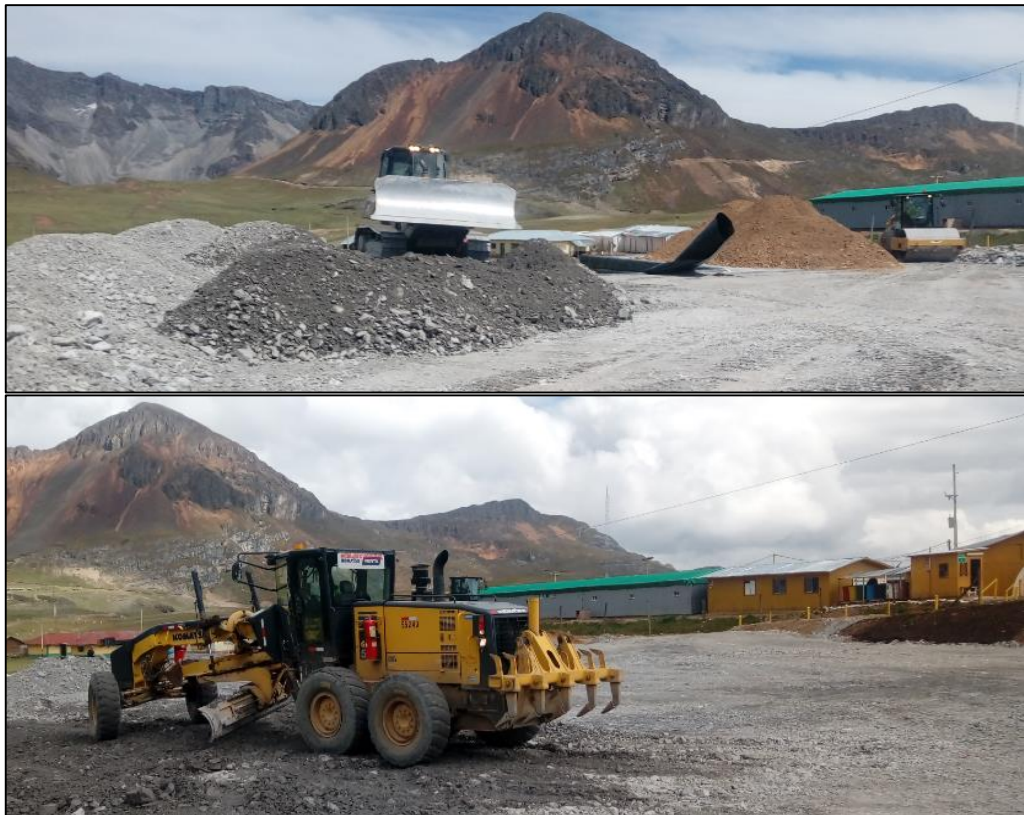
Extendido de material de relleno con tractor y motoniveladora.
