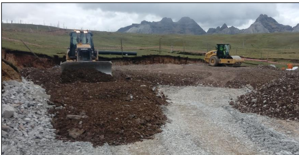
EXTENDIDO Y COMPACTADO DE MATERIAL MEZCLADO
