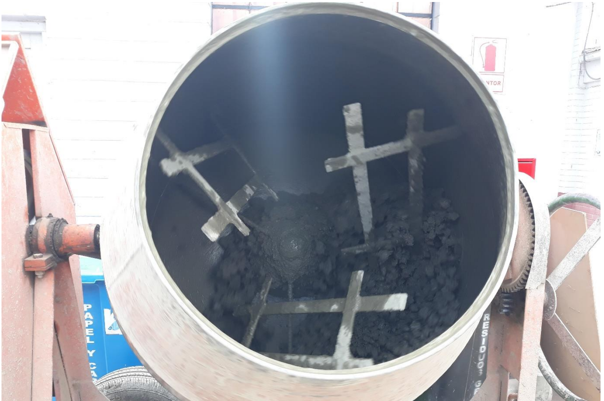
Fotografía 11. Mezclado del concreto
