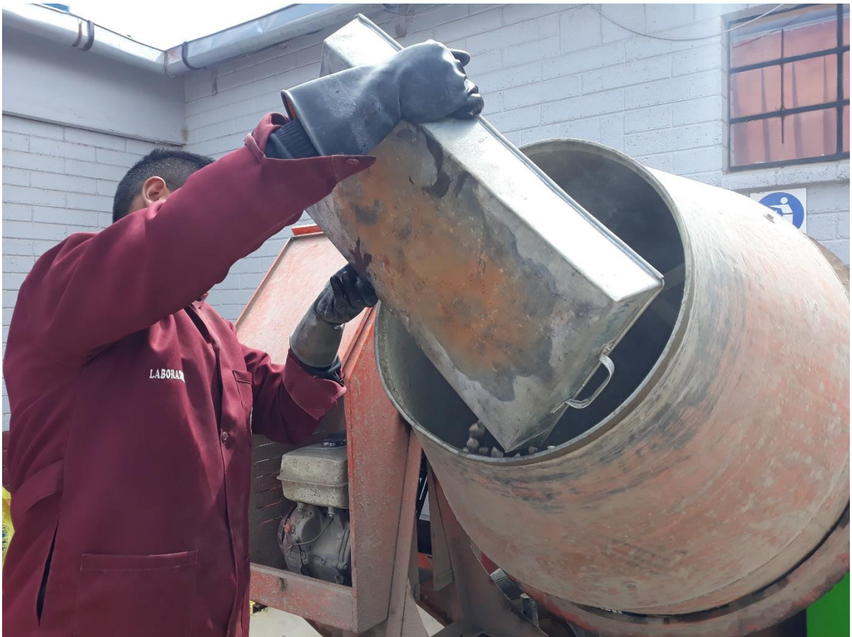
Fotografía 10. Suministro de los materiales del concreto Fast Track a la mezcladora
