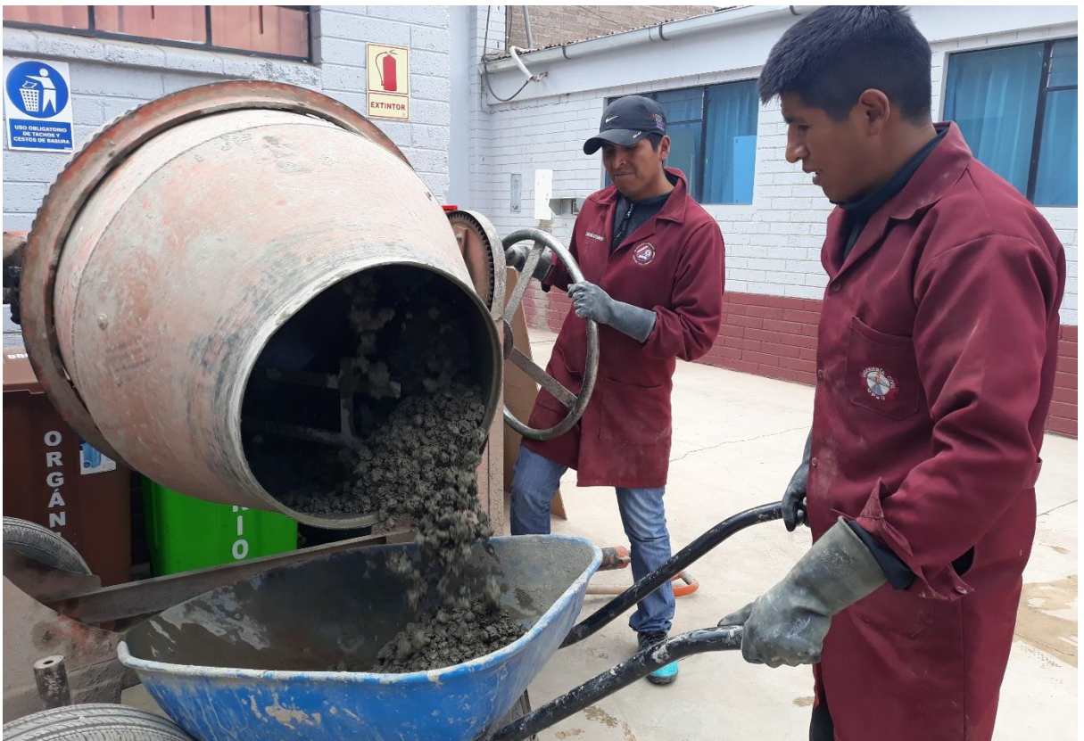
Fotografía 12. Concreto mezclado listo para colocación en las briquetas
