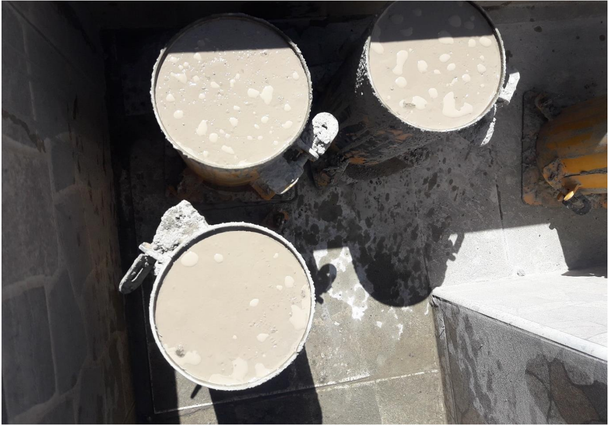
Fotografía 17. Moldes con concreto en proceso de fraguado
