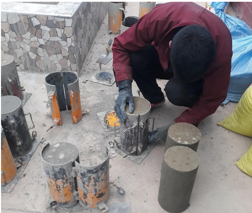
Fotografía 18. Desmolde de las muestras después de 3.5 hrs. del vaciado
