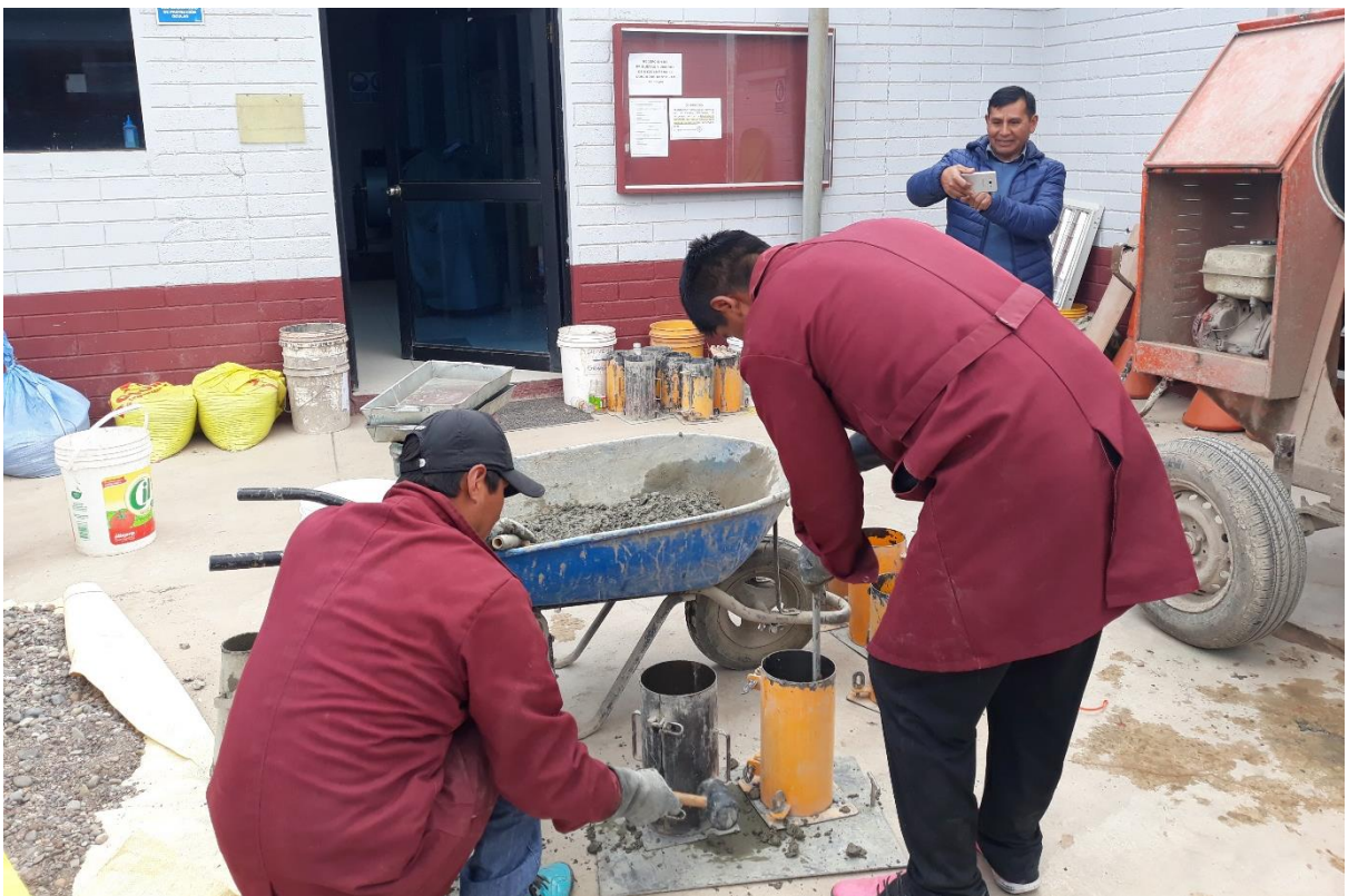
Fotografía 16. Varillado con 25 golpes cada 1/3 de altura colocado de concreto
