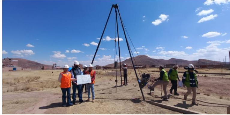
Imagen 1. Ensayo de penetración estándar (SPT)
