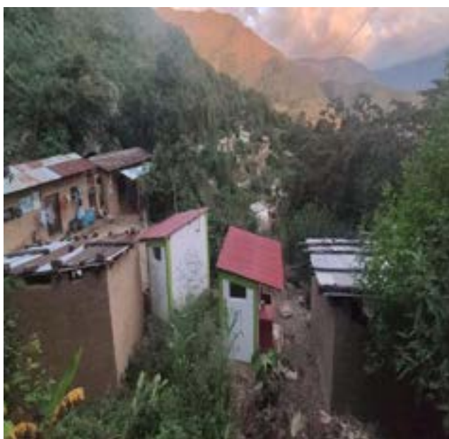
FOTO N° 07. Vista final de Unidades básicas de Saneamiento.
