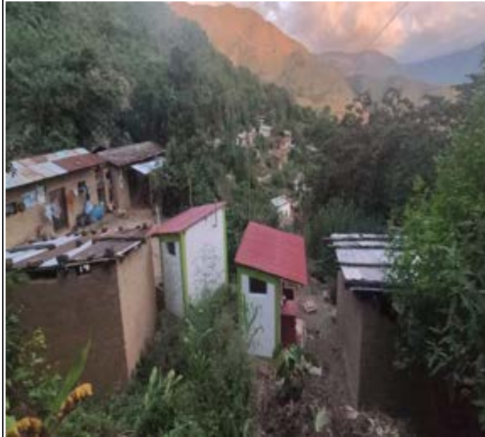
FOTO N° 01: Pintado anticorrosivo de calminas en Módulos del Sub-Sistema 02
