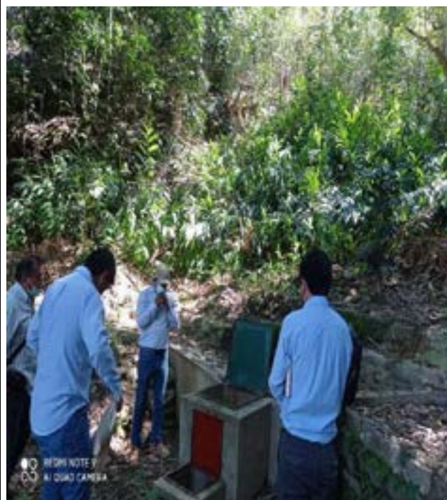
FOTO N°06. Verificación de la Cámara de válvulas de la Captación.
