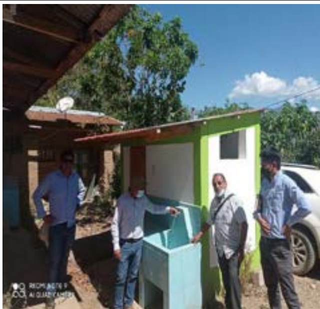
FOTO N° 03. Verificación de las Unidades básicas de Saneamiento.
