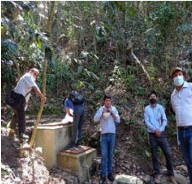
FOTO N° 01. Captación de ladera con cámara distribuidora de caudales SUB-SIST-03
