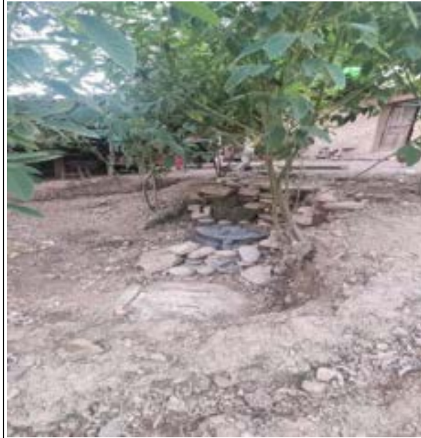
FOTO N° 02: Culminacion de la construccion de tapas y camara de lodos
