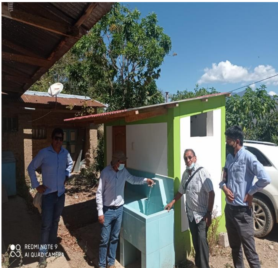
Unidad Básica de Saneamiento (UBS) con Arrastre Hidráulico
