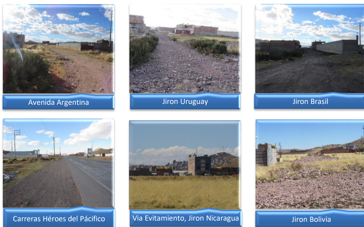
Figura 43. Fotografías de estado actual de las vías de la urbanización “las Américas”. Fuente propia.
