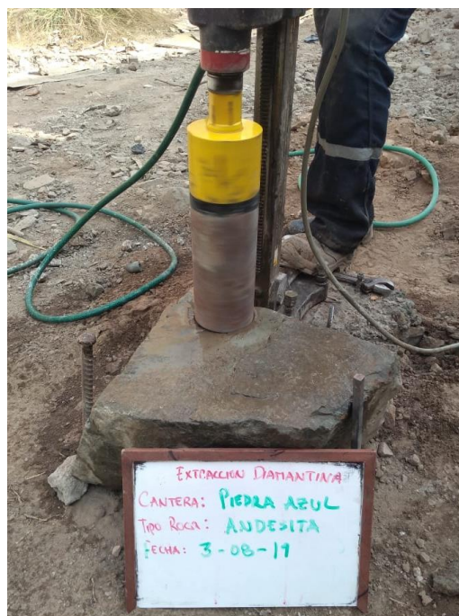
Figura 4. Extracción de testigo de roca con diamantina
