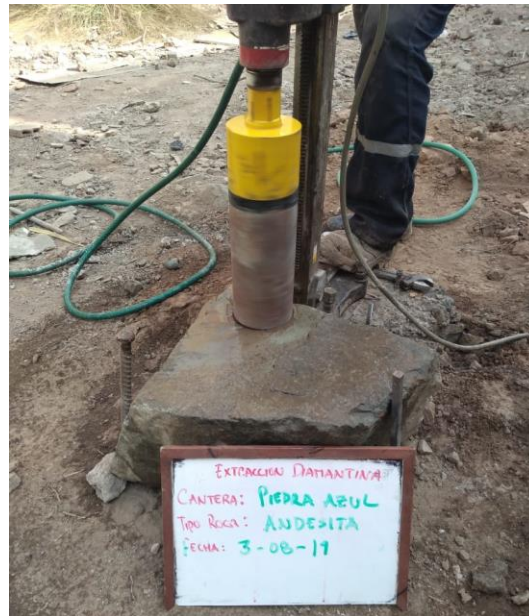
Figura 10. Extracción de testigo de roca para resistencia a compresión y tracción indirecta
