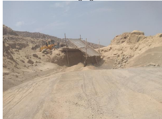
Recopilacion de agregado fino de cantera Lima I
