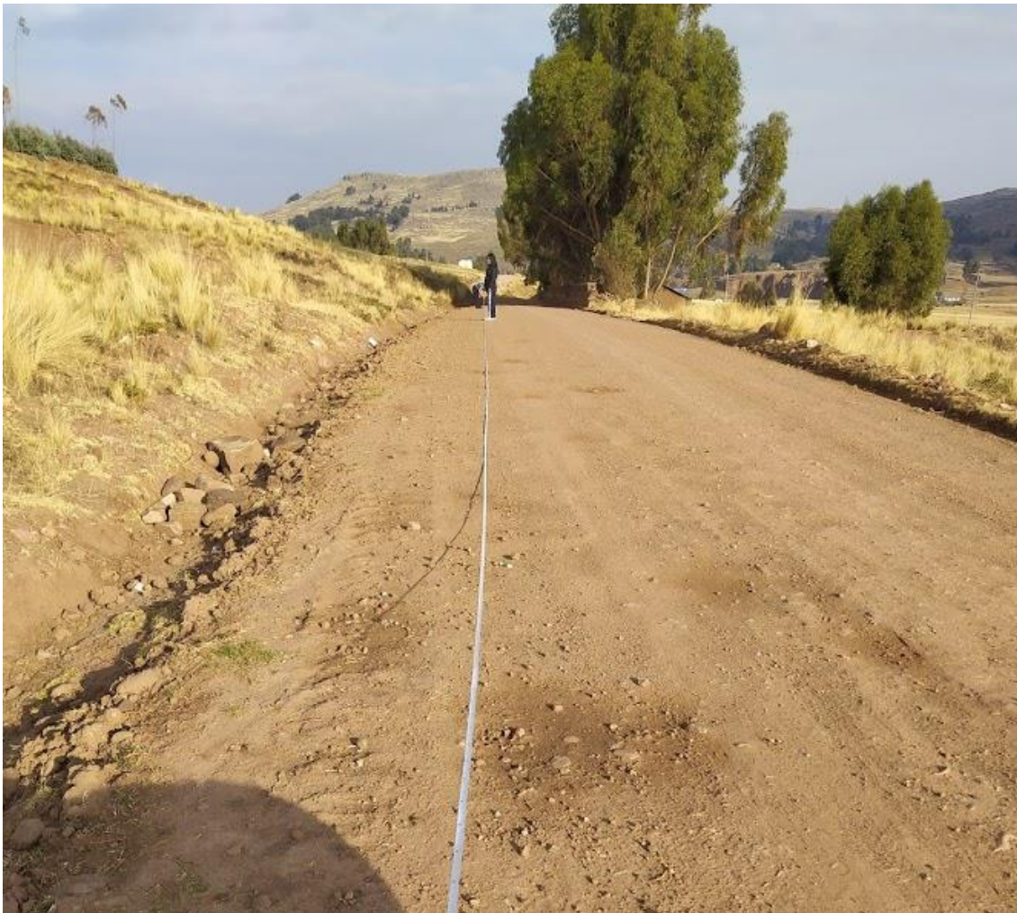
Ilustración 4. Medición longitudinal para el espaciamento de puntos de exploración.
