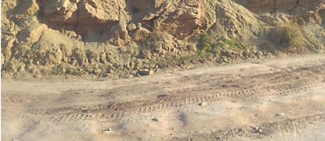
Ilustración 3. Subtramo con presencia de suelo arcilloso en la ruta Asiruni – Rosaspata.
