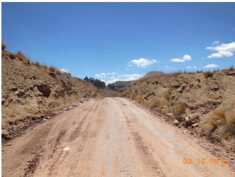
Figura 16. Visualización de suelo arcilloso en el sub tramo de estudio (Fuente: Elaboración propia)
