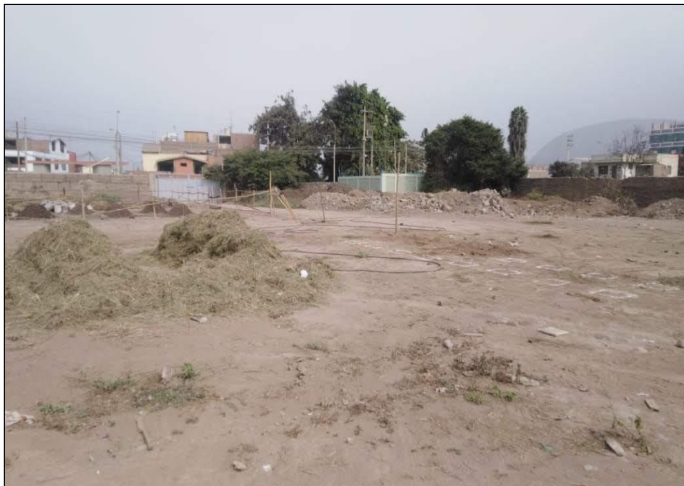
Figura 78. Acondicionamiento de terreno para la ejecución de tesis.
