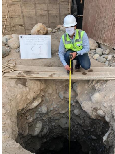
Imagen 31: Calicata C-1. Fuente: Elaboración propia.
