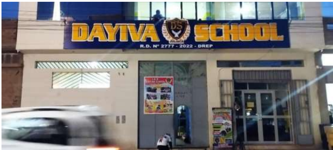
Figura 23. Colocación del letrero institucional.
