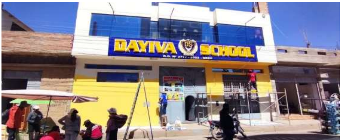
Figura 24. Pintado y señalización de fachada
