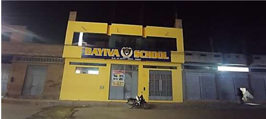
Figura 25. Fachada final luego del pintado y señalización.
