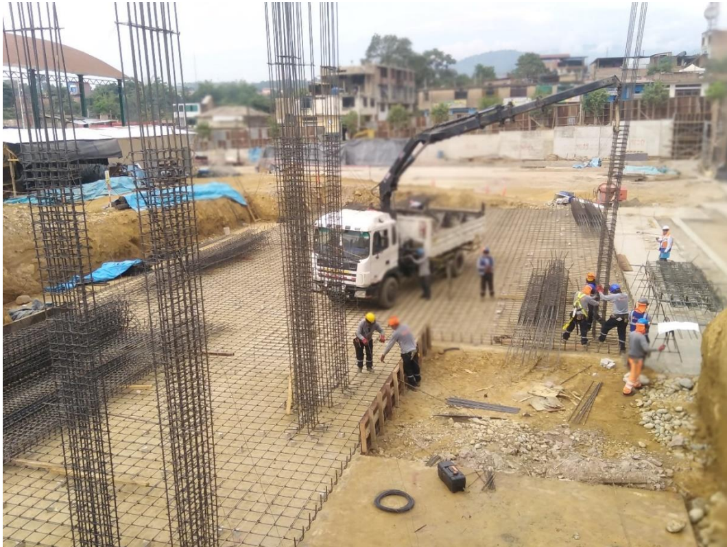
Figura 186: Encofrado de zapatas de rampa – M09 y M10.
