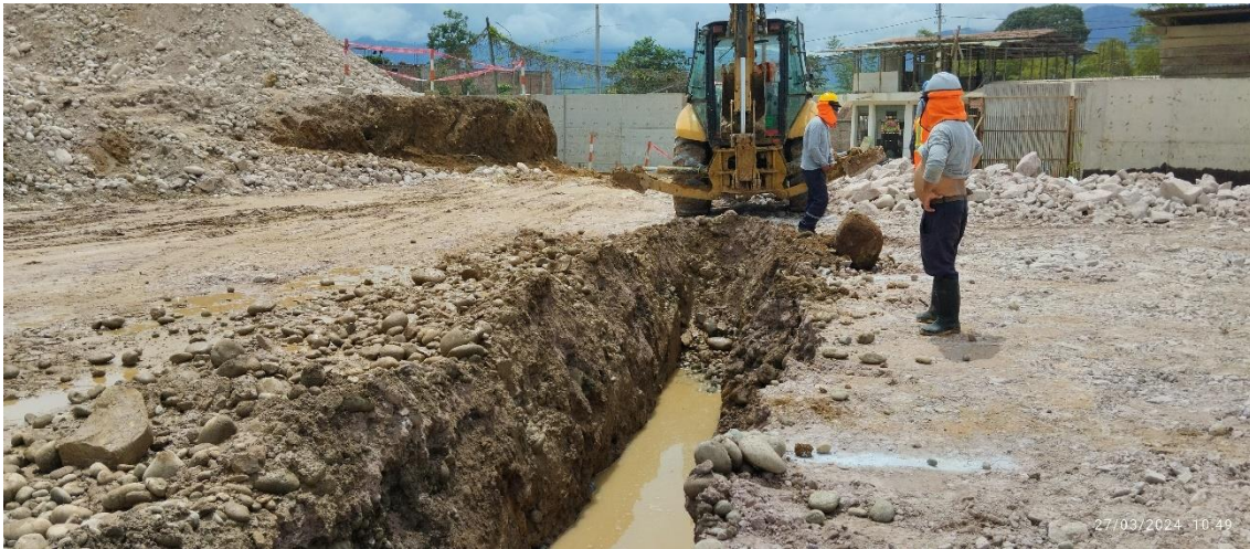
Figura 109: Excavación con maquinaria - Tramo C - MÓDULO 3.
