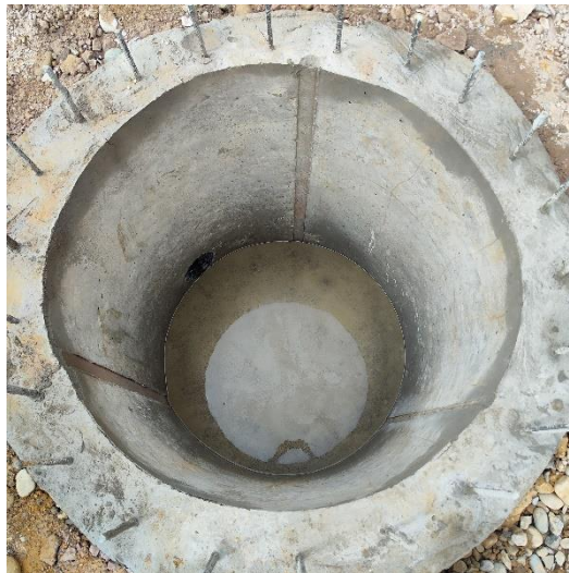
Figura 112: Concreto en buzón N°04.
