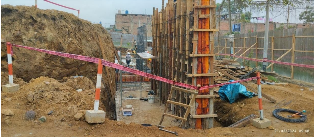
Figura 255: Armado de acero en pantalla de muros MC-08 bloque 11.
