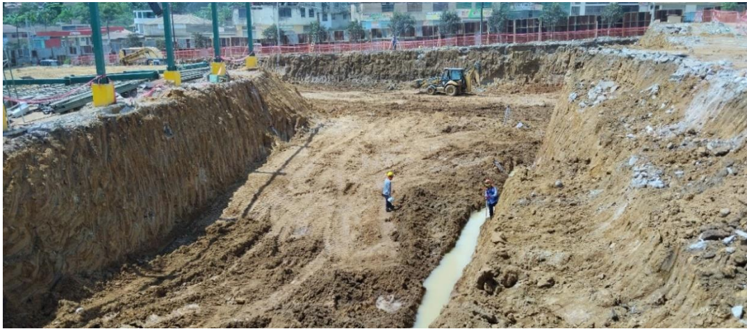
Figura 173: Trazo y replanteo de cimentación de rampa ubicada en bloque SUM.
