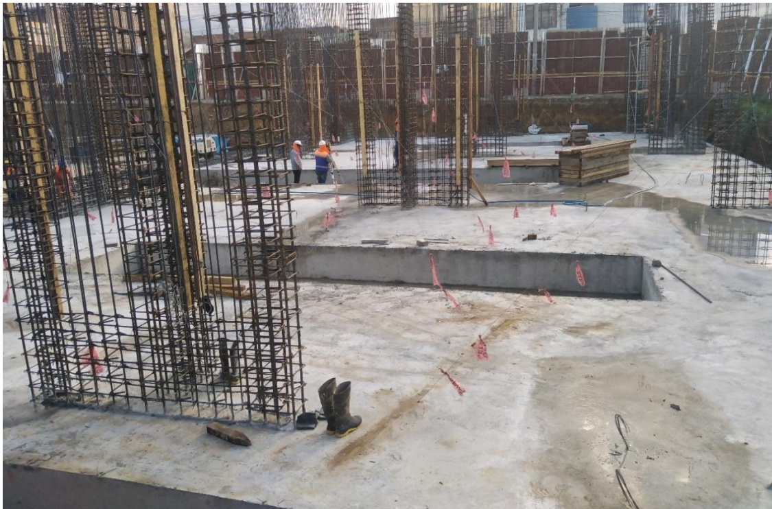
Figura 164: Desencofrado losa de cimentación – bloque secundaria módulo 08.
