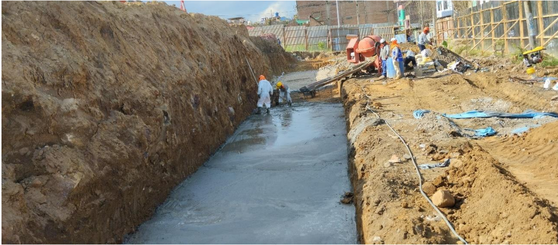
Figura 252: Trazo y replanteo de zapatas muros MC-08 del bloque 11.
