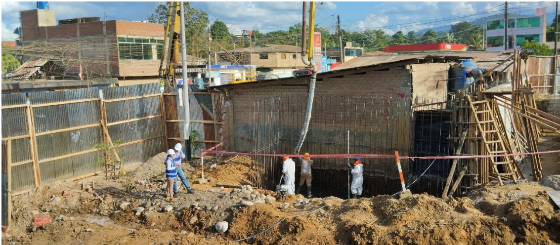
Figura 244: Concreto f'c=210 \text{ kg/cm}^2 en MC-08, vértice A8 y A9.
