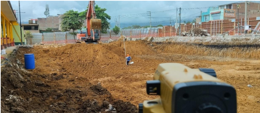
Figura 154: Colocación de material de préstamo OVER – Bloque secundaria.
