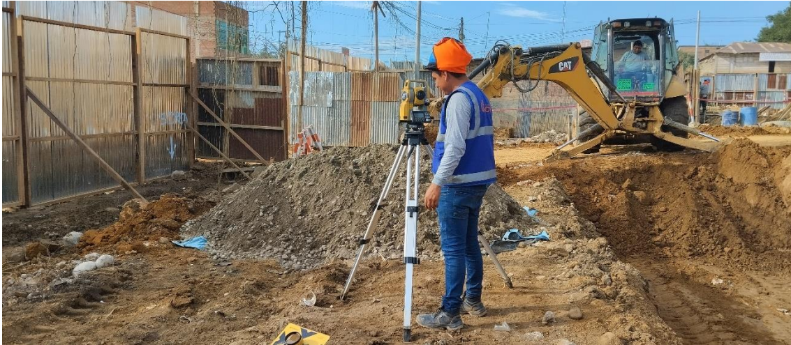
Figura 107: Trazo y replanteo del tramo C del sistema de drenaje.
