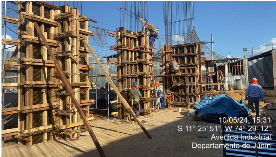
Figura 208: Armado de acero y encofrado de placas PL-02, PL-18 y muro sótano.
