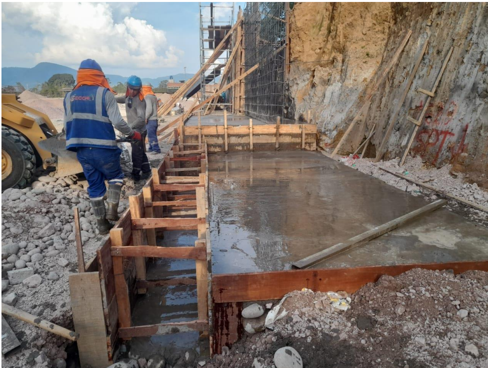
Figura 287: Vaciado de concreto en solado de muro MC-20, vértice A9-A10.
