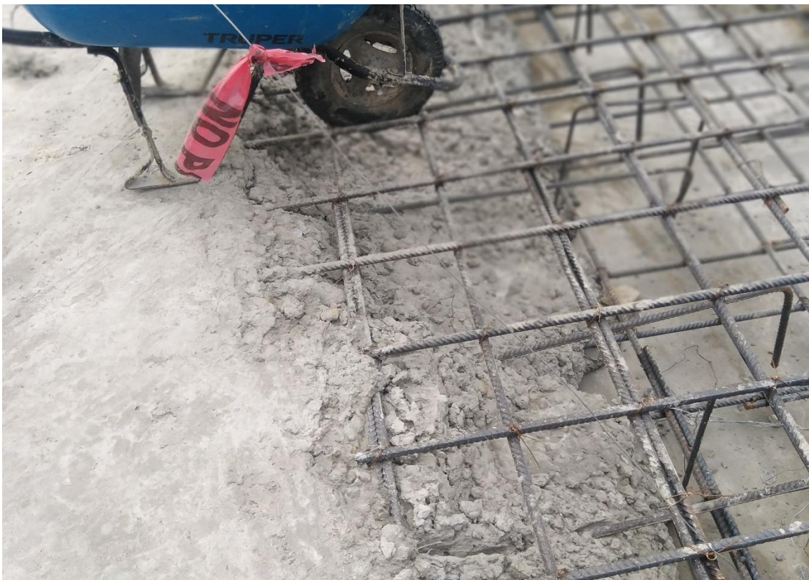
Figura 132: Junta fría generada por el vaciado de concreto losa de cimentación módulo 01.
