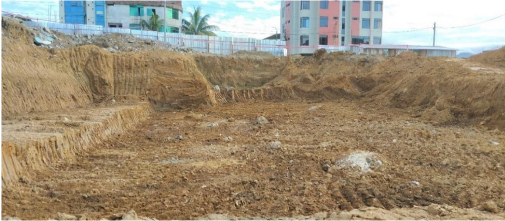
Figura 175: Colocación y compactación de material de préstamo OVER.
