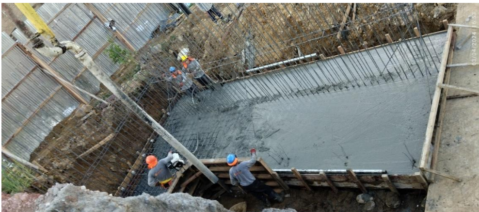
Figura 261: Vaciado de concreto en zapata de muro MC-09a.
