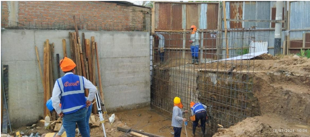
Figura 235: Armado de acero en zapata MC-08, vértice A6 y A7.
