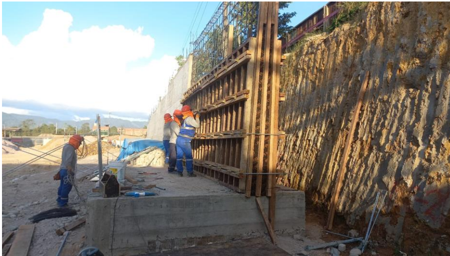
Figura 290: Muros de contención en vértice A9 – A10, Av. Sonomoro.
