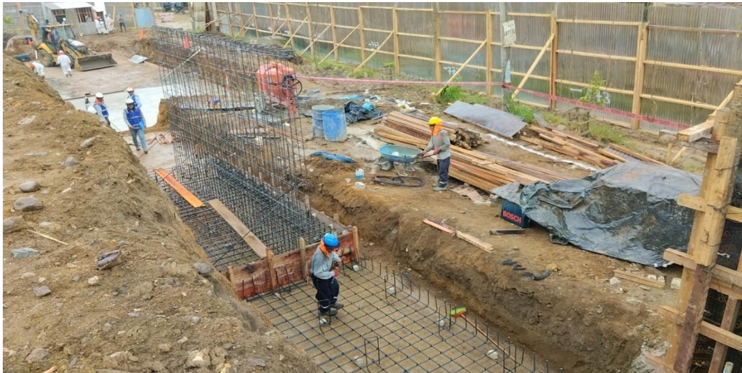
Figura 256: Verificación de trabajos de encofrado de pantalla de muros MC-08 bloque 11.
