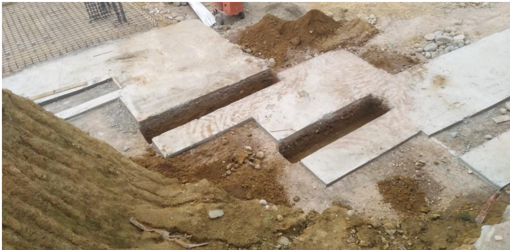
Figura 279: Trazo y excavación para muros MC-05d y MC-06f en Av. Industrial.
