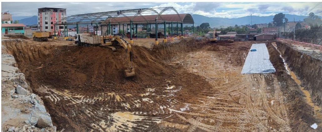
Figura 60: Excavación a nivel de fundación – Bloque primaria.
