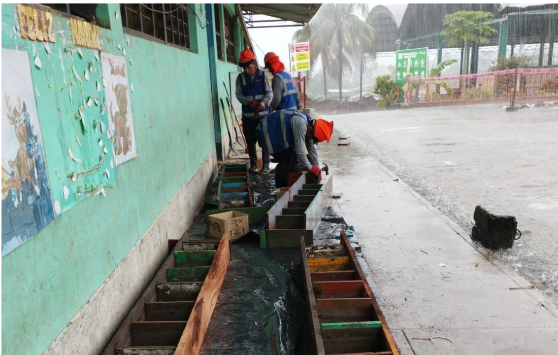
Figura 31: Encofrado de cachacos de seguridad de concreto.
