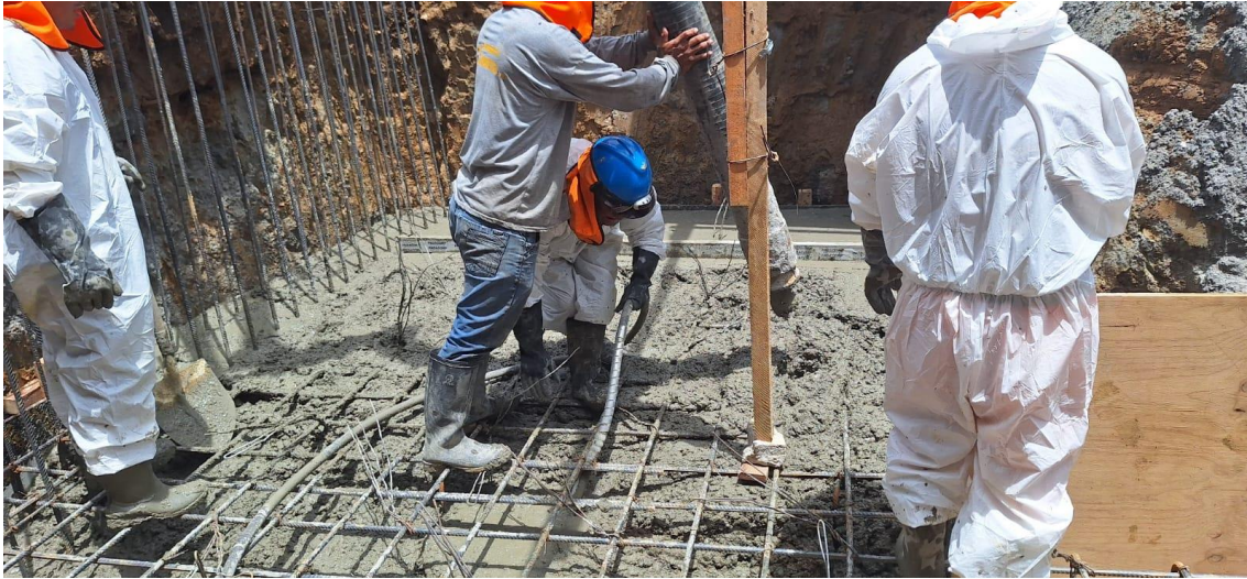
Figura 228: Armado de acero en muro MC-08 y MC-08a.
