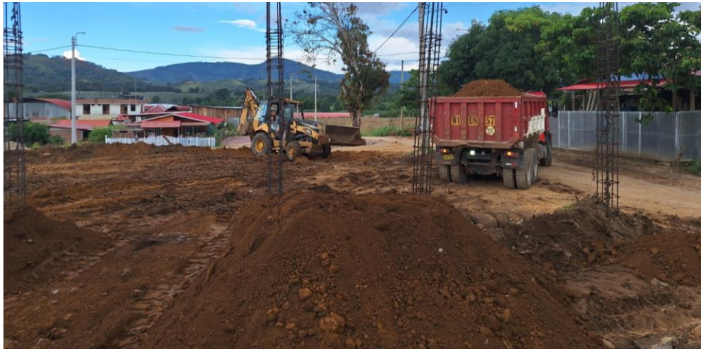
Figura 67: Verificación de trabajos de transporte de material excedente.
