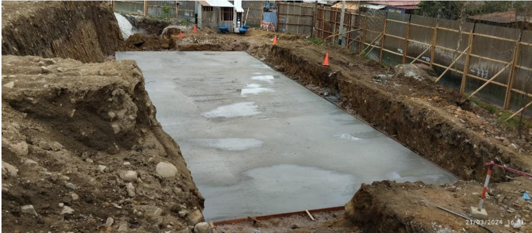
Figura 201: Armado de acero inferior en losa de cimentación – Bloque 11.
