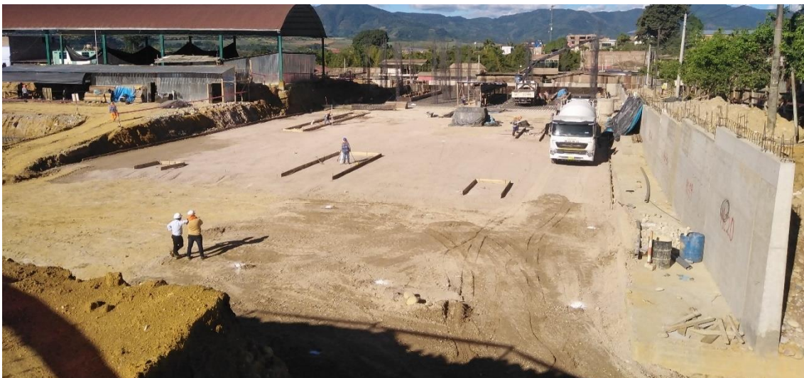
Figura 124: Vaciado de solado módulo 04.
