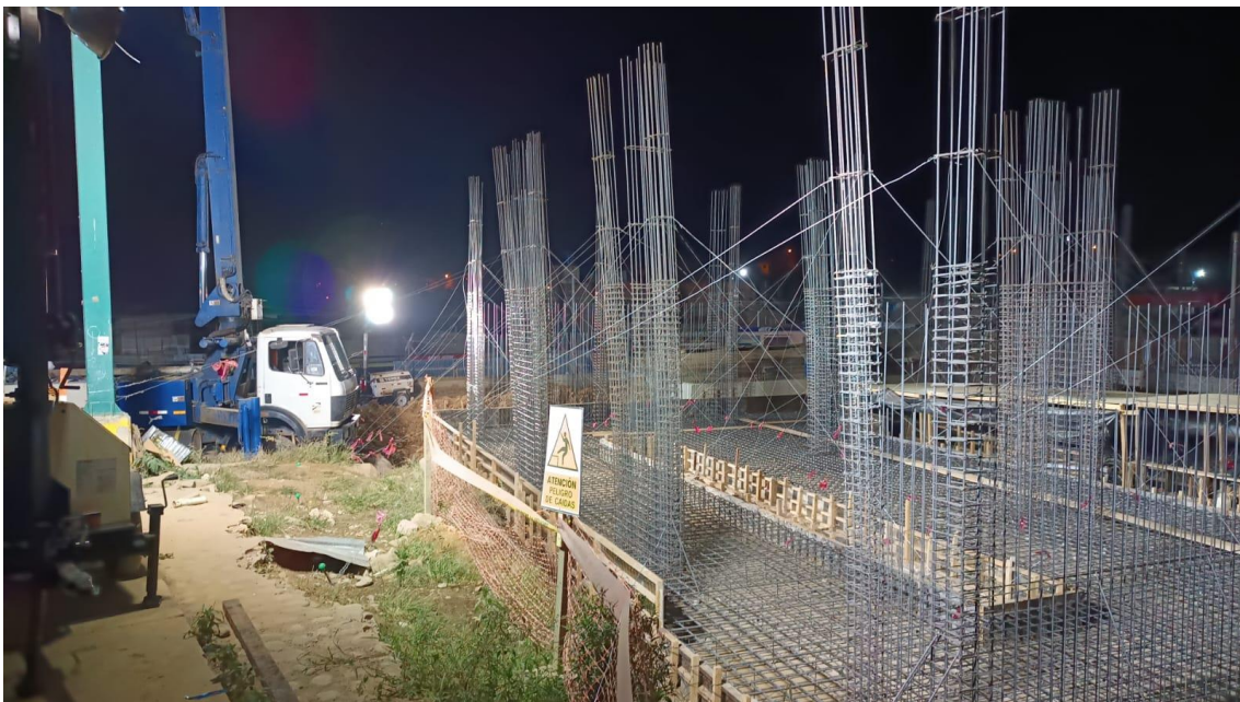
Figura 130: Vaciado de concreto f'c=280 \text{ kg/cm}^2 – módulo 04.
