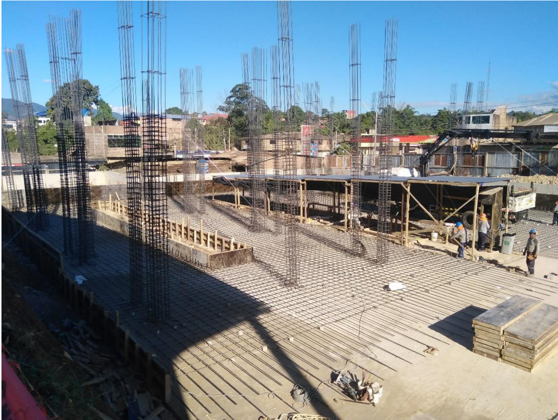
Figura 130: Vaciado de concreto f'c=280 \text{ kg/cm}^2 – módulo 04.
