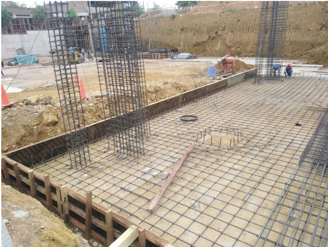
Figura 188: Encofrado losa de cimentación módulo 10.
