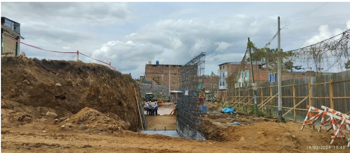
Figura 253: Armado de acero en pantalla de muro MC-08 bloque 11.
