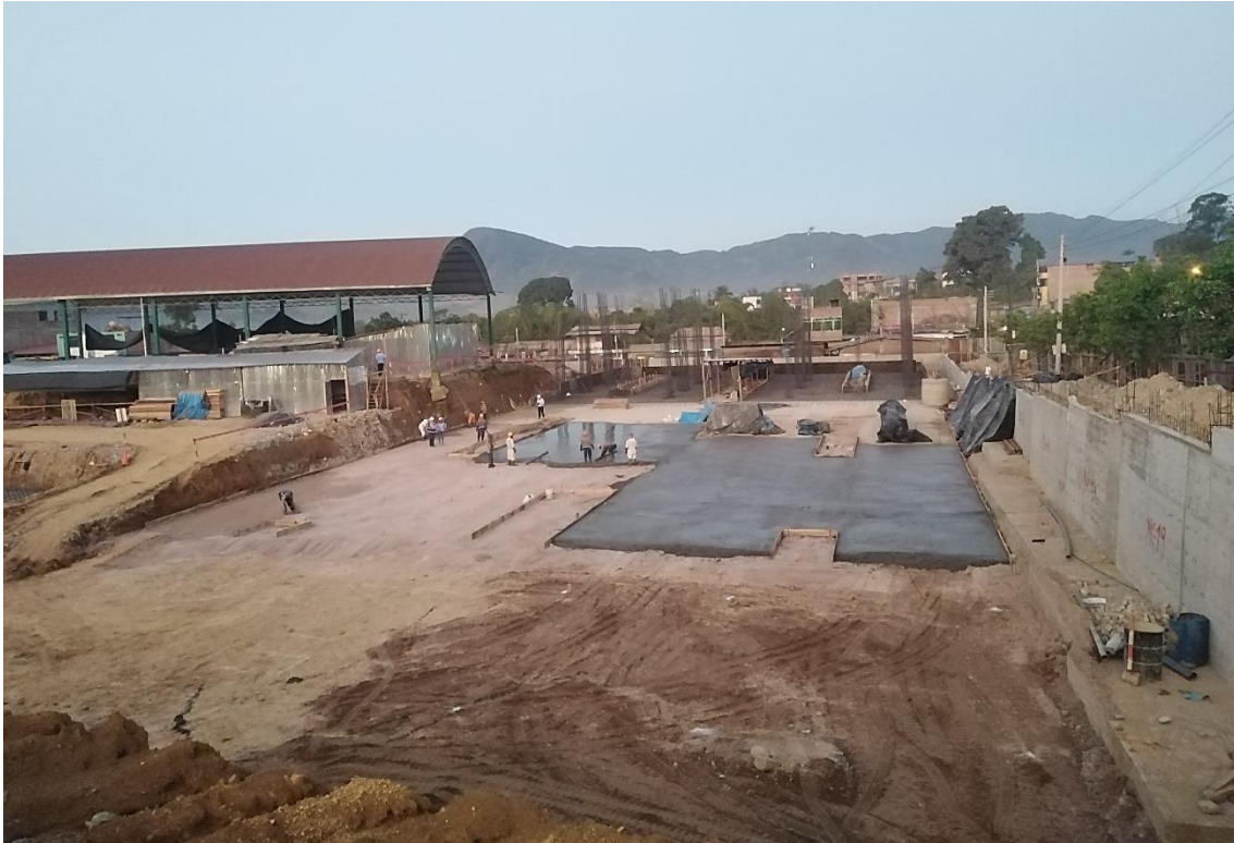
Figura 126: Vaciado de solado módulo 03.
