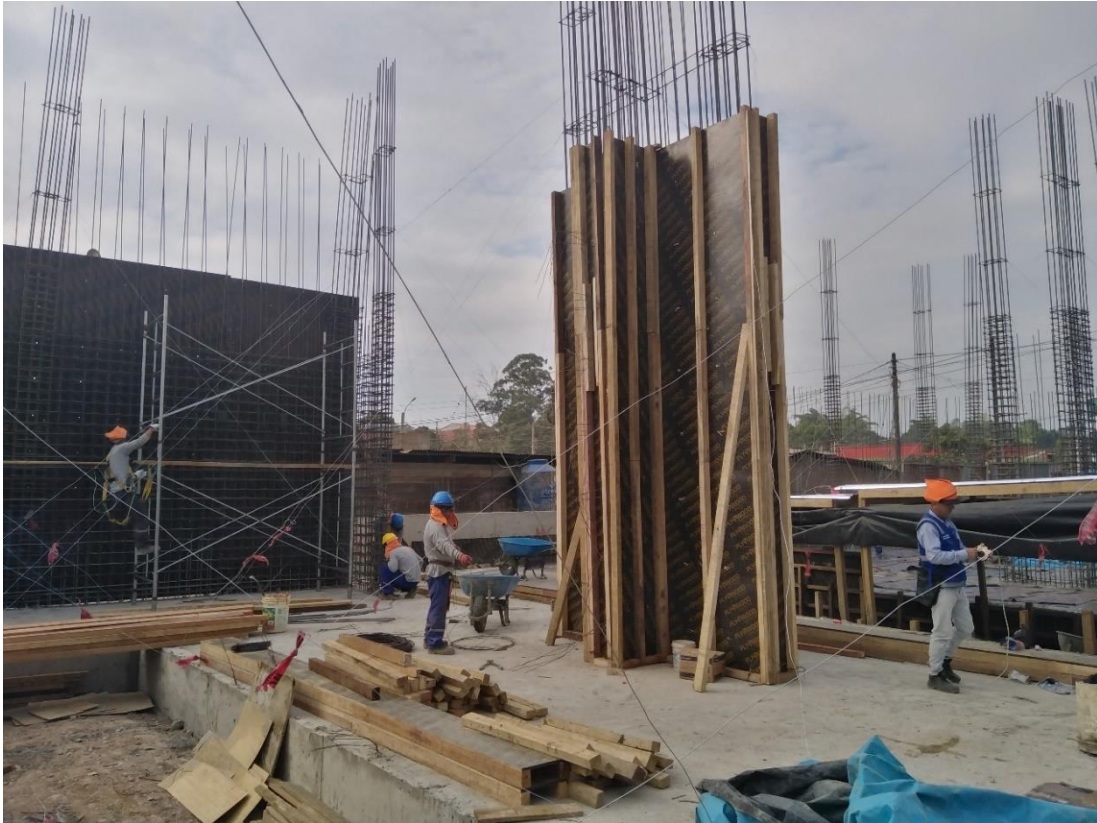
Figura 144: Trazo para encofrado en placas módulo 4.
