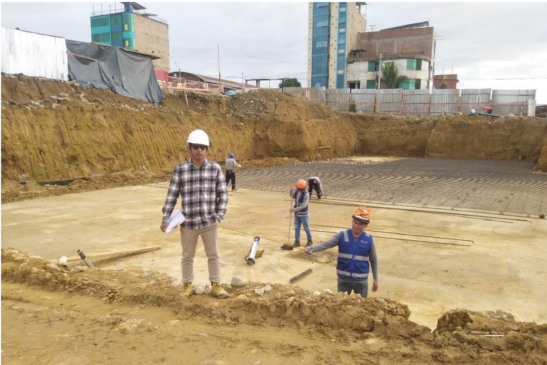
Figura 184: Verificación de colocación de acero inferior en losa de cimentación – M09 y M10.
