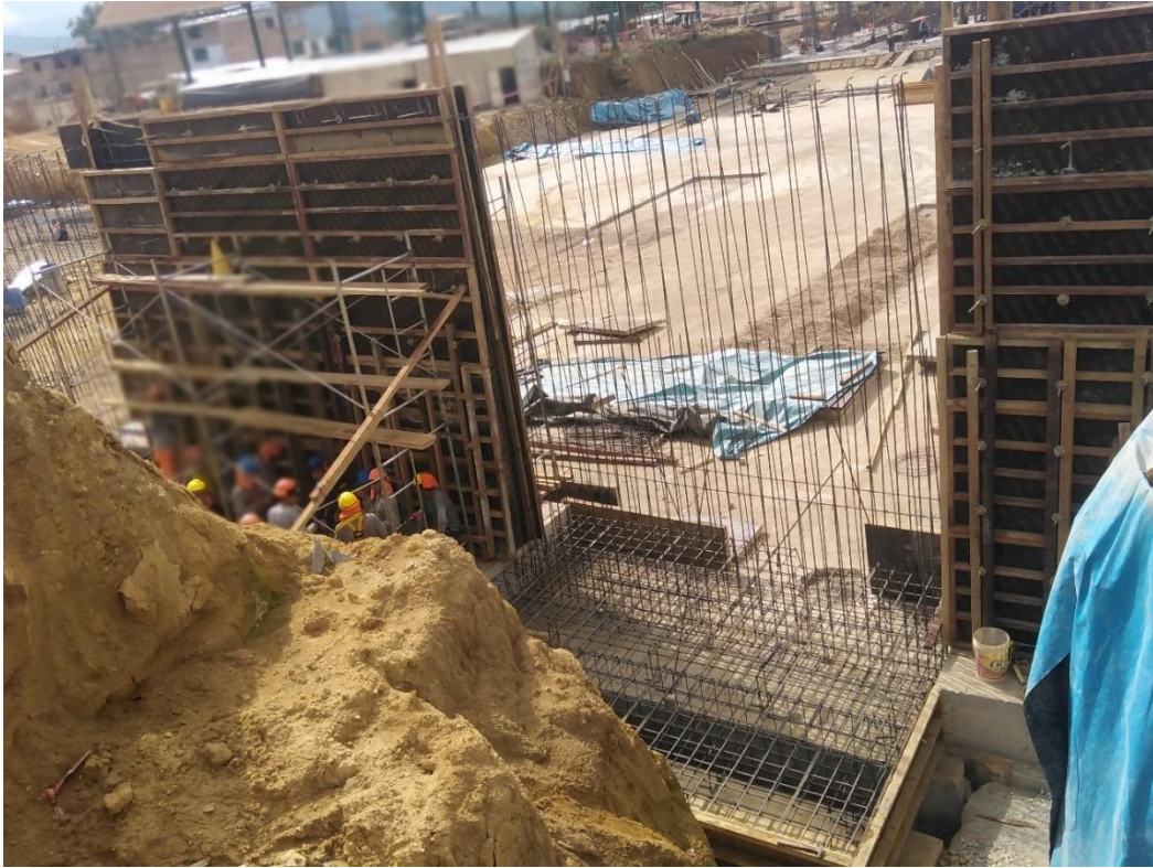
Figura 272: Acero de refuerzo en zapata muro MC-22.
