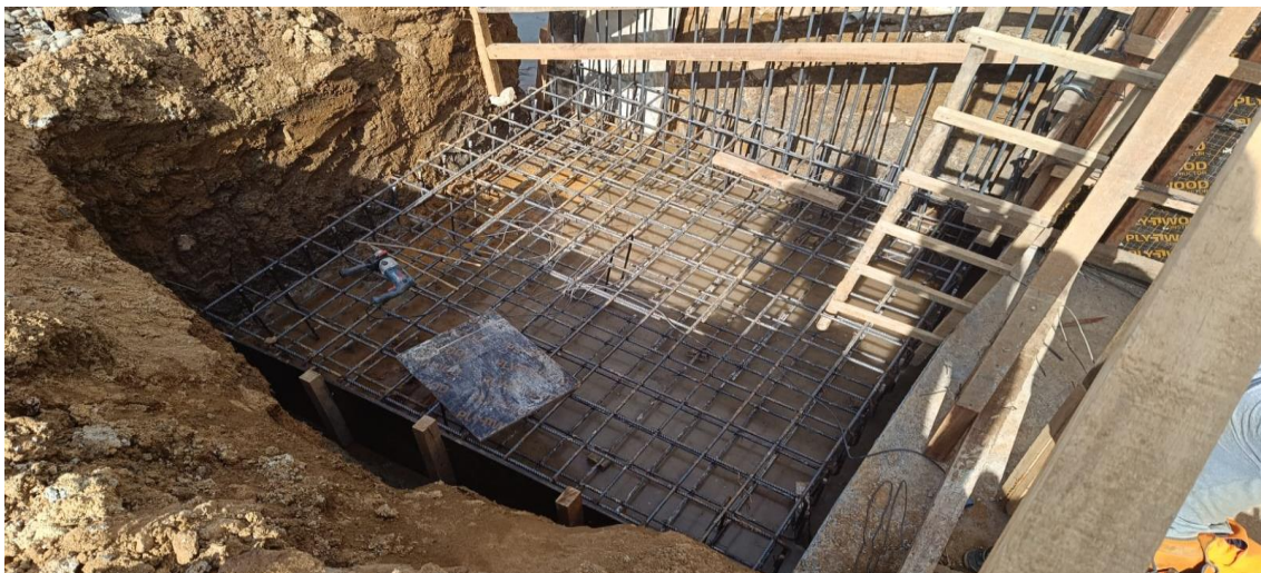
Figura 247: Acero en zapata de MC-10, vértice A8 y A9.
