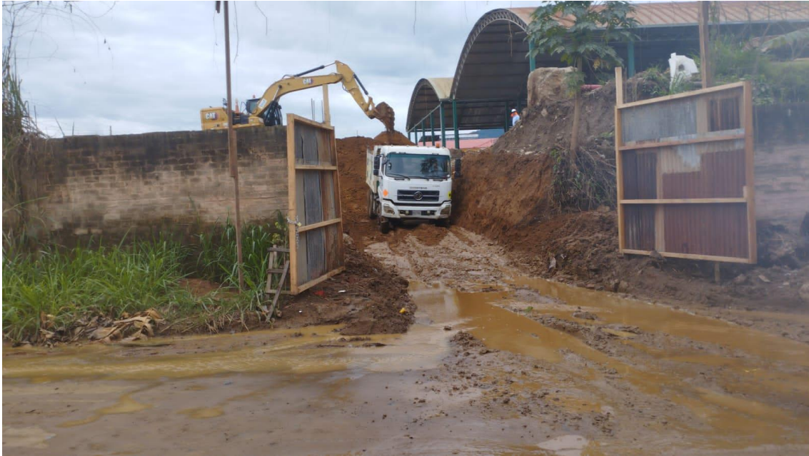
Figura 34: Acceso para movimiento de tierras – Av. Industrial.
