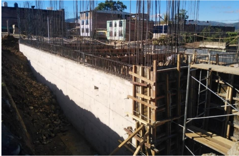
Figura 213: Encofrado de viga eje X – Bloque 11.
