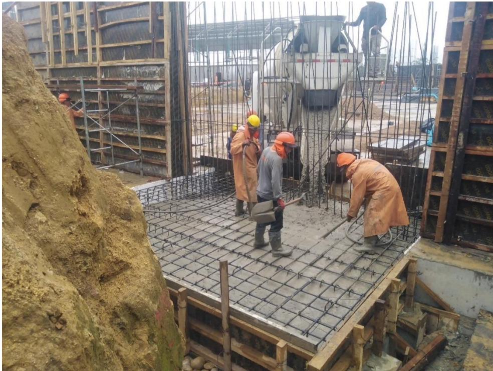
Figura 276: Armado de acero en pantalla de muro MC-22.
