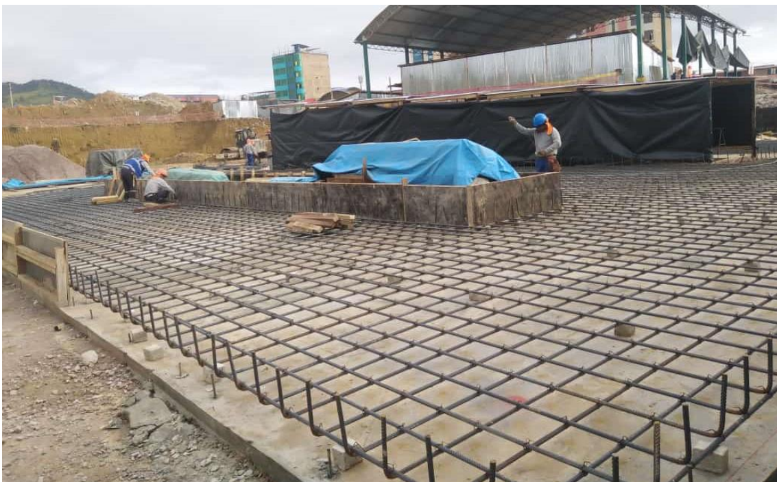
Figura 128: Armado de acero inferior en losa de cimentación – módulo 04.
