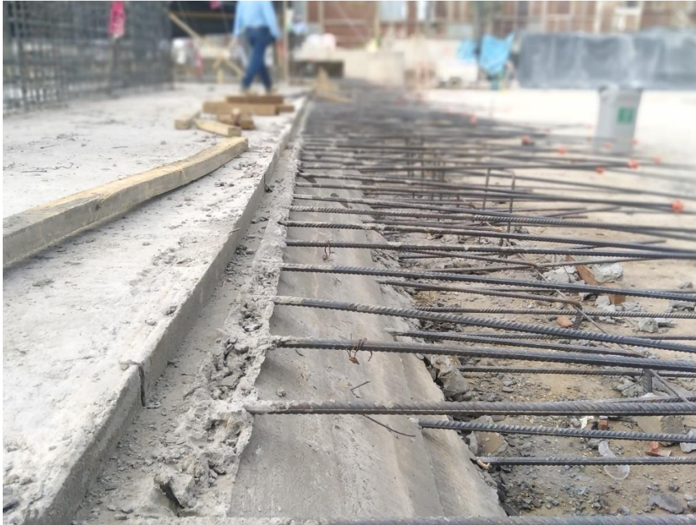
Figura 138: Colocación de nivel de vaciado de losa de cimentación módulo 4.
