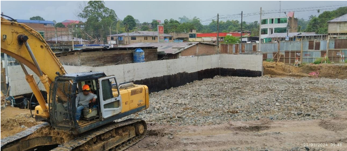
Figura 121: Colocación de material de préstamo – afirmado grueso.
