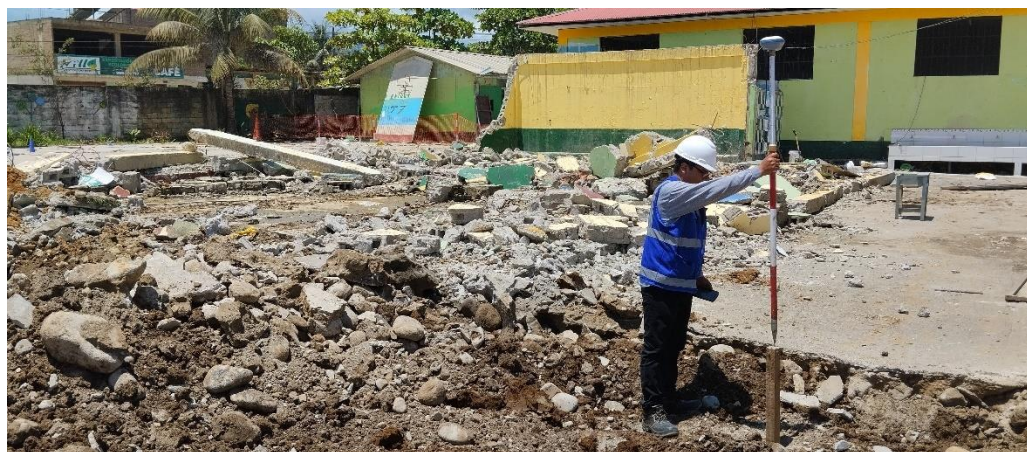
Figura 50: Colocación de estacas para demarcación de área de excavación.
