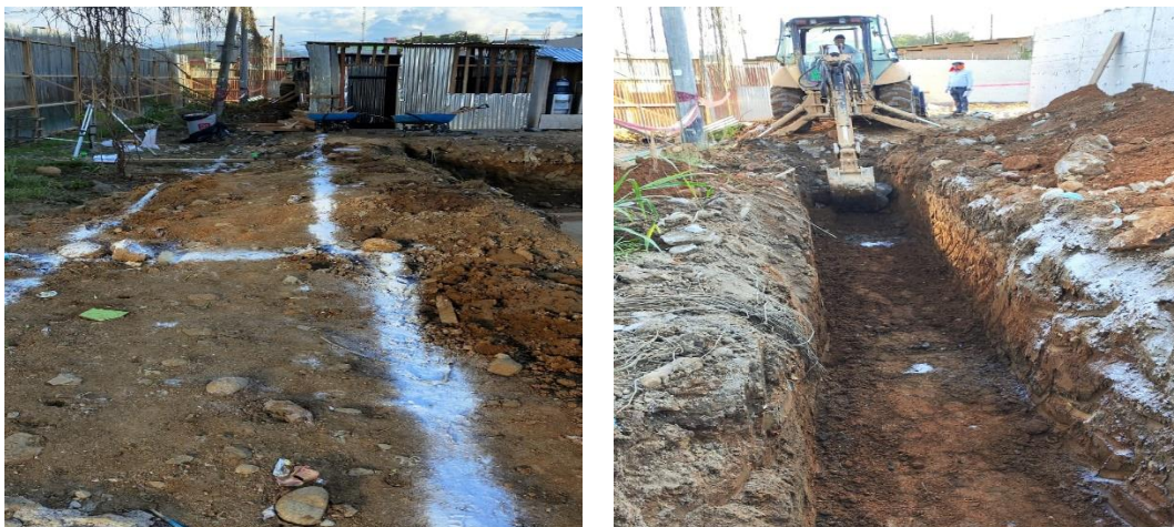
Figura 279: Trazo y excavación para muros MC-05d y MC-06f en Av. Industrial.
