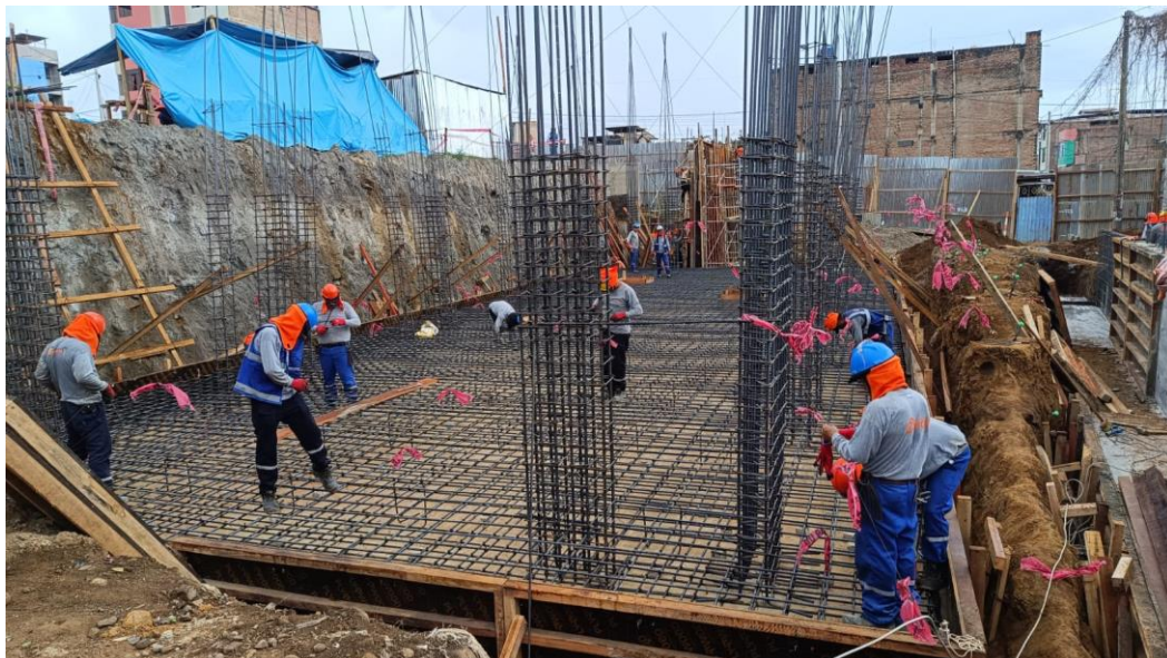
Figura 202: Encofrado de losa de cimentación – Bloque 11.
