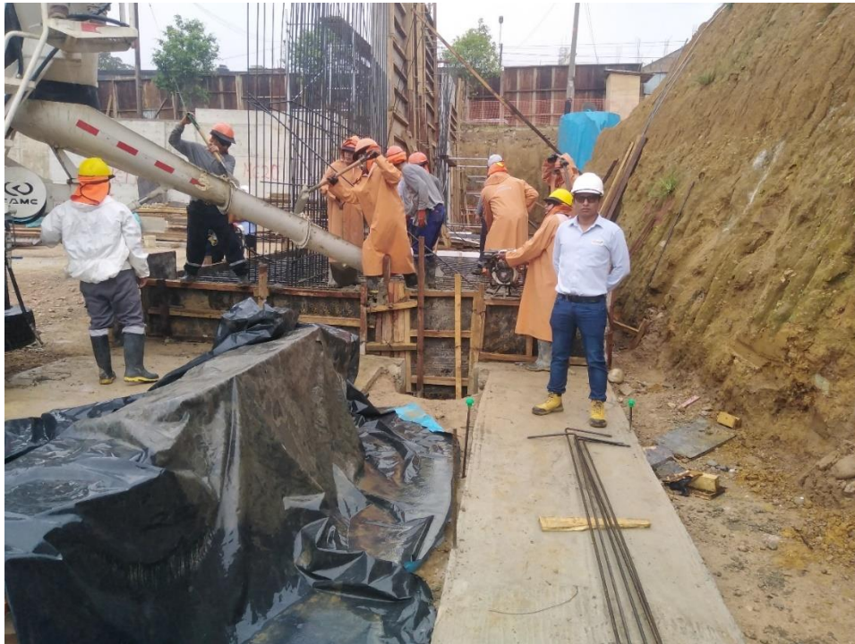
Figura 274: Concreto f'c=210 \text{ kg/cm}^2 para muro MC-22.
