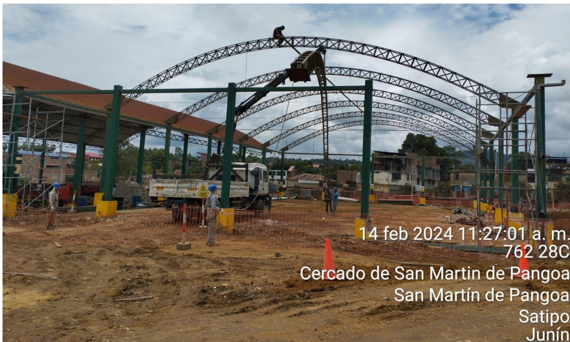
Figura 37: Desmontaje de cobertura en losa deportiva existente.
