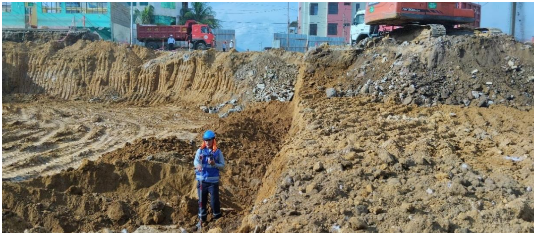
Figura 173: Trazo y replanteo de cimentación de rampa ubicada en bloque SUM.
