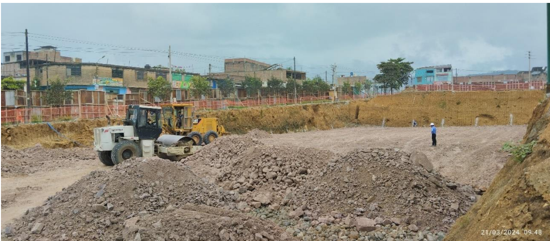
Figura 121: Colocación de material de préstamo – afirmado grueso.
