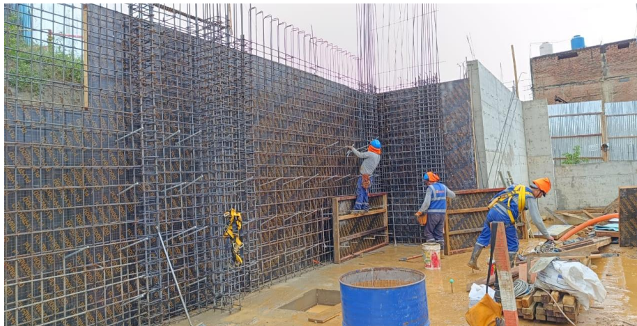
Figura 208: Armado de acero y encofrado de placas PL-02, PL-18 y muro sótano.
