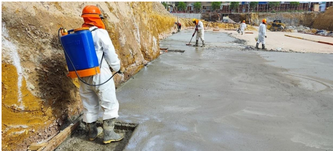
Figura 182: Curado de concreto en solado – módulo 09 y 10.
