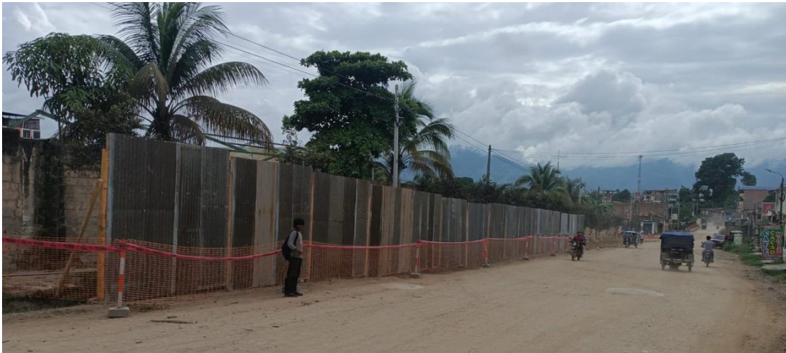
Figura 28: Cerco perimétrico – Calle Perene.
