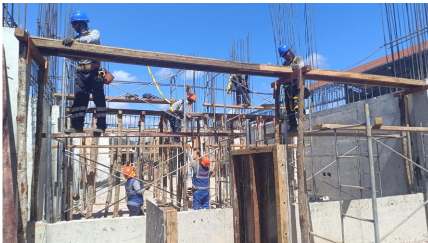
Figura 214: Encofrado de vigas eje Y – Bloque 11.
