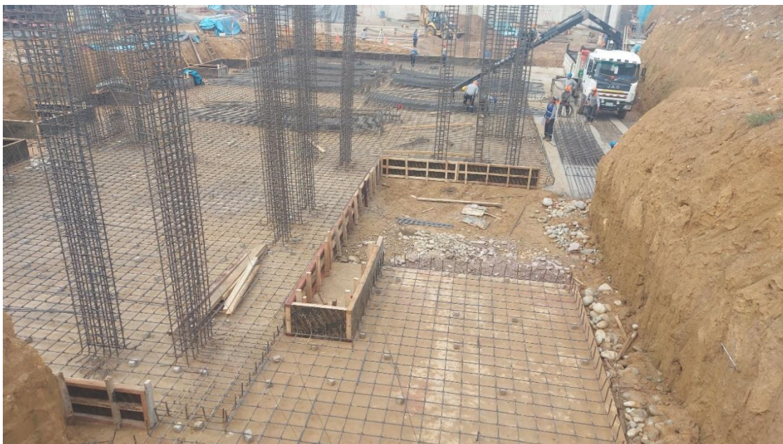
Figura 188: Encofrado losa de cimentación módulo 10.
