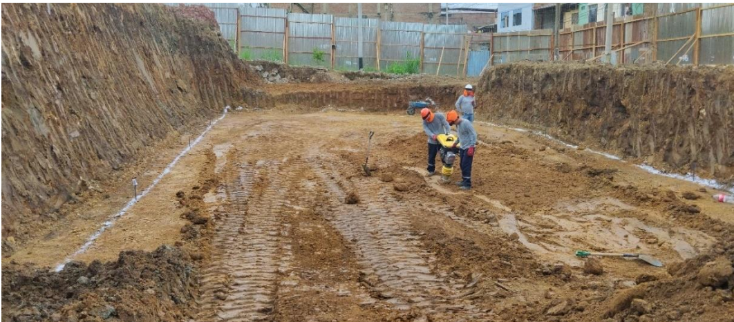
Figura 193: Conformación y compactación de material de préstamo OVER – B11.
