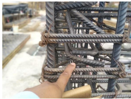
Figura 134: Verificación de armado de estribos y núcleos de confinamiento.
