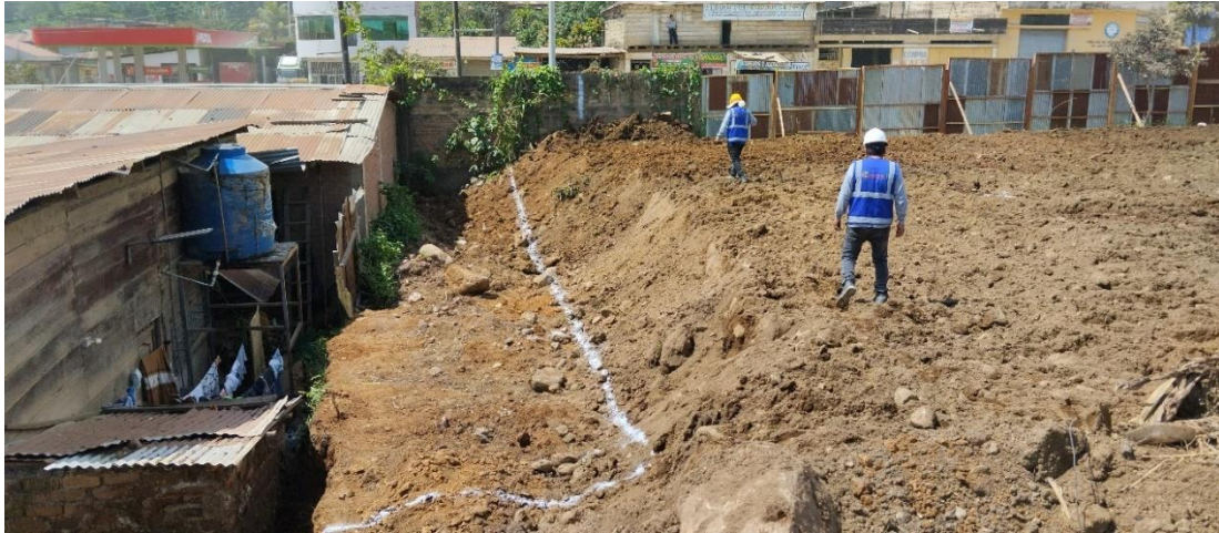
Figura 225: Excavación para la cimentación muro de contención vértice A7 y A8.
