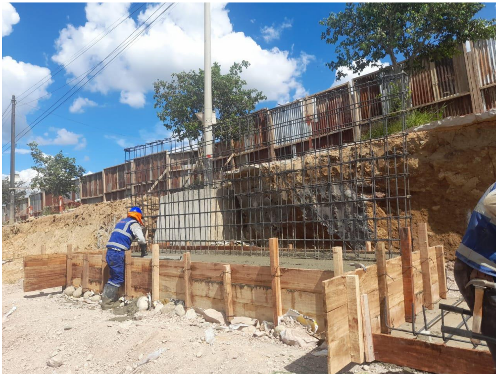
Figura 285: Armado de acero en muro MC-19, vértice A9-A10.
