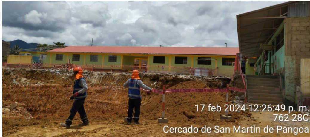
Figura 49: Infraestructura antigua (aulas de secundaria).
