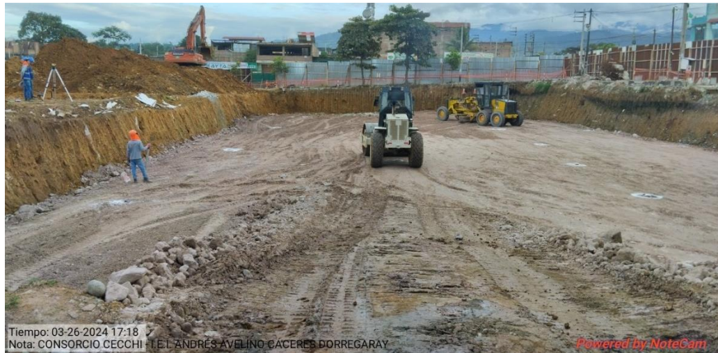
Figura 157: Conformación y compactación de material de préstamo fino.
