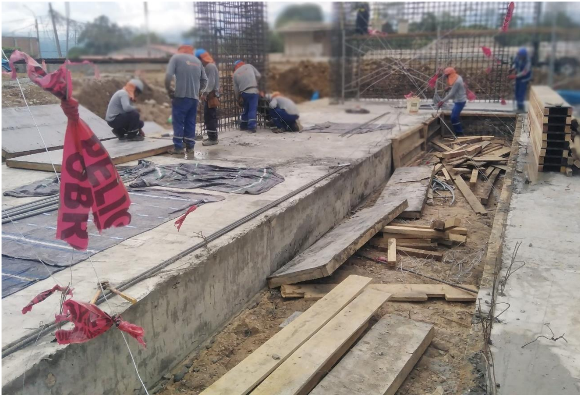
Figura 132: Junta fría generada por el vaciado de concreto losa de cimentación módulo 01.
