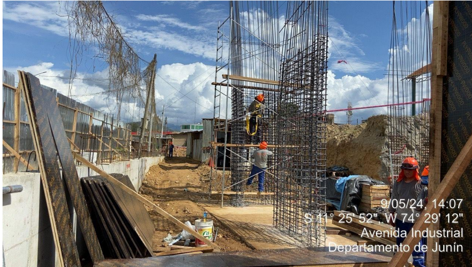
Figura 207: Encofrado de placas – Bloque 11.
