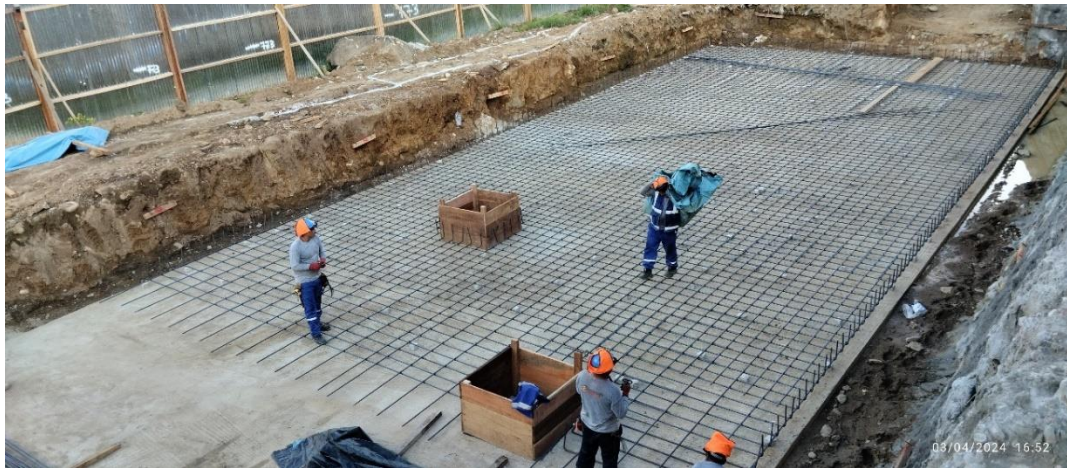
Figura 202: Encofrado de losa de cimentación – Bloque 11.
