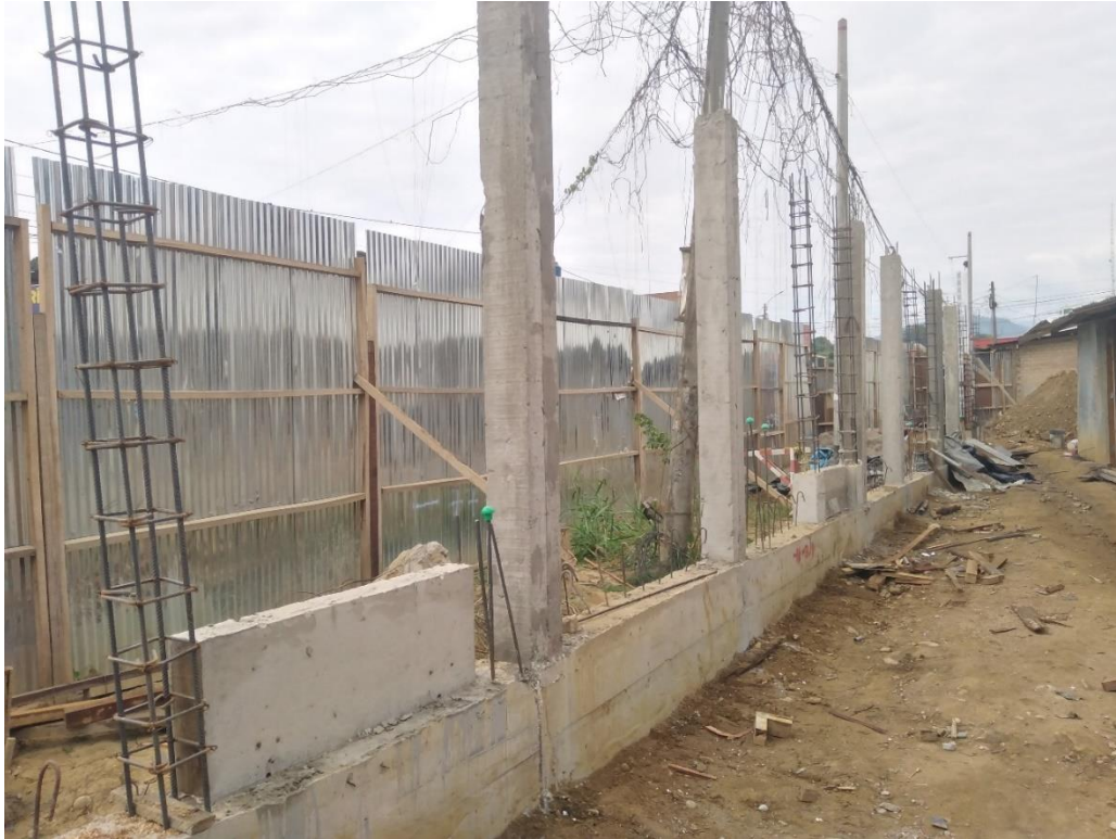
Figura 281: Encofrado de solado en muros MC-18 y MC-18ª, vértice A9-A10.
