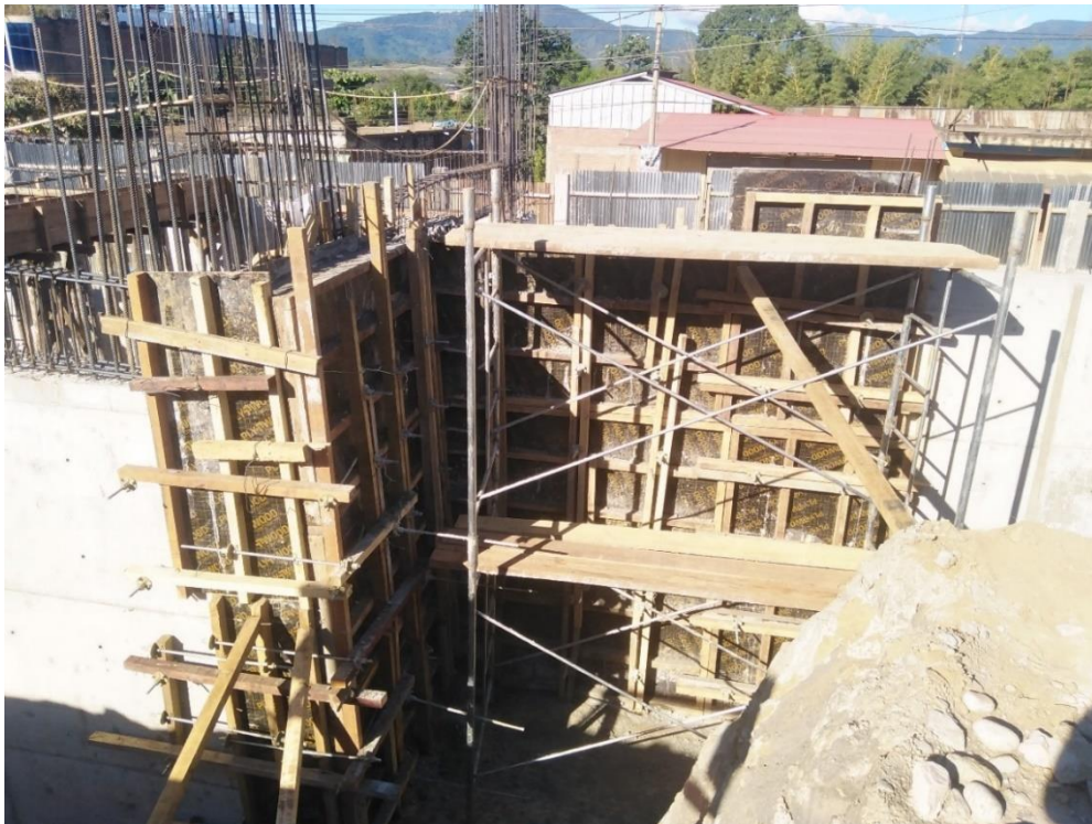
Figura 258: Encofrado y vaciado de concreto en pantalla de muros MC-08c bloque 11.
