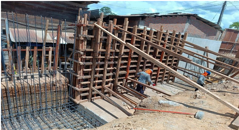
Figura 241: Encofrado de pantalla en muro MC-08, vértice A7 y A8.
