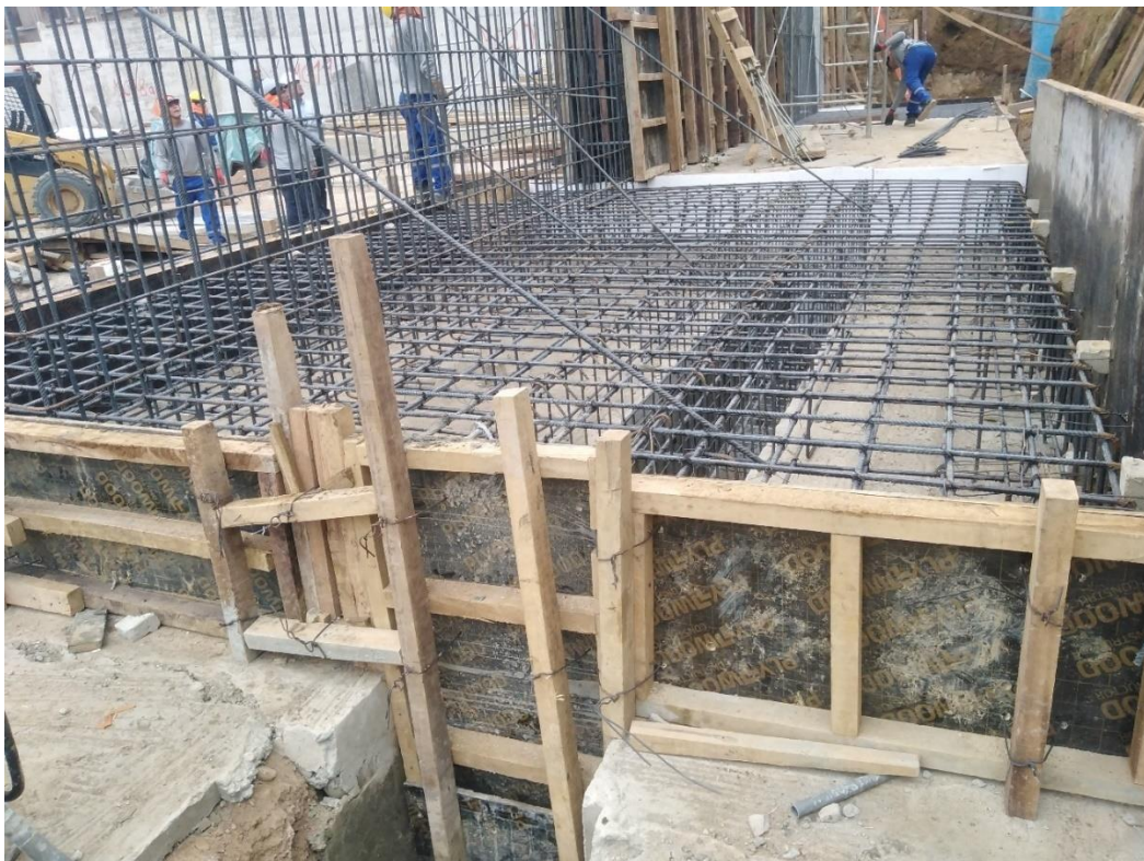
Figura 272: Acero de refuerzo en zapata muro MC-22.
