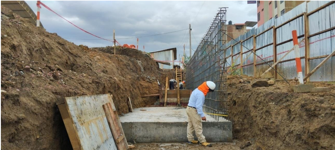
Figura 270: Encofrado en muro MC-10. Calle Perene.
