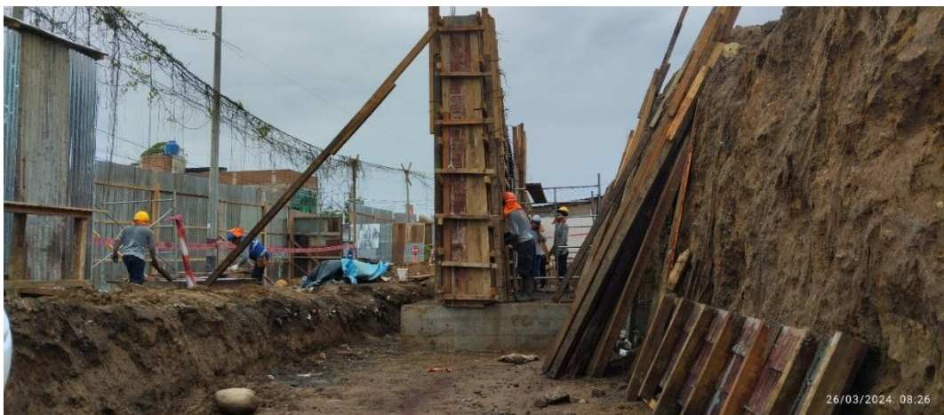
Figura 256: Verificación de trabajos de encofrado de pantalla de muros MC-08 bloque 11.
