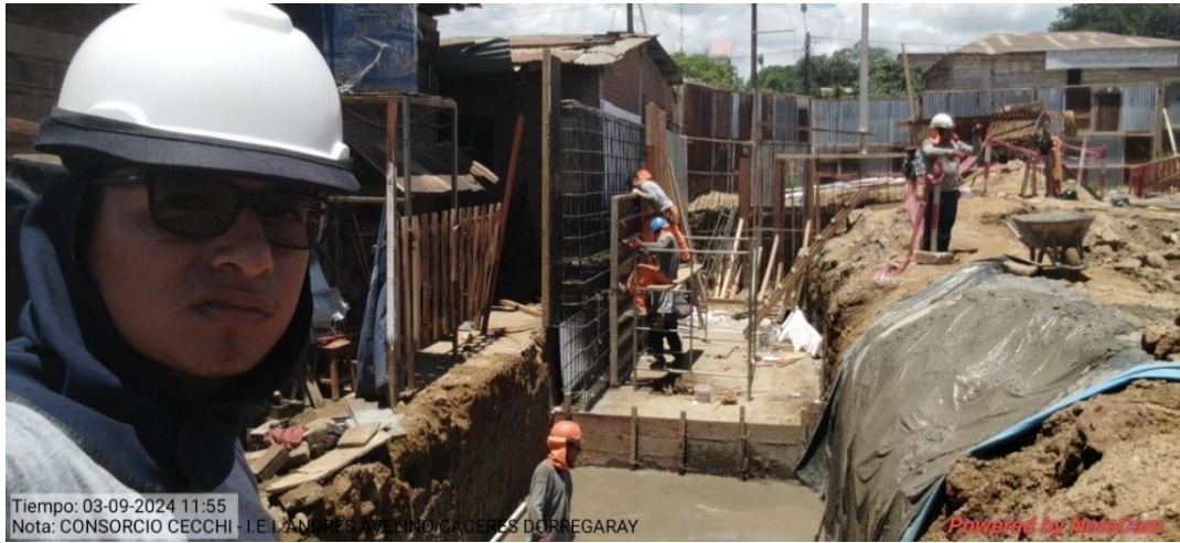
Figura 237: Vaciado de concreto MC-08a, vértice A6 y A7.
