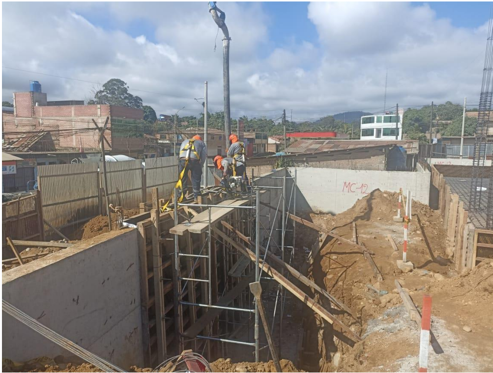
Figura 258: Encofrado y vaciado de concreto en pantalla de muros MC-08c bloque 11.
