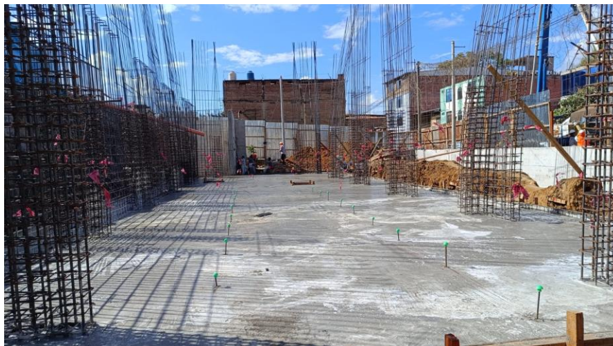
Figura 205: Concreto f'c=280 \text{ kg/cm}^2 en el Bloque 11 – Servicios.
