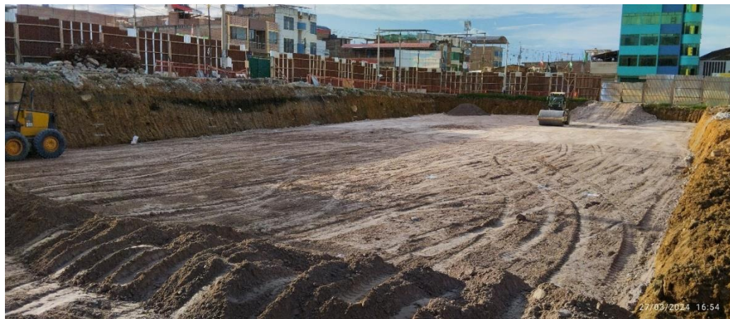
Figura 157: Conformación y compactación de material de préstamo fino.
