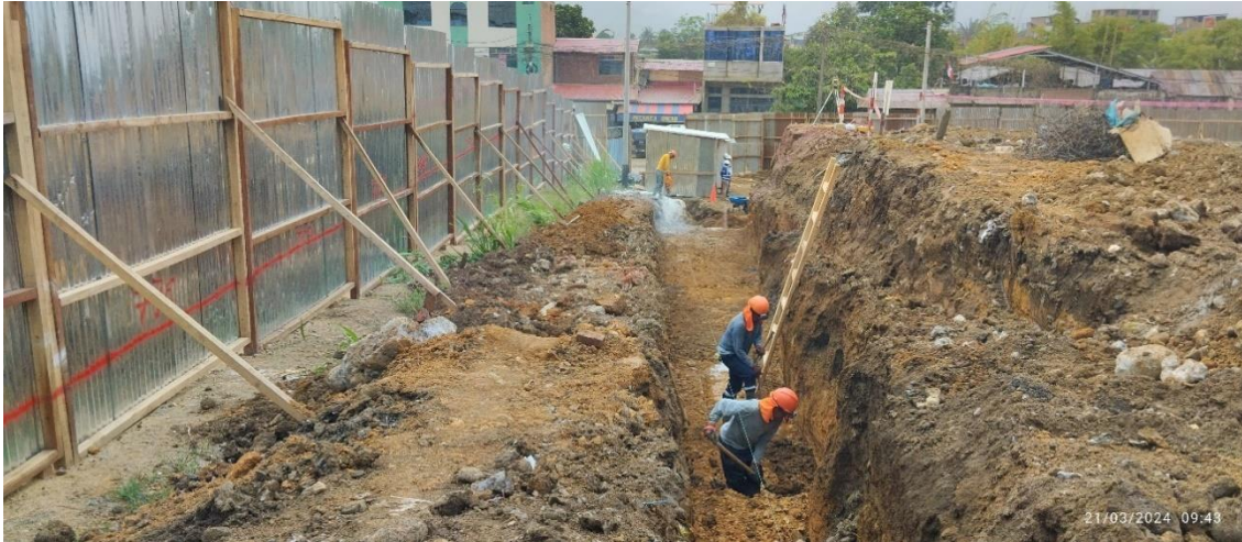
Figura 266: Vaciado de concreto en muros de contención – Calle Perene.
