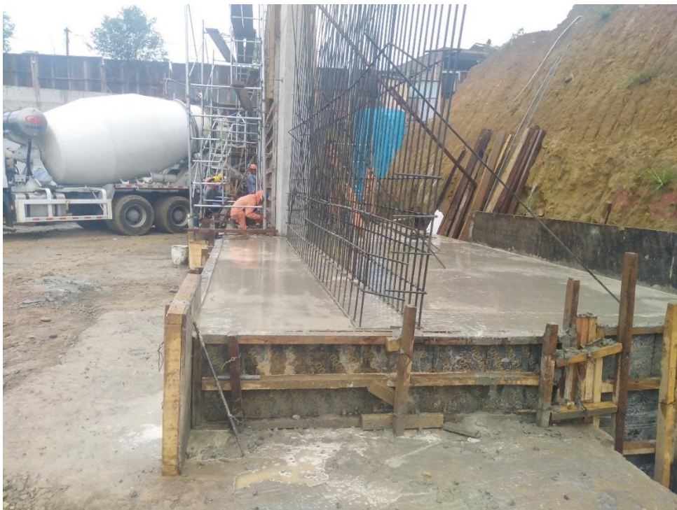
Figura 274: Concreto f'c=210 \text{ kg/cm}^2 para muro MC-22.
