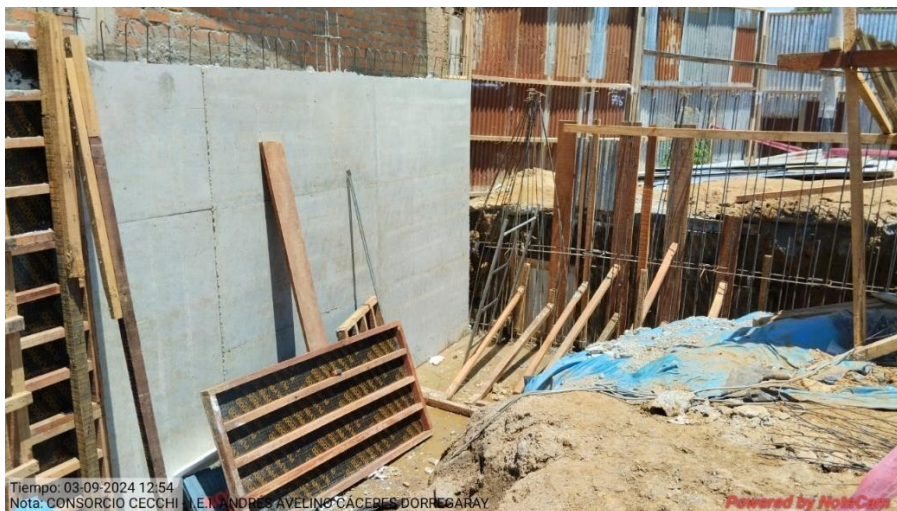
Figura 232: Desencofrado muro MC-08.
