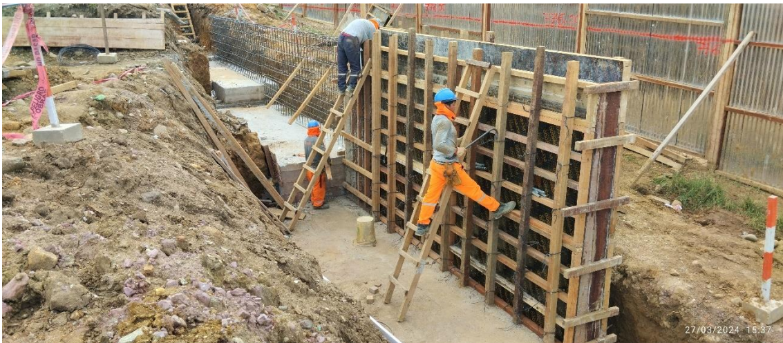
Figura 270: Encofrado en muro MC-10. Calle Perene.
