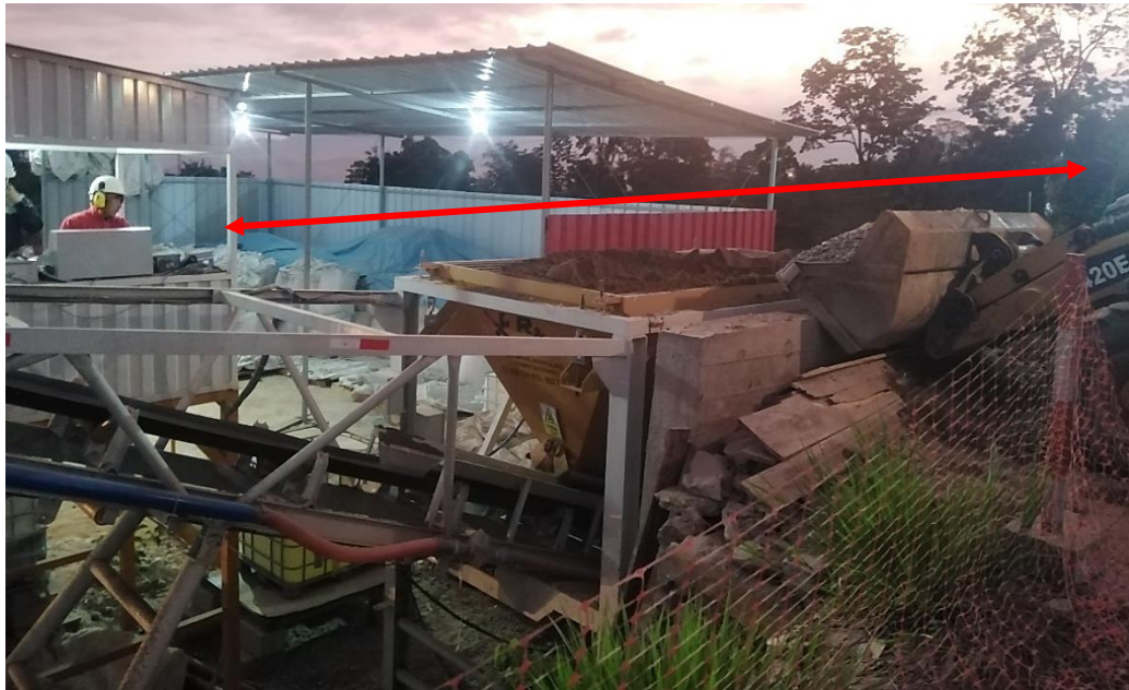
Figura 97: Operador dando indicaciones al operador encargado de los áridos.
