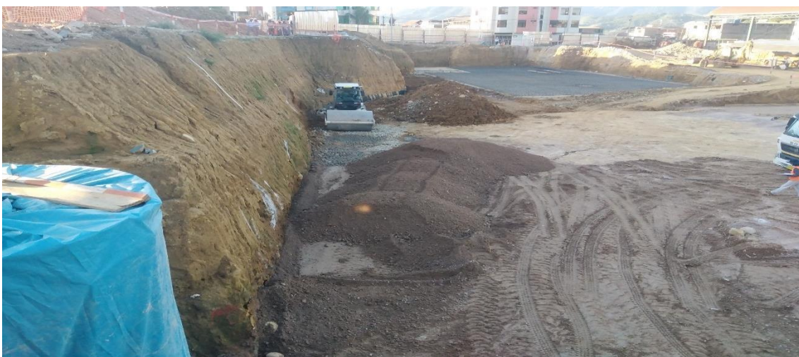
Figura 110: Conformación y compactación del tramo B.
