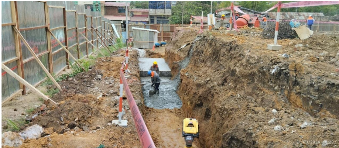
Figura 267: Vaciado de concreto en muros de contención MC-03 a – Calle Perene.
