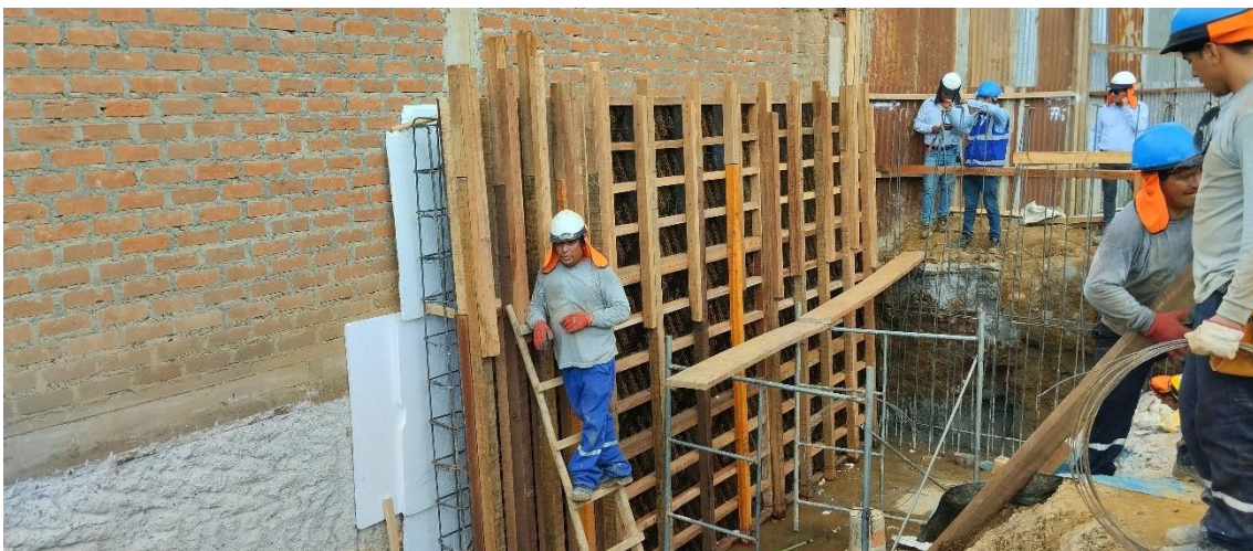
Figura 229: Encofrado de pantalla de muro MC-08.
