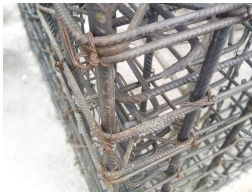
Figura 134: Verificación de armado de estribos y núcleos de confinamiento.
