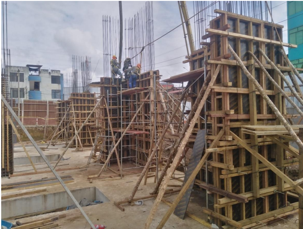
Figura 170: Verificación durante los trabajos de vaciado de concreto en placas – módulo 08.
