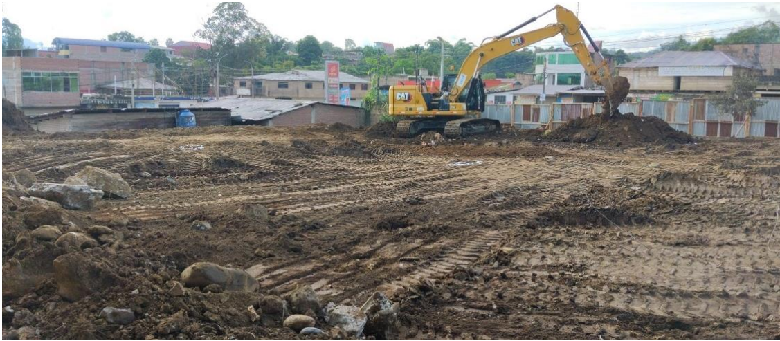
Figura 70: Excavación de plataforma 02 – losa deportiva.
