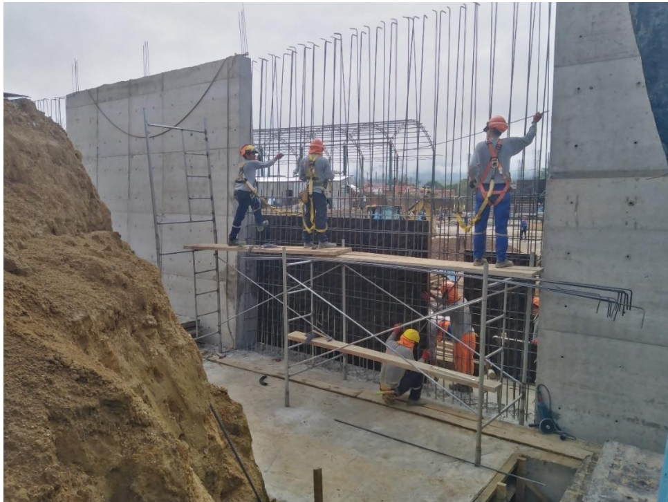
Figura 276: Armado de acero en pantalla de muro MC-22.
