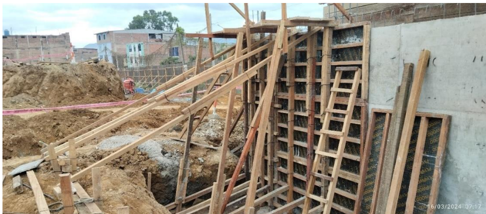
Figura 241: Encofrado de pantalla en muro MC-08, vértice A7 y A8.
