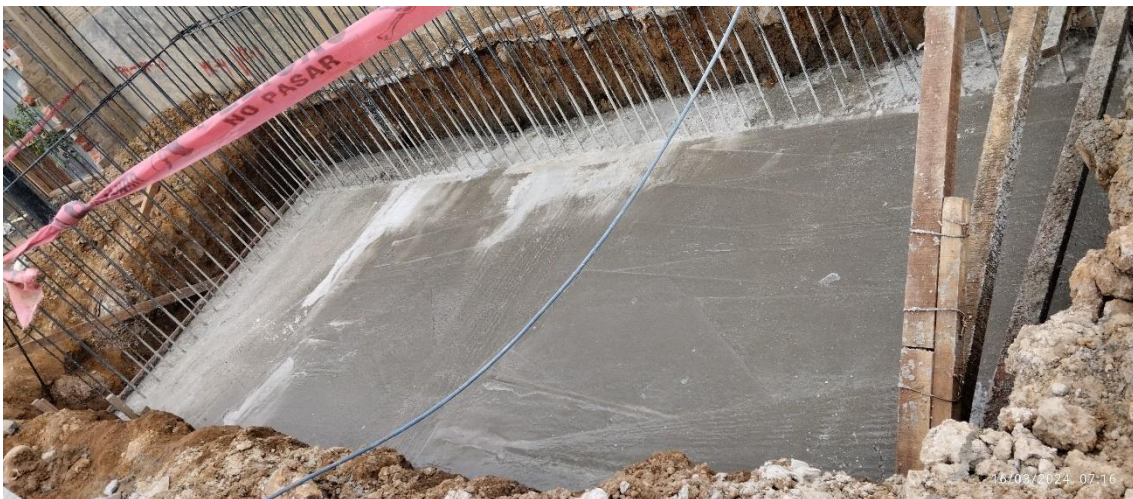
Figura 244: Concreto f'c=210 \text{ kg/cm}^2 en MC-08, vértice A8 y A9.
