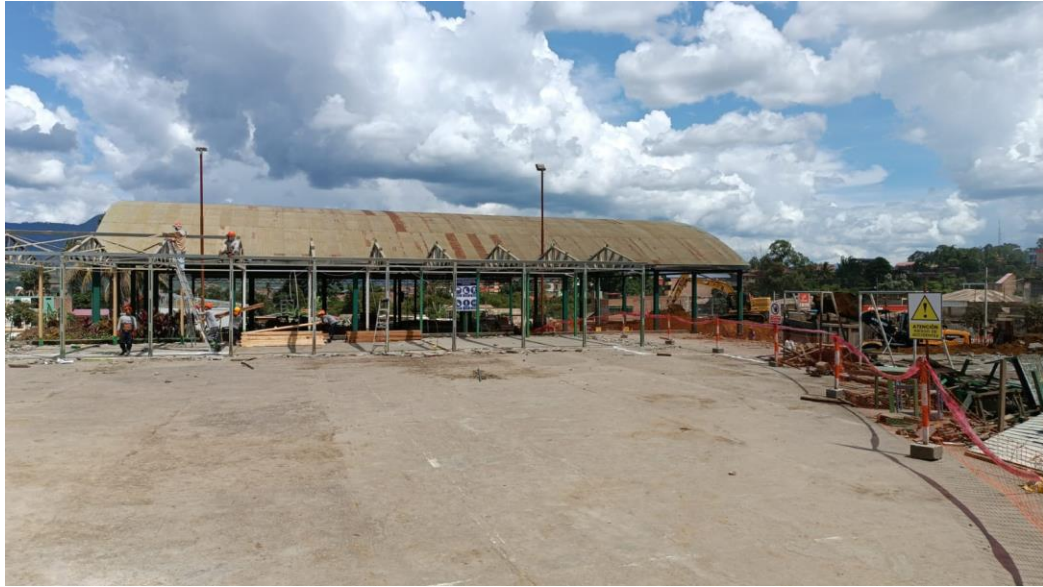
Figura 56: Desmontaje de aulas prefabricadas de primaria – plataforma 01.
