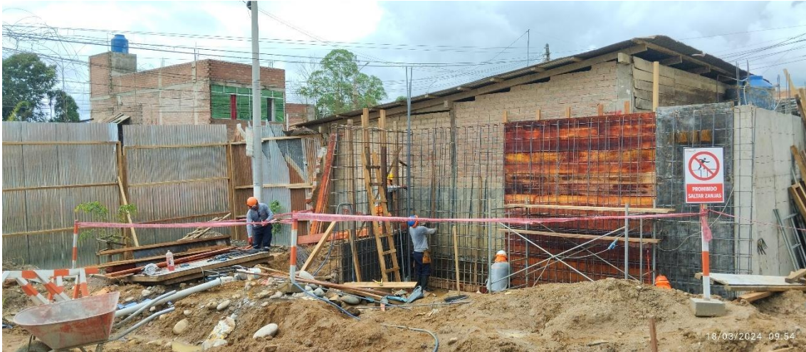
Figura 246: Vista general de muros de contención vértices A7 – A8 y A8-A9.
