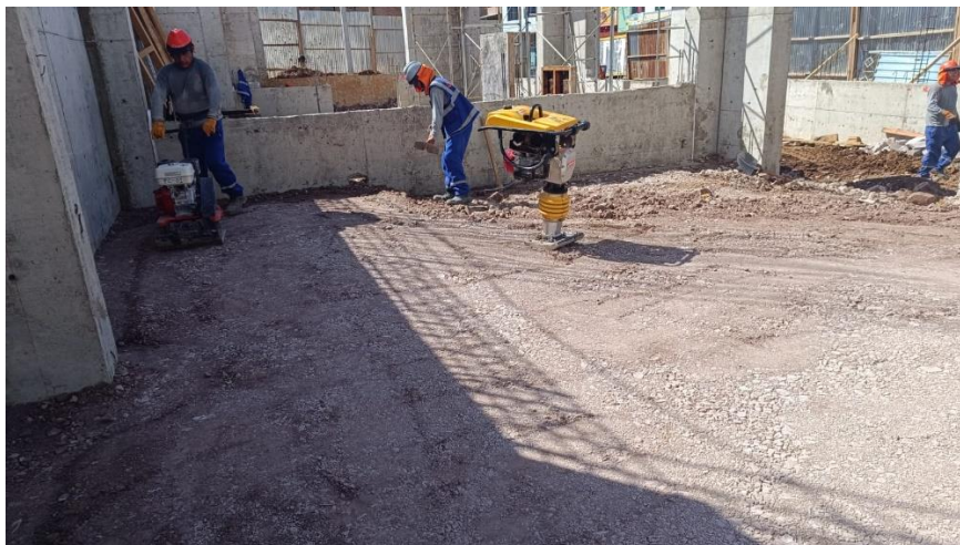
Figura 217: Conformación y compactación para falso piso – Bloque 11.
