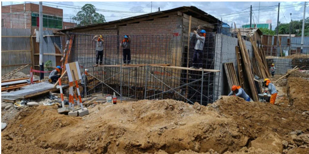
Figura 235: Armado de acero en zapata MC-08, vértice A6 y A7.
