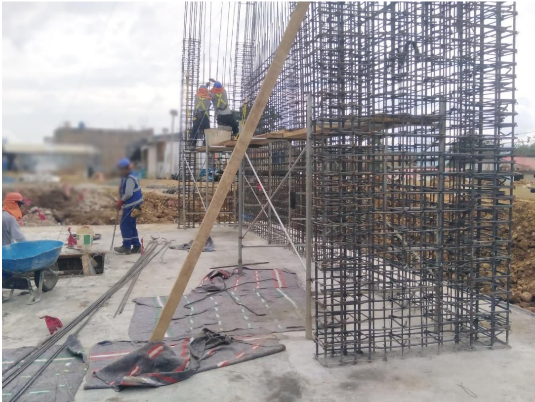
Figura 134: Verificación de armado de estribos y núcleos de confinamiento.
