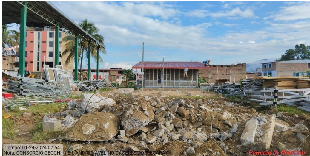
Figura 54: Demolición de servicios higiénicos.
