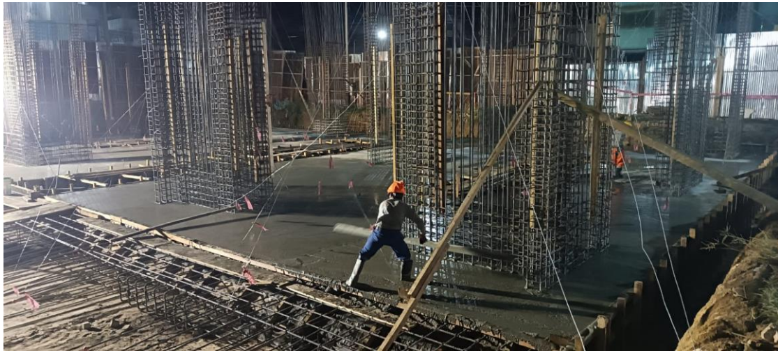
Figura 164: Desencofrado losa de cimentación – bloque secundaria módulo 08.
