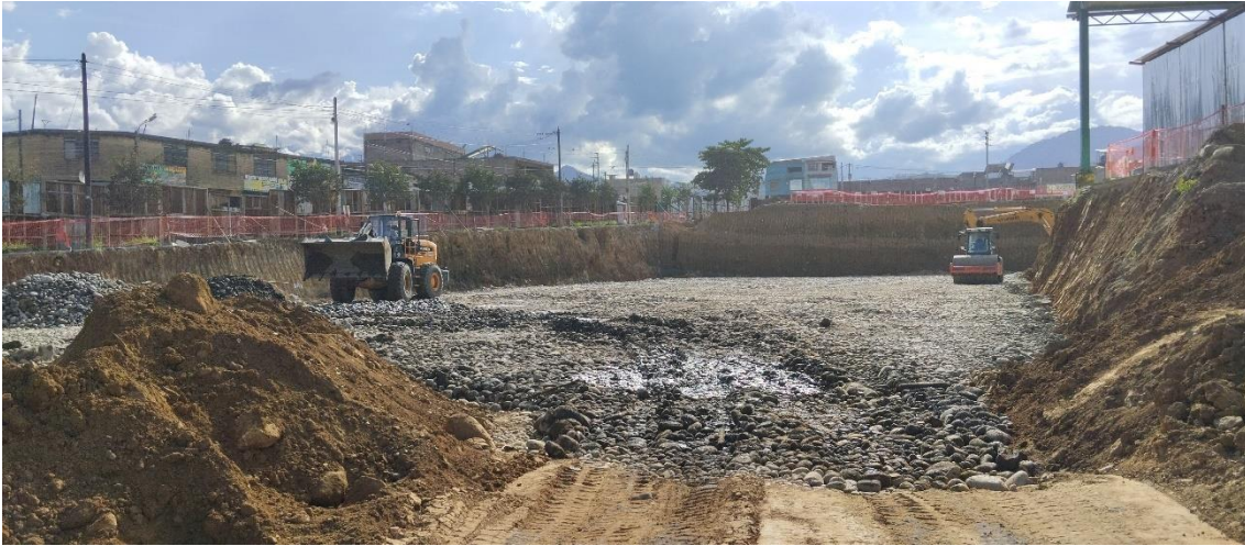
Figura 120: Colocación de material de préstamo – OVER.
