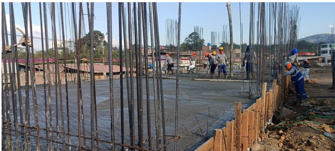
Figura 220: Concreto f'c=280 \text{ kg/cm}^2 – Bloque 11.
