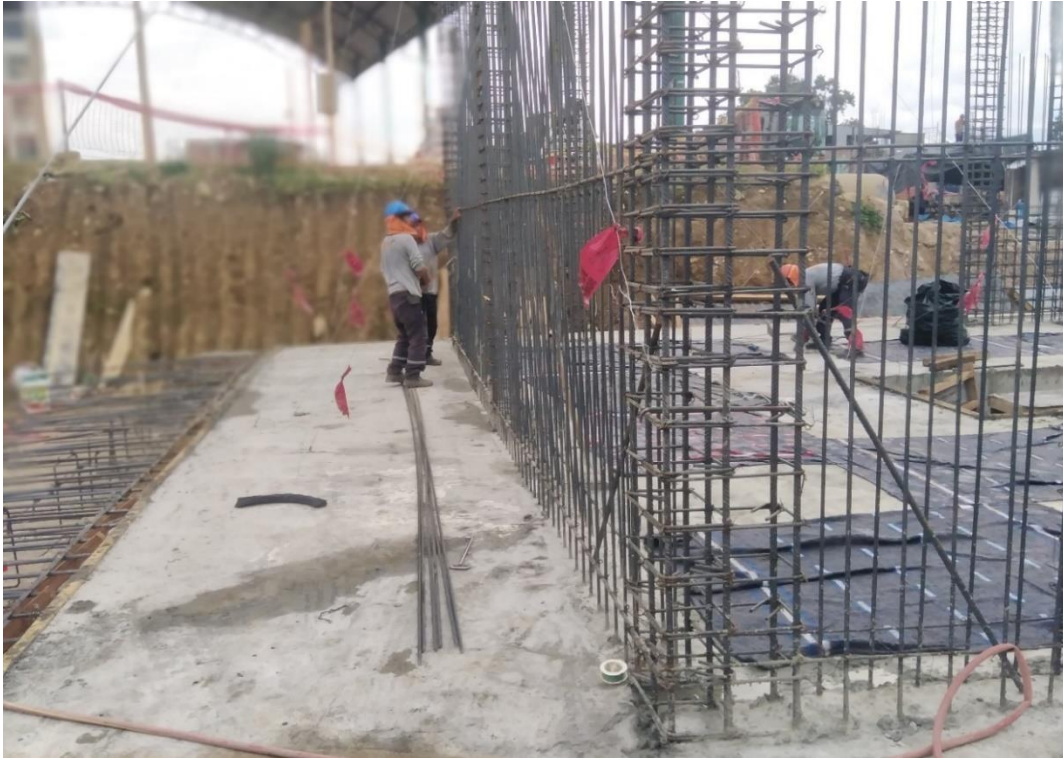
Figura 136: Encofrado para separación de losa de cimentación módulo 2 y 4.
