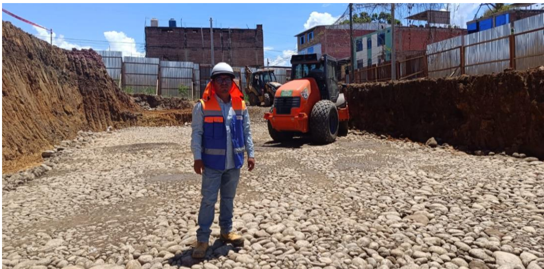
Figura 193: Conformación y compactación de material de préstamo OVER – B11.
