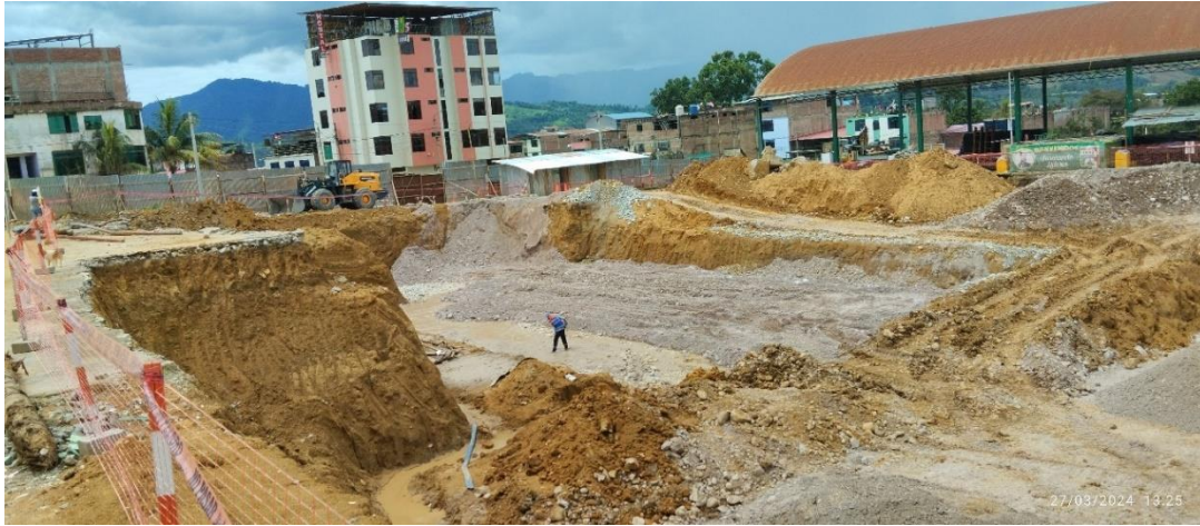
Figura 178: Compactación de material de préstamo fino bloque SUM.
