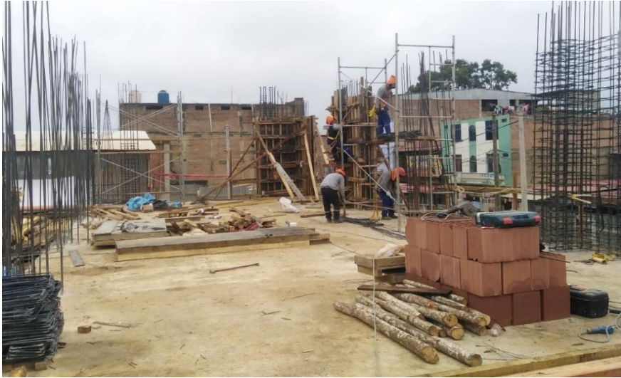
Figura 222: Vaciado de concreto en placas PL-02 y PL-18 en el bloque 11.
