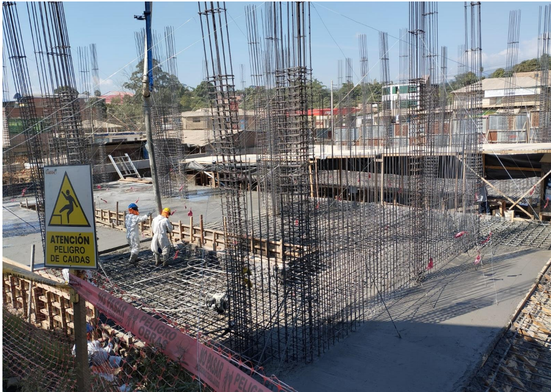
Figura 142: Curado de concreto en losa de cimentación módulo 4.
