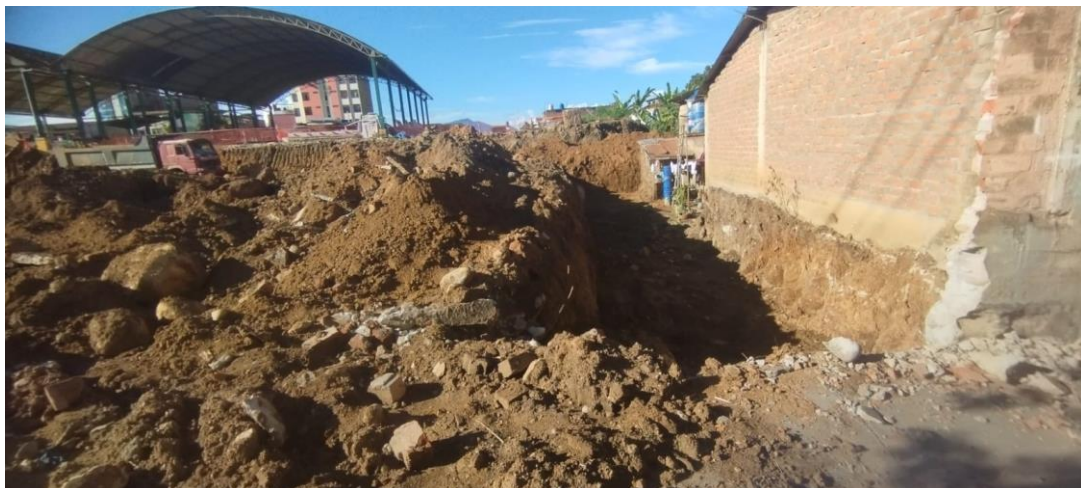
Figura 226: Zanja para zapatas muro de contención vértice A7 y A8.
