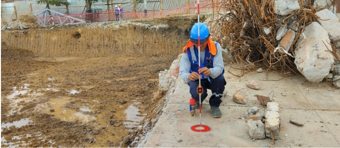
Figura 153: Nivelación de fondo de nivel de mejoramiento de suelo - Secundaria.
