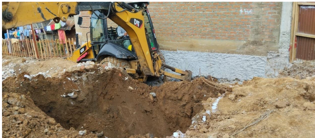
Figura 226: Zanja para zapatas muro de contención vértice A7 y A8.
