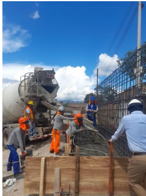
Figura 283: Vaciado de concreto en zapatas de muros MC-18 y MC-18 a , vértice A9-A10.
