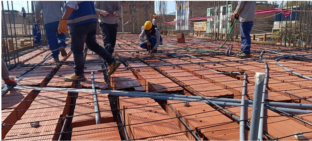
Figura 219: Vaciado de concreto en techo – Bloque 11.
