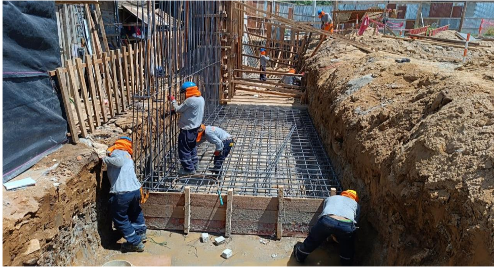
Figura 240: Encofrado de pantalla en zapata de MC-08, vértice A7 y A8.
