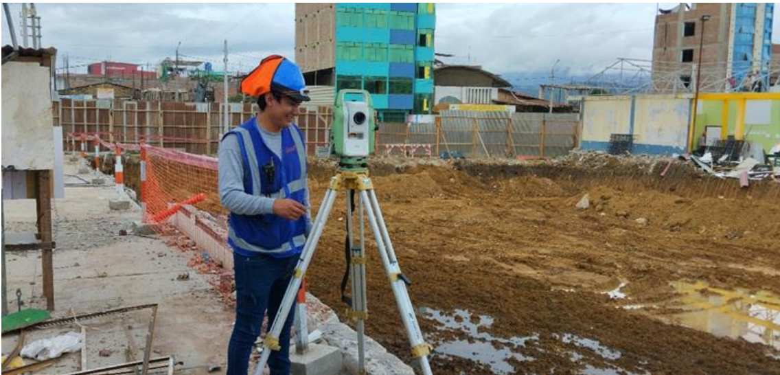
Figura 105: Levantamiento topográfico para elaboración de planos de adición de Obra N°01.
