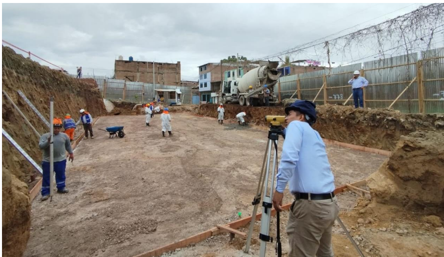
Figura 199: Vaciado de concreto en solado – Bloque 11.
