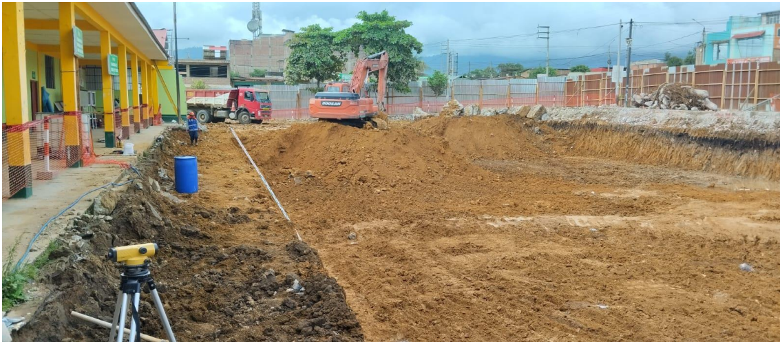
Figura 62: Asistente de campo realizando el control de excavación a nivel de fundación bloque 11: Servicios.
