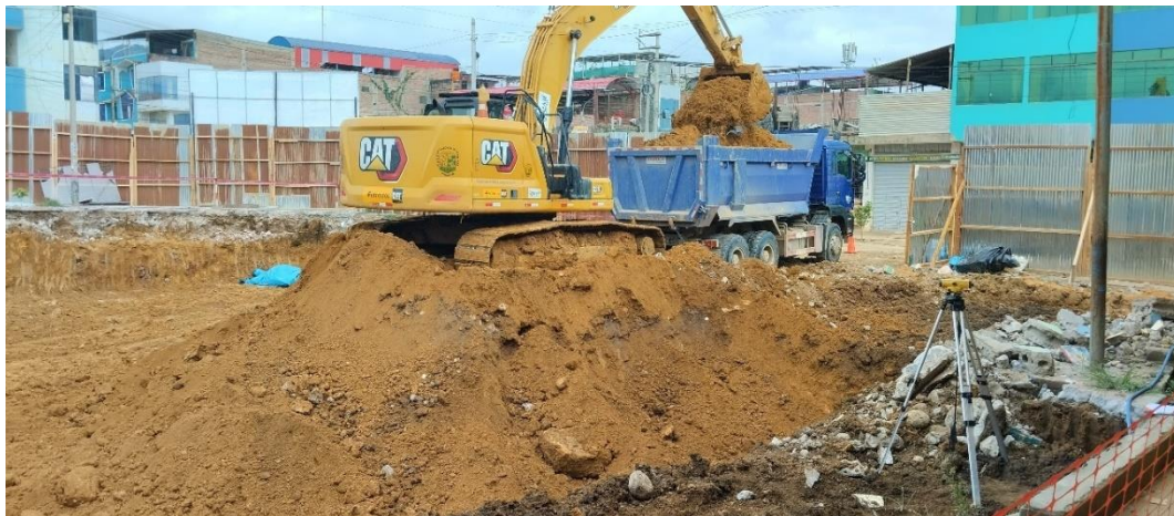
Figura 151: Colocación de puntos de control en excavaciones bloque secundaria.
