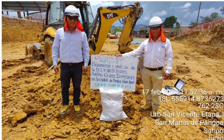
Figura 79: Verificación de los trabajos de excavación y muestreo de calicatas.
