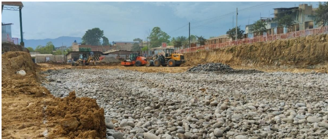
Figura 118: Colocación de material de préstamo – OVER.
