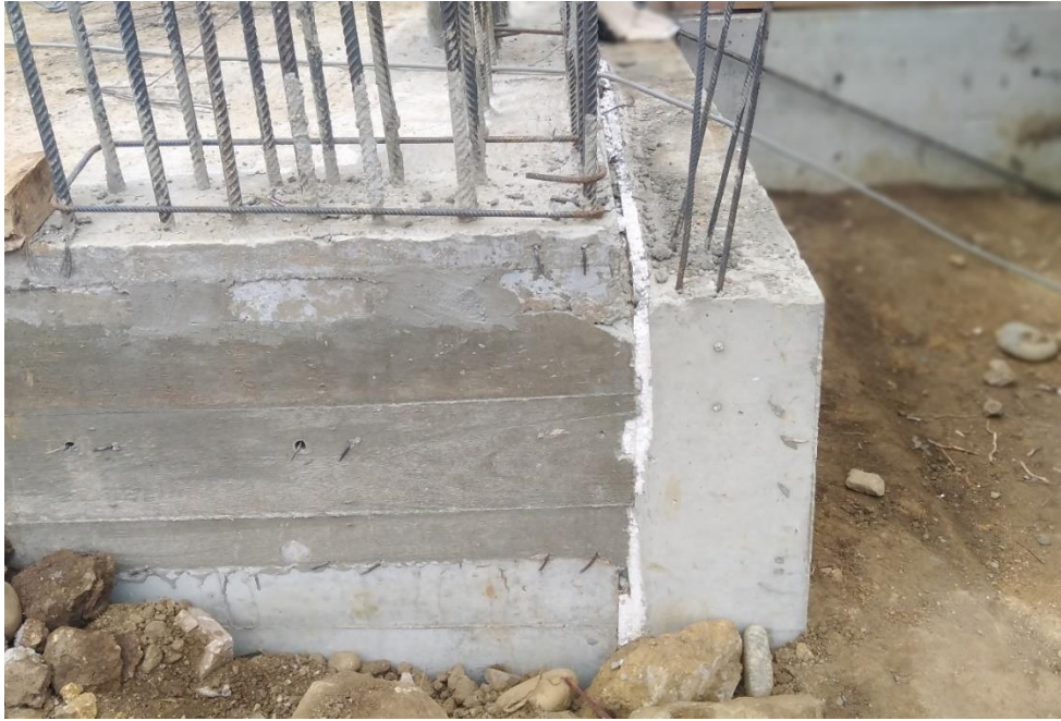
Figura 260: Armado de acero en zapata de muro MC-09a.
