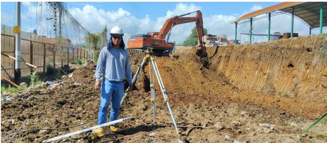
Figura 62: Asistente de campo realizando el control de excavación a nivel de fundación bloque 11: Servicios.
