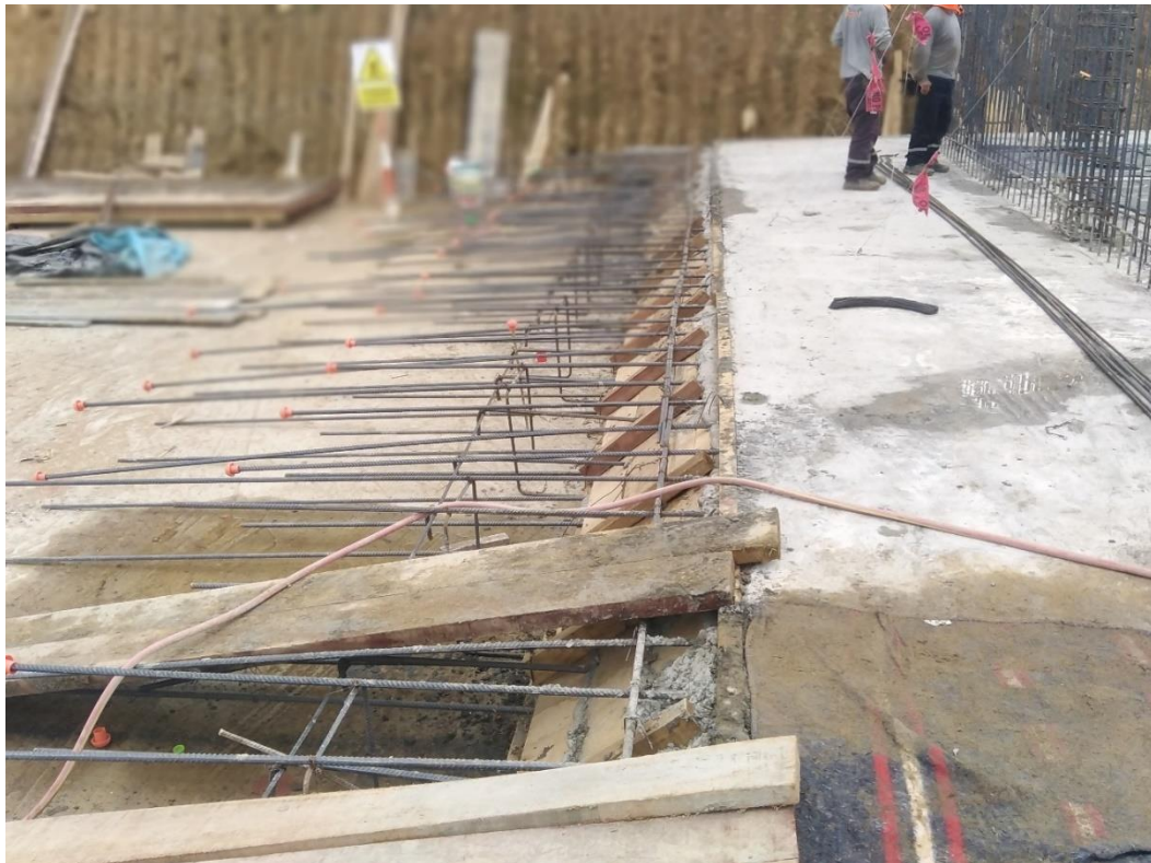
Figura 136: Encofrado para separación de losa de cimentación módulo 2 y 4.
