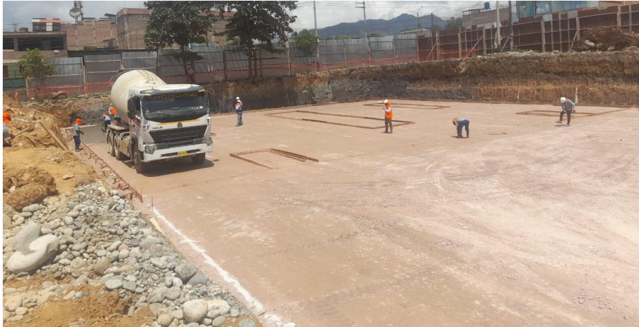
Figura 159: Vaciado de concreto en solado bloque secundaria – M5.
