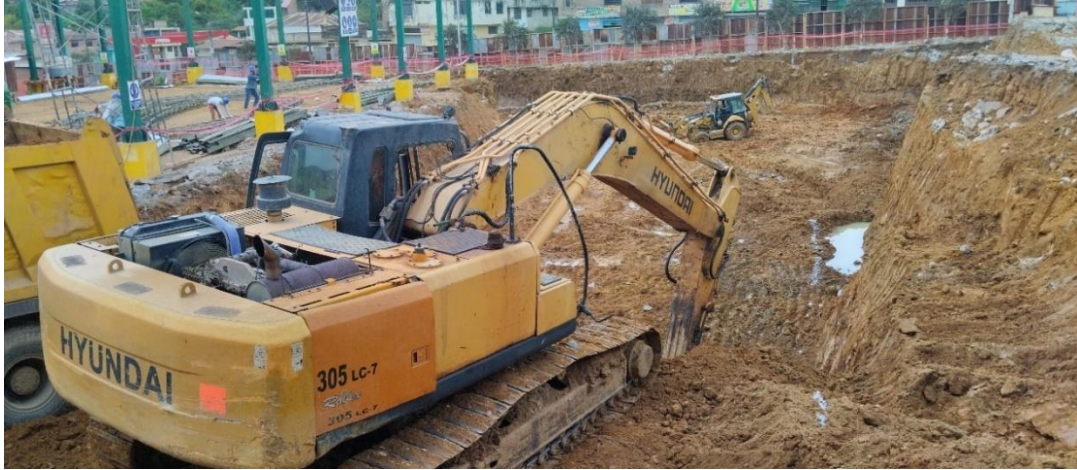
Figura 172: Trazo de área de excavación bloque SUM.
