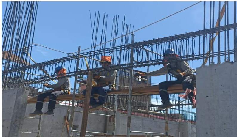
Figura 211: Armado de acero en vigas – Bloque 11.
