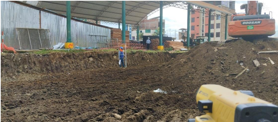
Figura 71: Trazo de área de corte plataforma 02 – MC-20.
