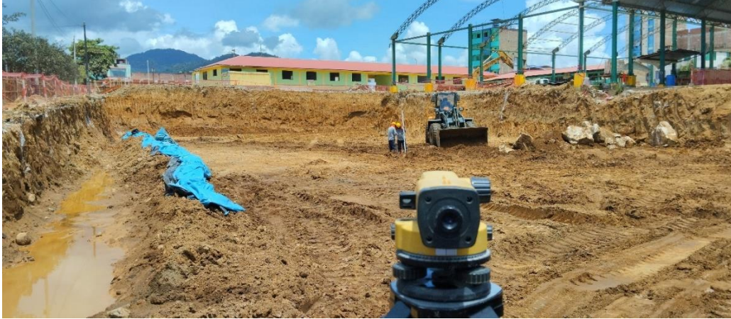
Figura 117: Nivelación del fondo del nivel de mejoramiento de suelo de fundación.
