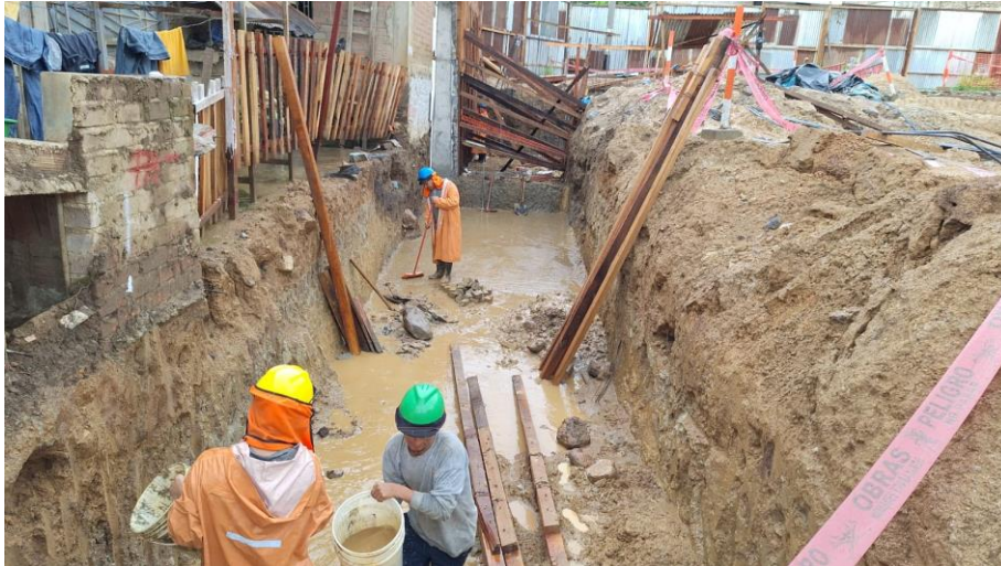
Figura 231: Vaciado de solado muro MC-08.
