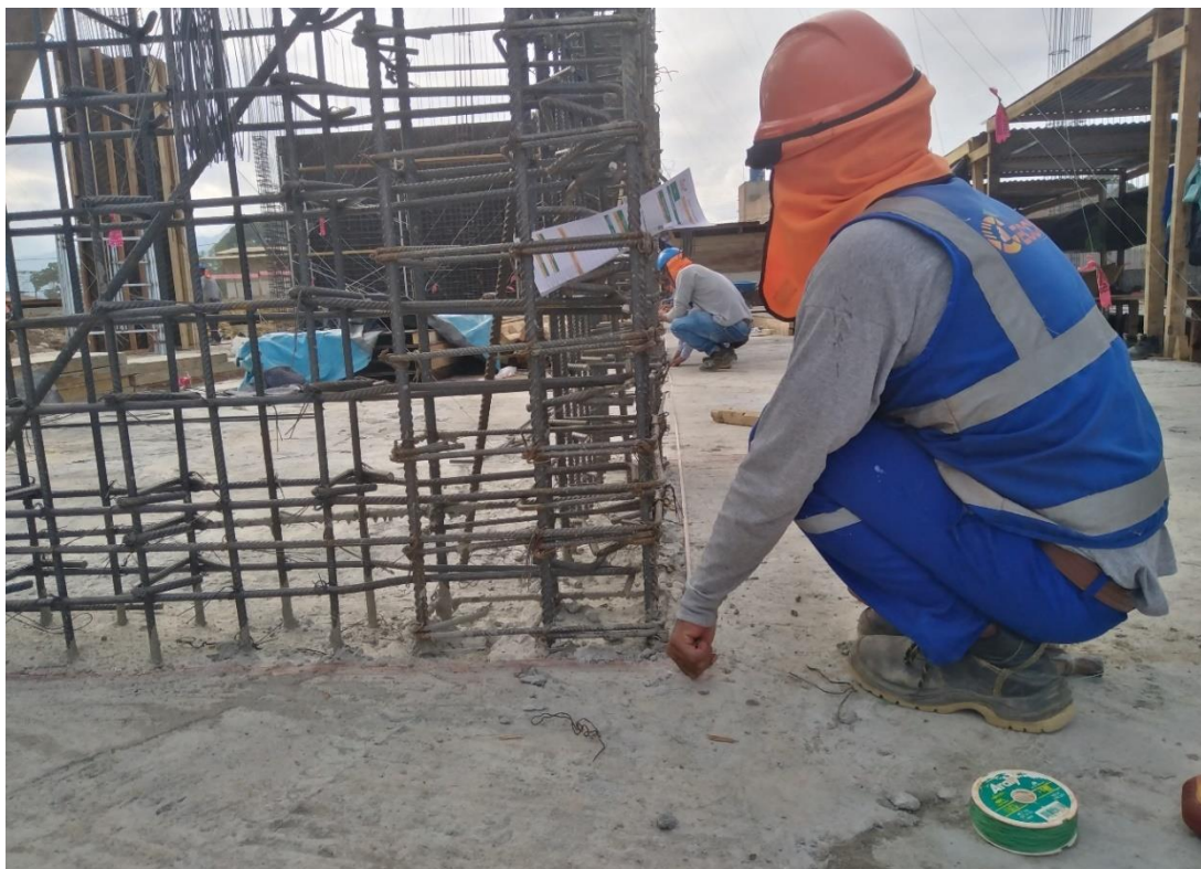
Figura 144: Trazo para encofrado en placas módulo 4.
