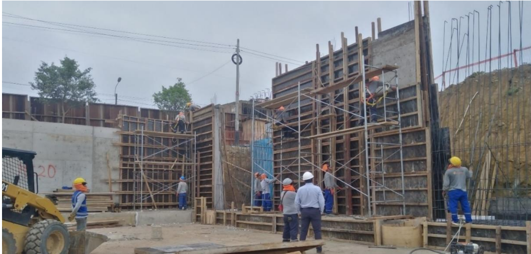
Figura 278: Solado y excavación de zanjas para cuñas de muro MC-22.
