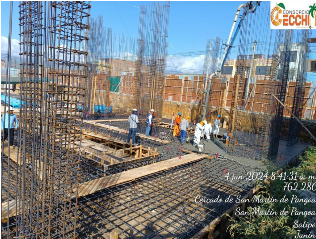
Figura 162: Vaciado de concreto en losa de cimentación – Parte 1 Módulo 08.
