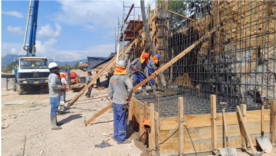
Figura 289: Encofrado de pantalla de muro MC-20, vértice A9-A10.
