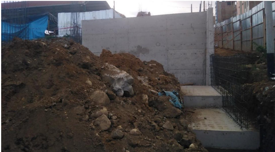
Figura 264: Excavación para cimentación de muros de contención – Calle Perene.
