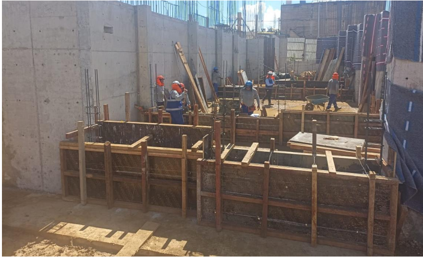
Figura 216: Armado de acero y encofrado de sobrecimientos armados – Bloque 11.
