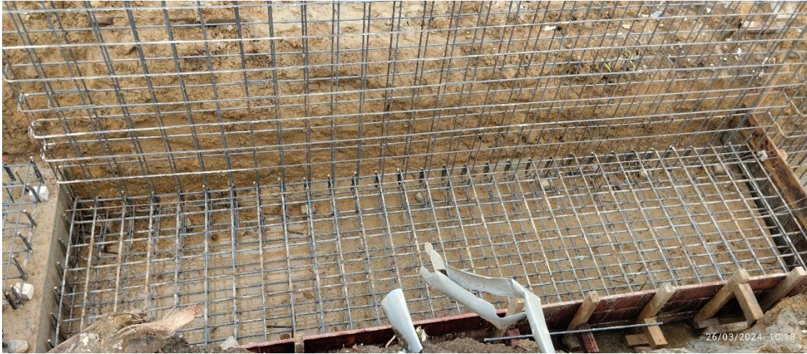
Figura 269: Verificación de distribución de acero de refuerzo en muro MC-10.
