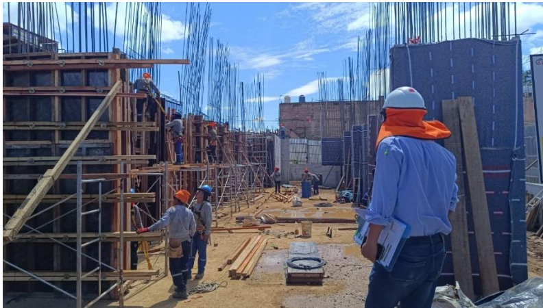
Figura 210: Vaciado de concreto en placas y muro sótano – Bloque 11.
