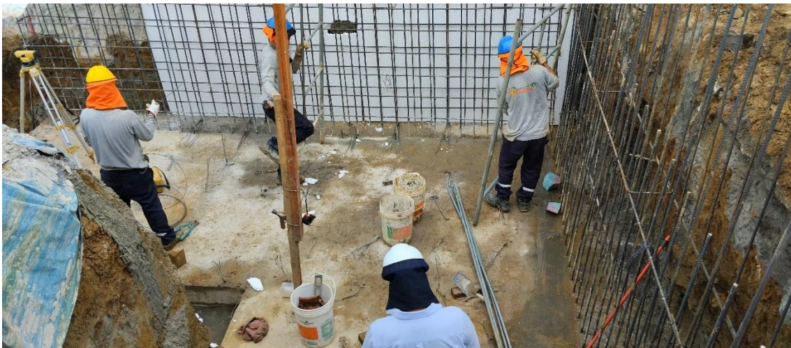
Figura 229: Encofrado de pantalla de muro MC-08.
