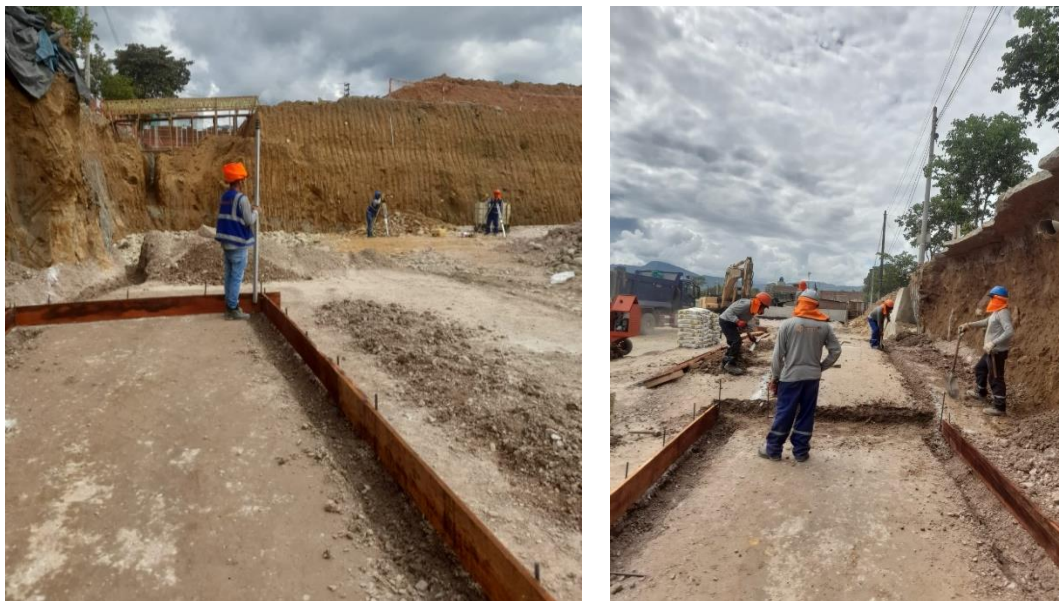
Figura 281: Encofrado de solado en muros MC-18 y MC-18ª, vértice A9-A10.
