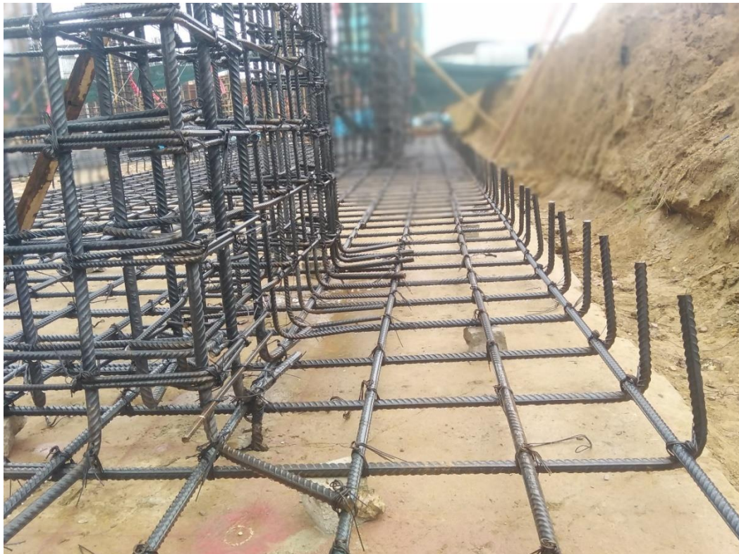
Figura 166: Gancho en refuerzo inferior de losa de cimentación.
