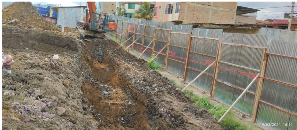
Figura 264: Excavación para cimentación de muros de contención – Calle Perene.
