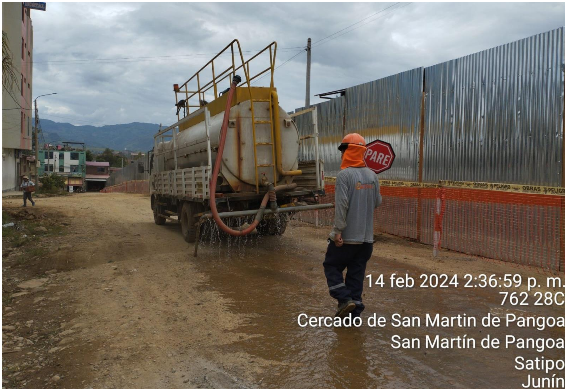
Figura 35: Riego de agua con camión cisterna Calle Perene.
