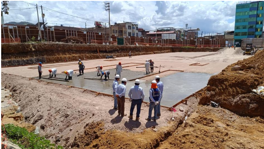
Figura 160: Vaciado de solado módulo 06 y 07.
