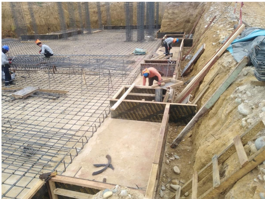
Figura 186: Encofrado de zapatas de rampa – M09 y M10.
