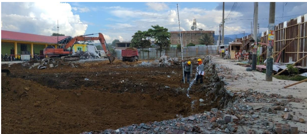
Figura 151: Colocación de puntos de control en excavaciones bloque secundaria.
