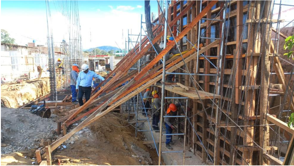
Figura 263: Desencofrado de pantalla de muro MC-09 a .
