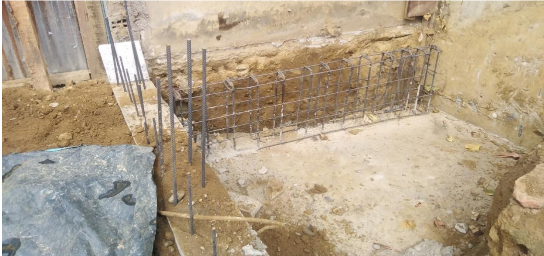
Figura 249: Excavación para cimentación en muros de contención bloque 11.
