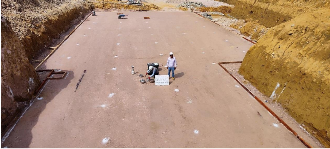
Figura 181: Vaciado de concreto en solado – módulo 09 y 10.
