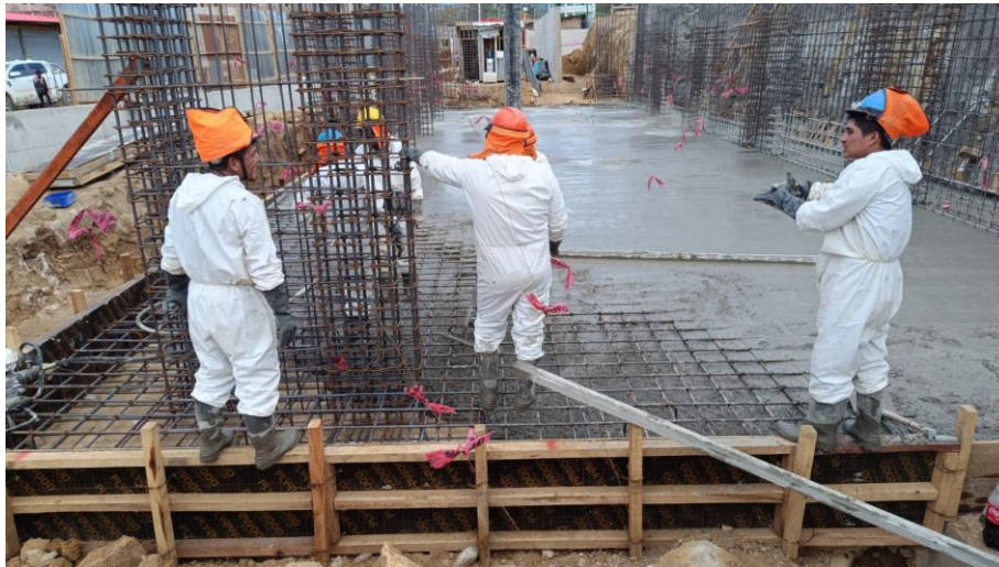
Figura 205: Concreto f'c=280 \text{ kg/cm}^2 en el Bloque 11 – Servicios.
