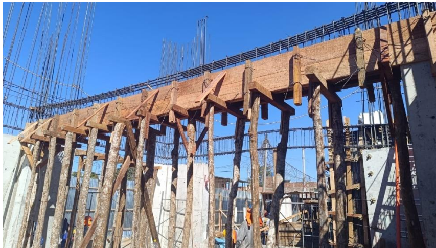
Figura 214: Encofrado de vigas eje Y – Bloque 11.
