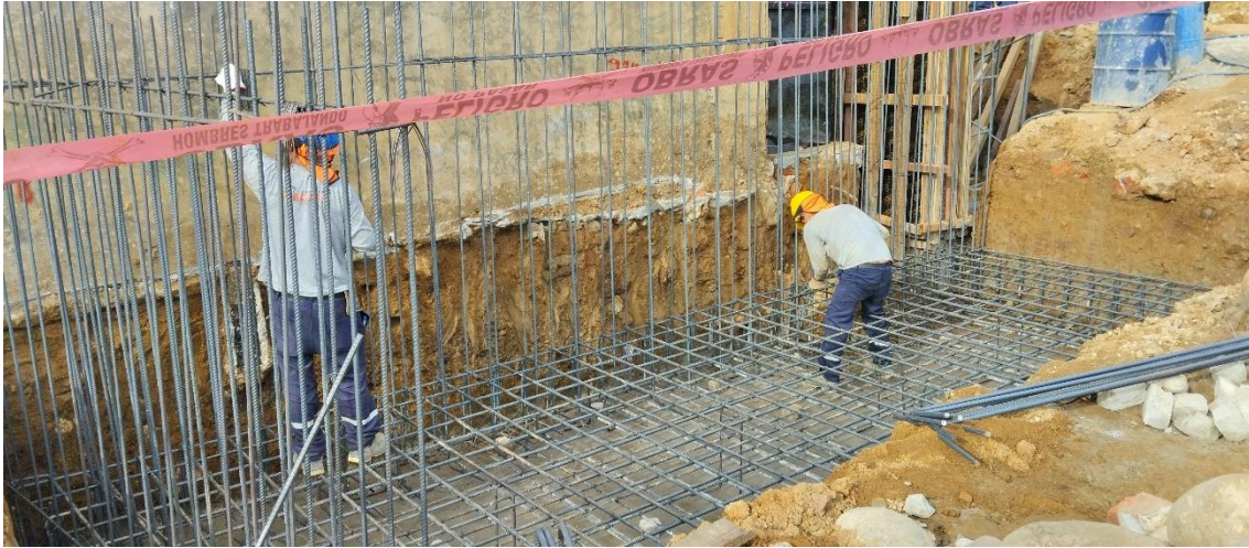
Figura 243: Vaciado de concreto en zapata de MC-08, vértice A8 y A9.
