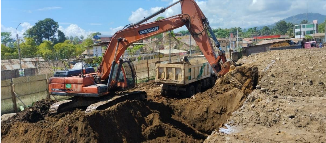
Figura 192: Conformación y compactación – Bloque 11.
