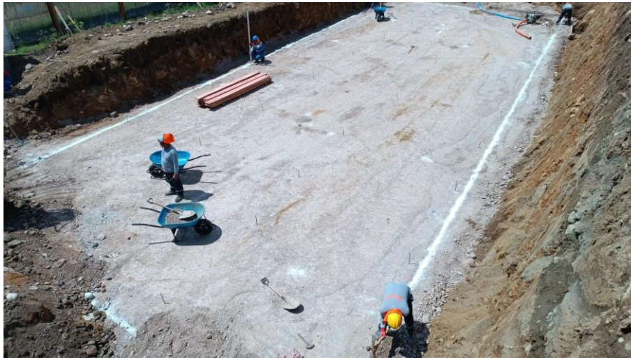
Figura 198: Encofrado y colocación de niveles de vaciado de concreto para solado.
