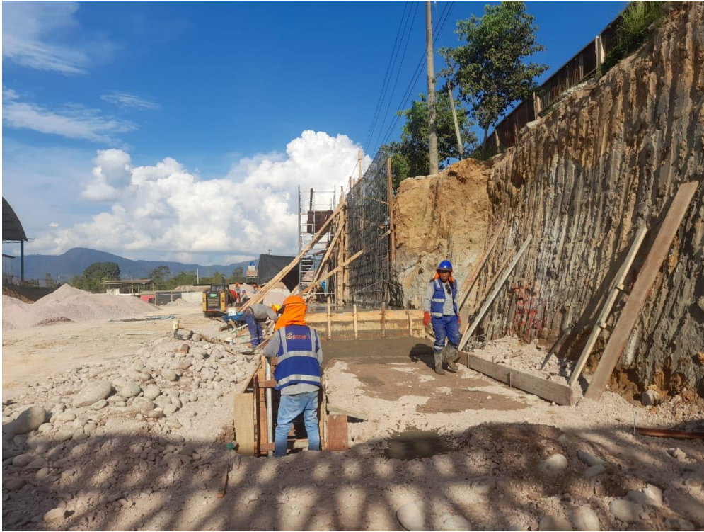
Figura 287: Vaciado de concreto en solado de muro MC-20, vértice A9-A10.
