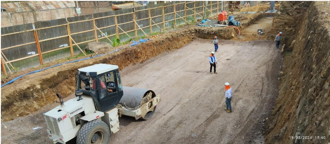
Figura 195: Conformación y compactación material de préstamo fino – Bloque 11.
