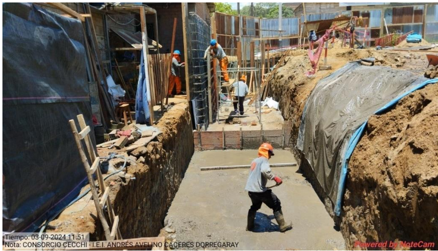
Figura 232: Desencofrado muro MC-08.
