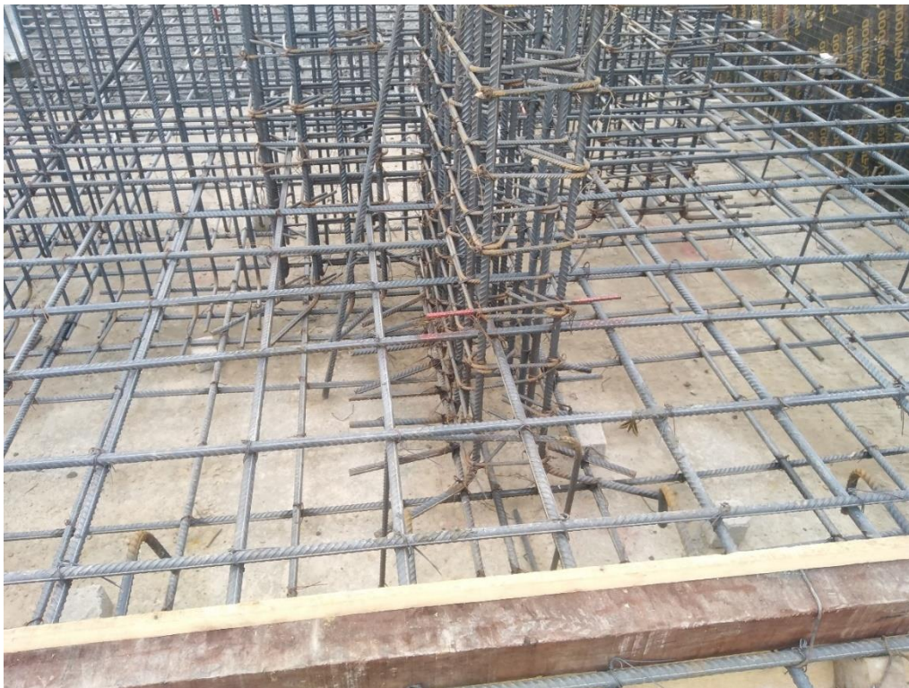
Figura 138: Colocación de nivel de vaciado de losa de cimentación módulo 4.
