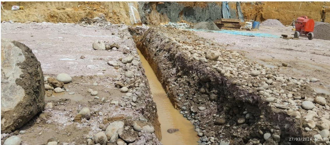
Figura 110: Conformación y compactación del tramo B.
