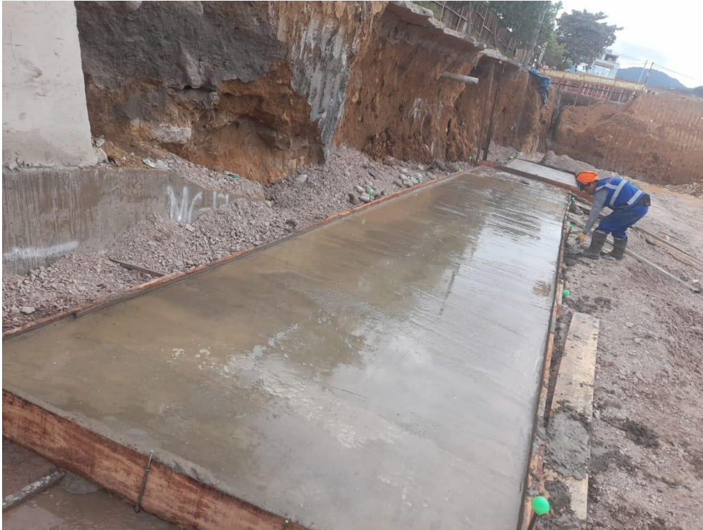
Figura 283: Vaciado de concreto en zapatas de muros MC-18 y MC-18 a , vértice A9-A10.
