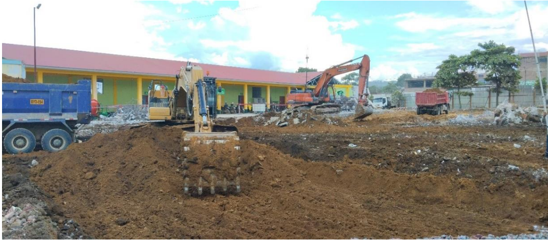
Figura 150: Transporte de material excedente de las excavaciones para cimentación bloque secundaria.
