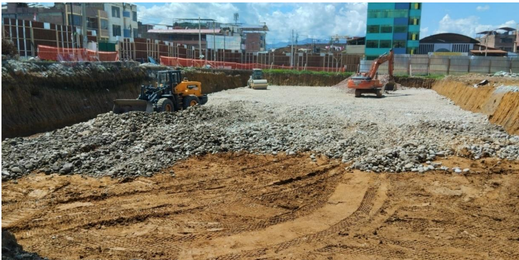
Figura 154: Colocación de material de préstamo OVER – Bloque secundaria.
