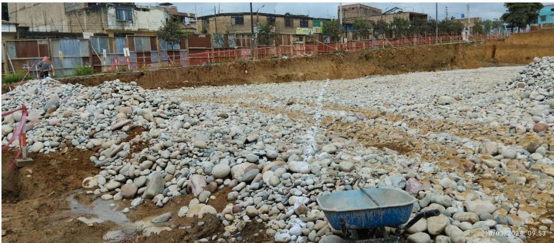
Figura 107: Trazo y replanteo del tramo C del sistema de drenaje.
