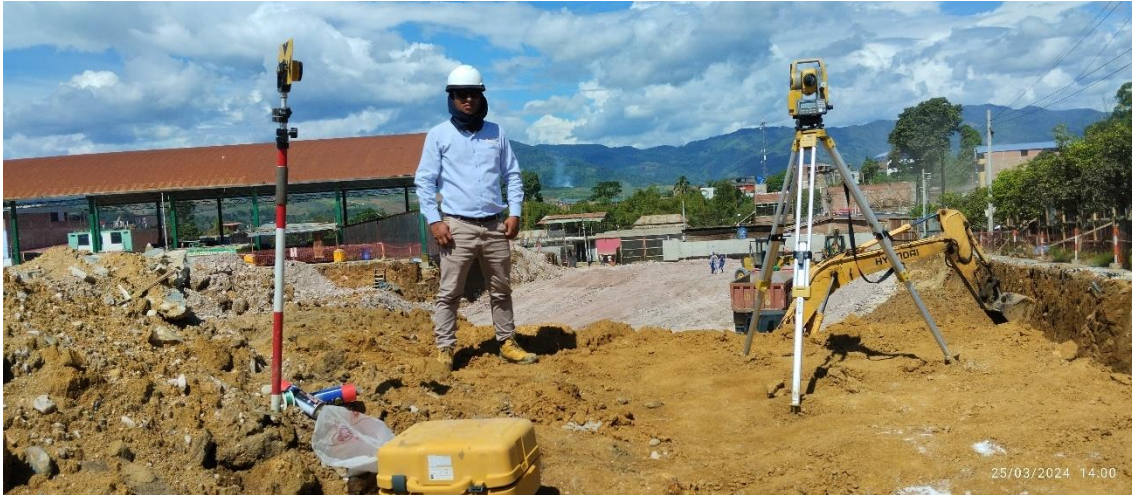
Figura 123: Colocación de material de préstamo – afirmado fino.
