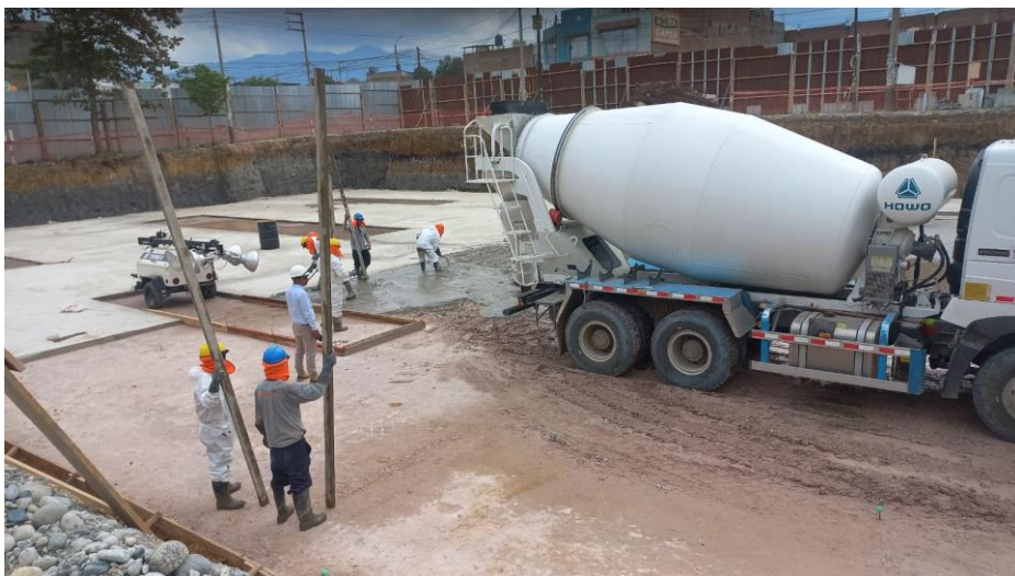
Figura 160: Vaciado de solado módulo 06 y 07.
