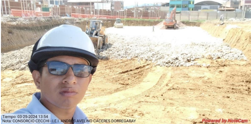
Figura 156: Conformación y compactación de material grueso – Bloque secundario.
