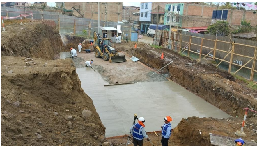
Figura 199: Vaciado de concreto en solado – Bloque 11.
