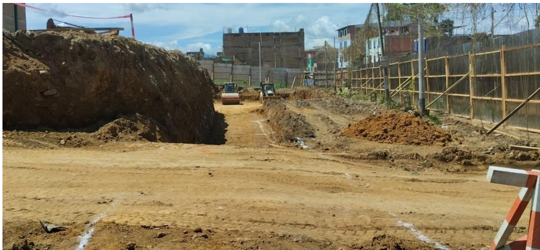
Figura 250: Trazo y replanteo de muros de contención bloque 11.
