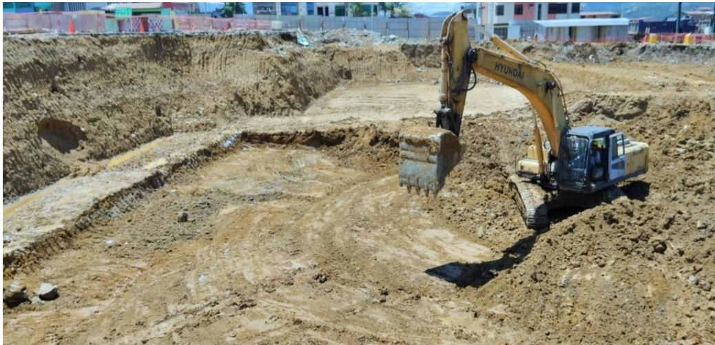
Figura 118: Colocación de material de préstamo – OVER.
