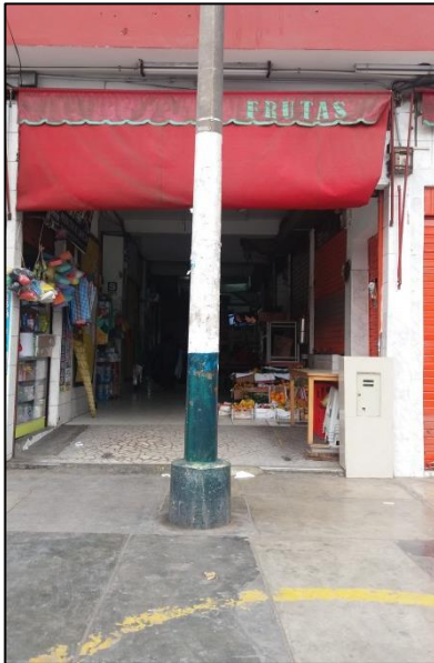
Figura 57. Entrada de la Puerta 1 sin contenedor alguno
