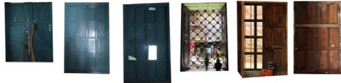
Ventana alta de madera de doble hoja con rejas de acero. Ventana alta de madera con 16 módulos rectangulos. Ventana alta de madera con 16 módulos rectangulos. Ventana alta de madera con decoraciones en acero del estilo art nouveau. Ventana alta de madera de doble hoja con rejas de acero. Ventana alta de madera con doble hoja.
