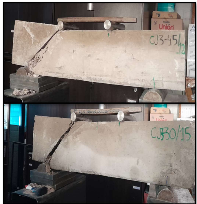
Figura 13. Patrones de grietas finales en el grupo D (Arriba- junta con inclinación a 45^\circ ) y E (Abajo - junta con inclinación a 30^\circ ).
