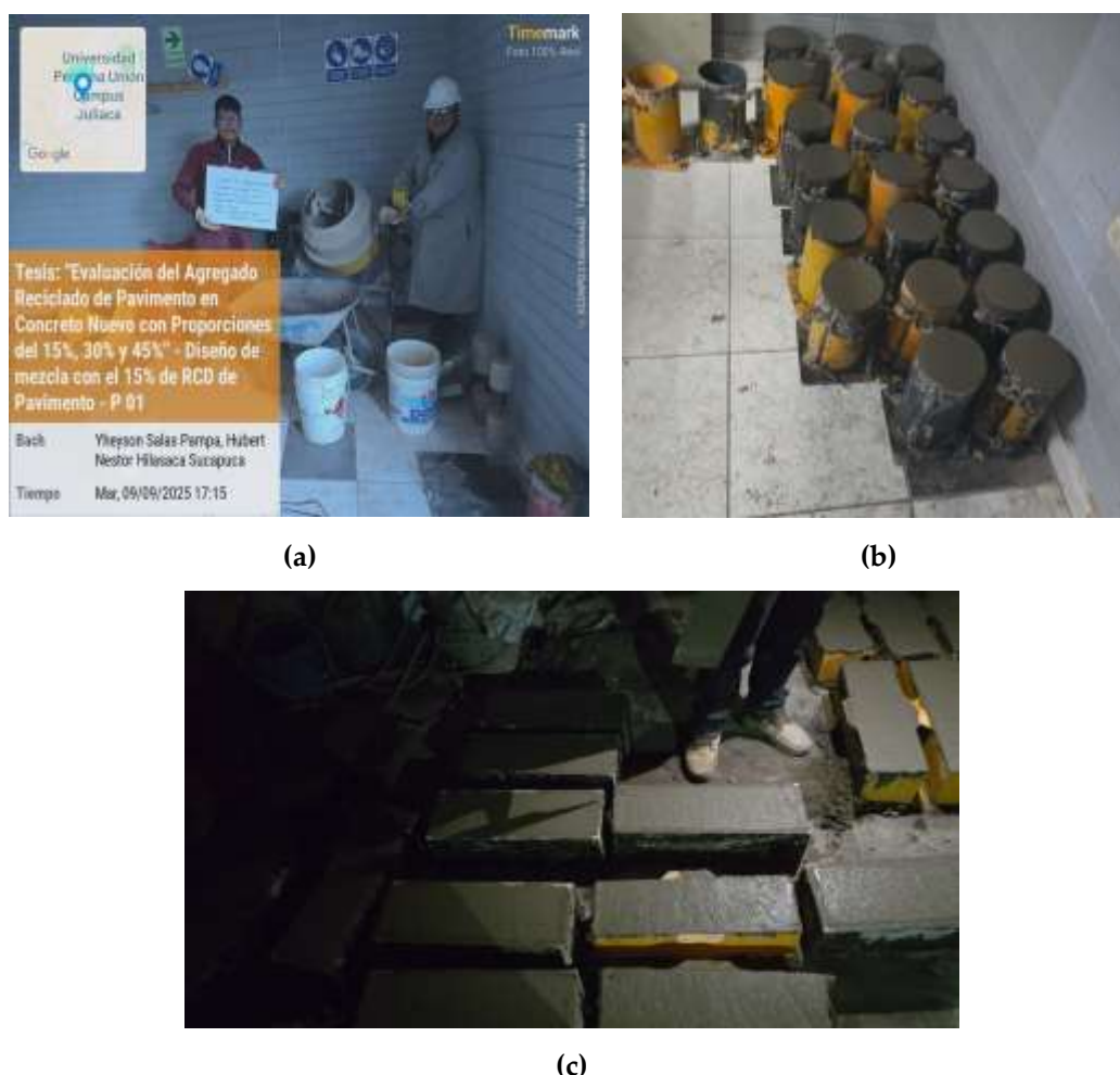
Figura 9. (a) Preparación del concreto, (b) Nivelación de superficie en moldes de cilindro, (c) Nivelación en moldes de viga.
