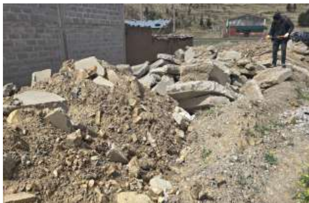
Figura 2. Vertedero Salida Lampa.
