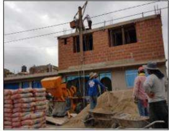
Fotografía 8. Construcción de vivienda Nro. 08 (V-08)
