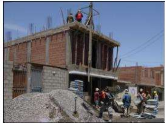
Fotografía 12. Construcción de vivienda Nro. 12 (V-12)
