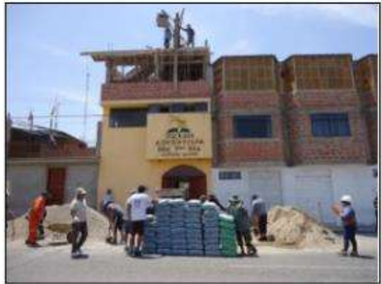
Fotografía 11. Construcción de vivienda Nro. 11 (V-11)
