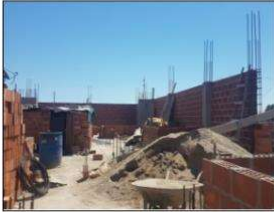
Fotografía 7. Construcción de vivienda Nro. 07 (V-07)
