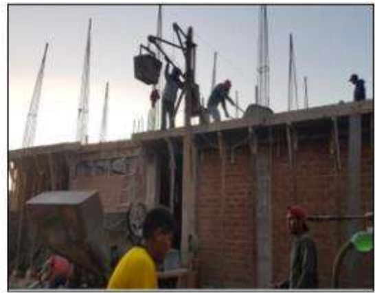
Fotografía 10. Construcción de vivienda Nro. 10 (V-10)
