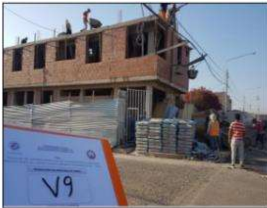
Fotografía 9. Construcción de vivienda Nro. 09 (V-09)
