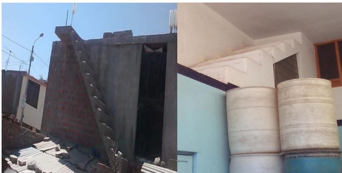
Figura 7.24. Construcción de una escalera al vacío, Salida Cusco.
