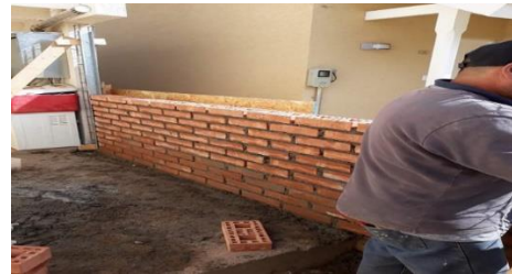
Figura 67. Asentado de ladrillos (Blondet, 2005).
