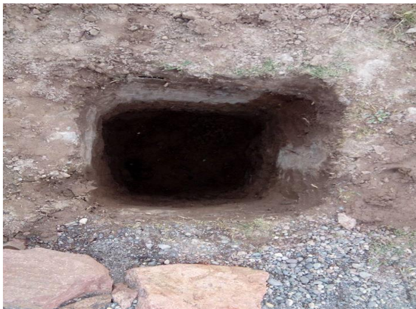
Figura 103.- Excavación de una calicata en Salida Huancané – Urb. Huancané.
