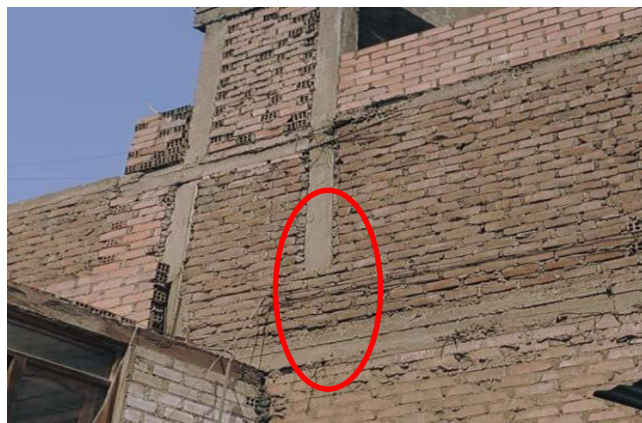
Figura 7.7. Columna construida sobre las unidades de albañilería, Jr. Escuri 123.
