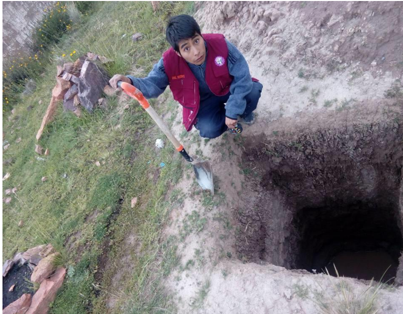
Figura 102.- Continuación de la excavación de una calicata en Salida Cusco – Urb. Jorge Chavez.
