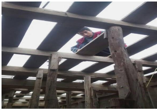
Figura 90. Encofrado de losa aligerada
