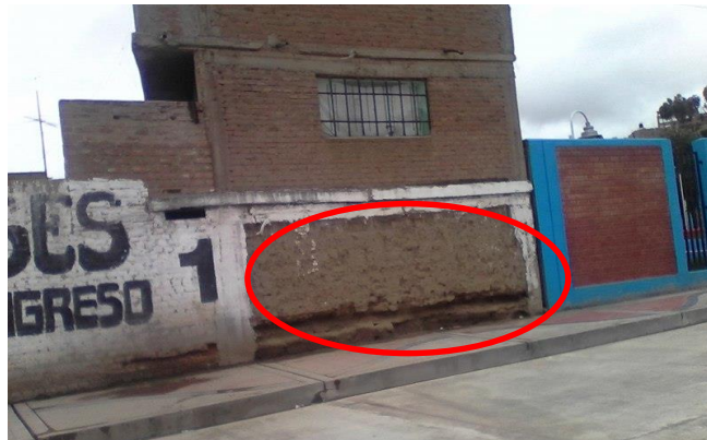
Figura 7.2. Muro del primer piso compuesto de adobe, Salida Cusco.
