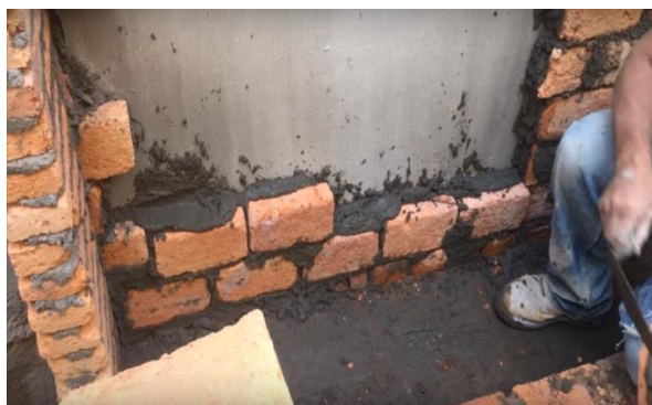
Figura 7.36. Asentado de muros con argamasa “barro”, Jr Miraflores 176, Salida Huancane.
