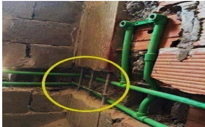
Figura 7.22. Picado de la columna para realizar las instalaciones sanitarias, Jr. 21 de enero 231, Salida Cusco.
