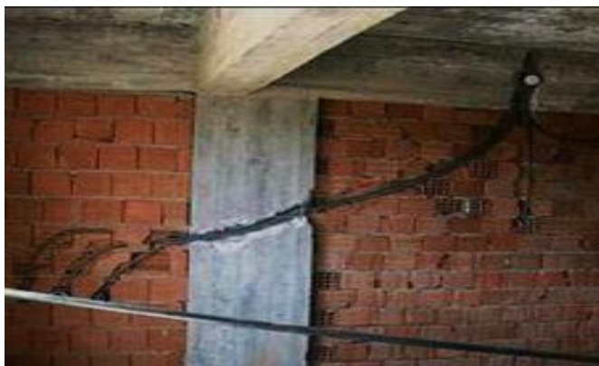
Figura 7.23. Picado de la columna para la instalación eléctrica en la vivienda, Jr. Angamos 420, Salida Cusco.
