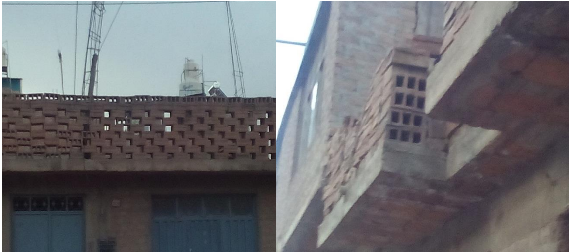
Figura 7.18. Ladrillos apilados cumpliendo el papel de parapetos, Salida Cusco.
