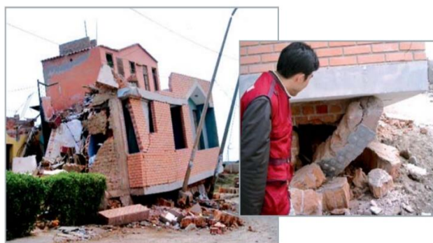
Figura 2.6. Vivienda dañada debido al terremoto de Pisco (Aceros Arequipa, 2011).
