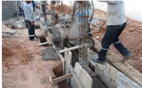
Figura 59. Vaciado del cimiento.
