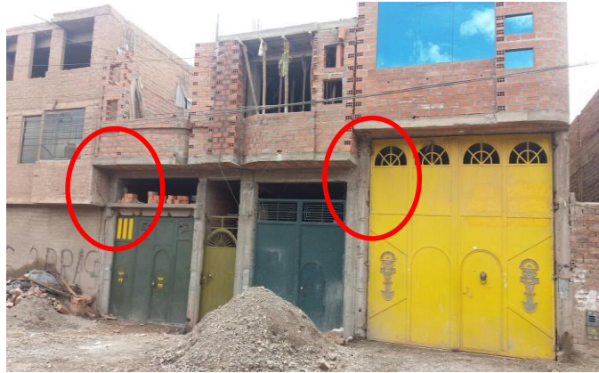
Figura 7.17. Losas de las viviendas colindantes a diferente nivel, Saldaña Cusco.
