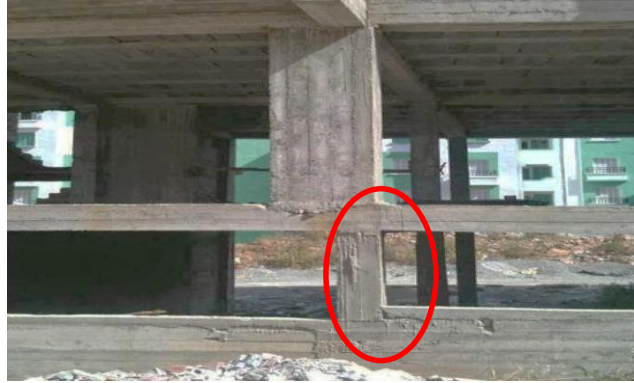
Figura 7.4. Peso de toda la edificación sobre una imitación de columna, Salida Huancane.
