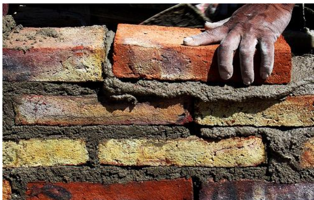
Figura 7.37. Asentado de muros con argamasa “barro”, Jr. Número 1156, Salida Cusco.
