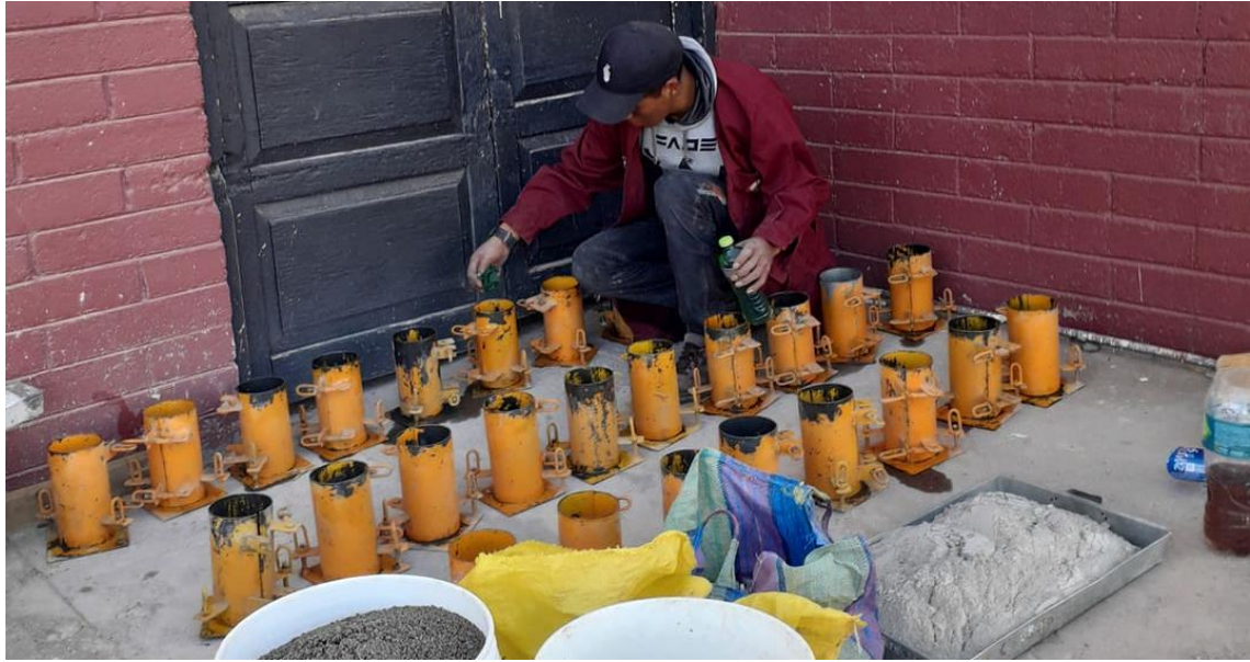
Fotografía N° 17 Aplicación de aceite mineral ligero en las caras interiores de los moldes de concreto.
