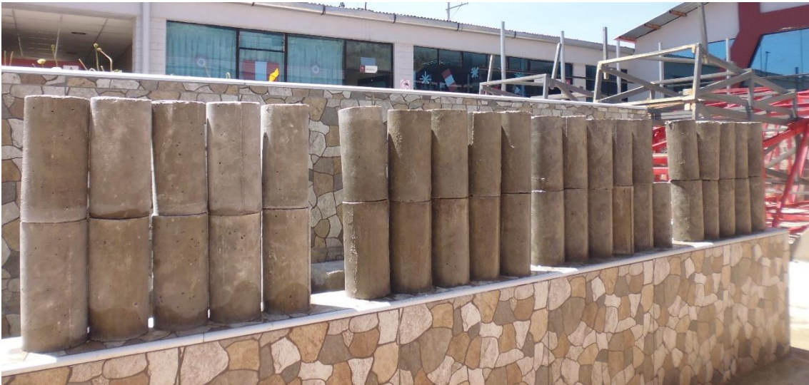
Fotografía N° 26 Efecto superficial resultante de la adición de CRT en el concreto.
