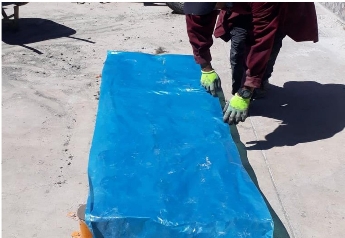
Fotografía N° 22 Protección de las briquetas para evitar la pérdida de humedad.
