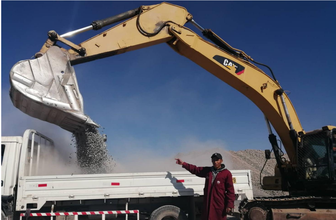
Fotografía N° 7 Extracción de piedra canchada de la “Planta Chancadora Surupana”
