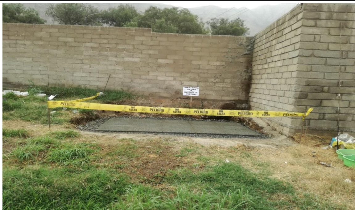
Fotografía N° 41. Área de construcción de pavimento permeable con cintas de seguridad.
