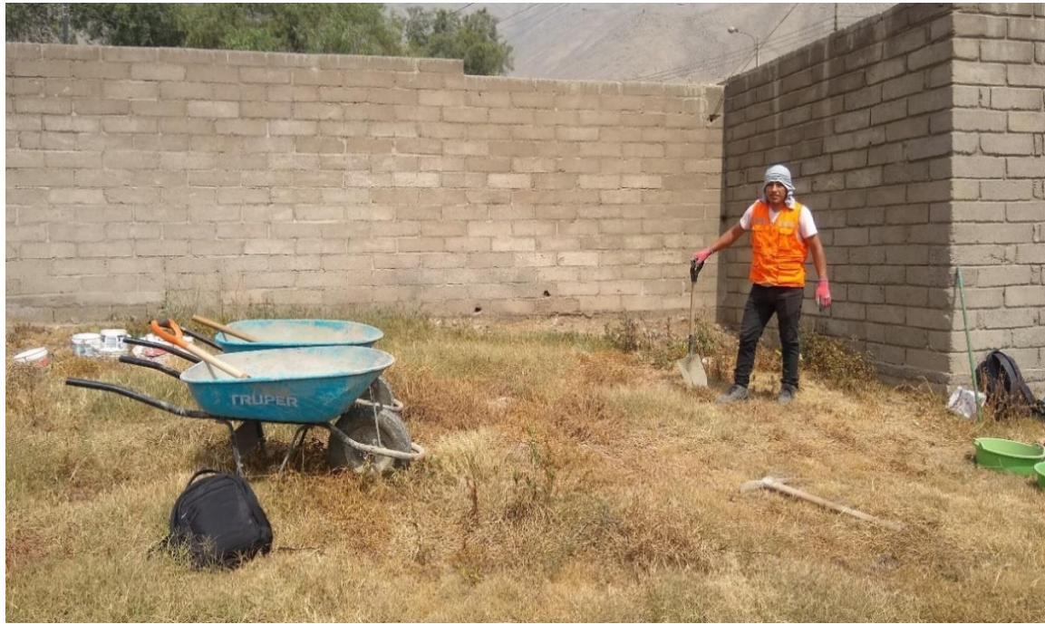
Fotografía N° 37. Movimiento de tierra para el pavimento de concreto permeable.
