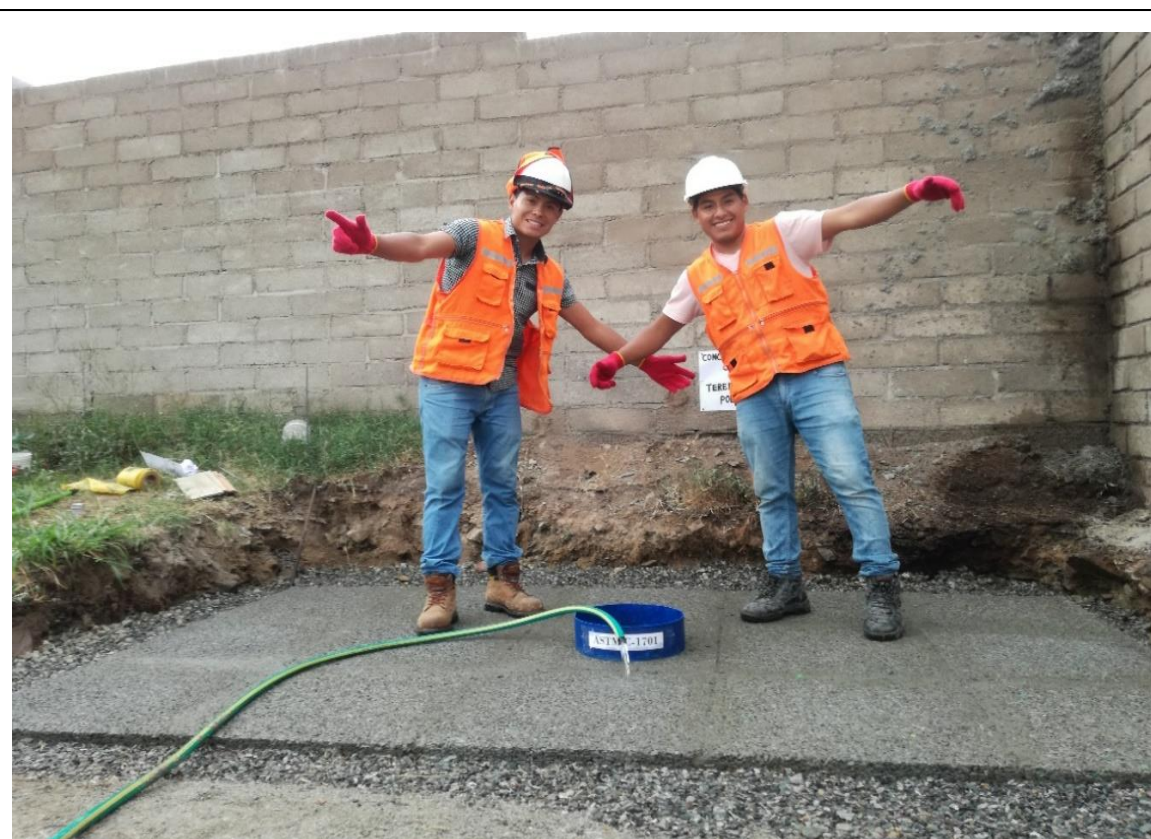
Fotografía N° 42. Fin de ensayo de concreto permeable con adición de fibras PET para pavimento.
