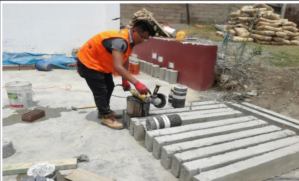
Fotografía N° 29. Procedimiento de corte de especímenes de 15 cm x 15 cm con amoladora eléctrica
