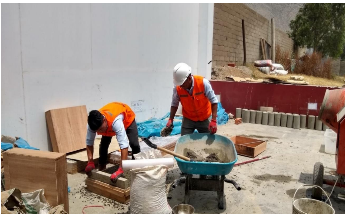
Fotografía N° 33. Elaboración de losa 60 x 60 x 15 cm con una compactación ligera usando martillo proctor.
