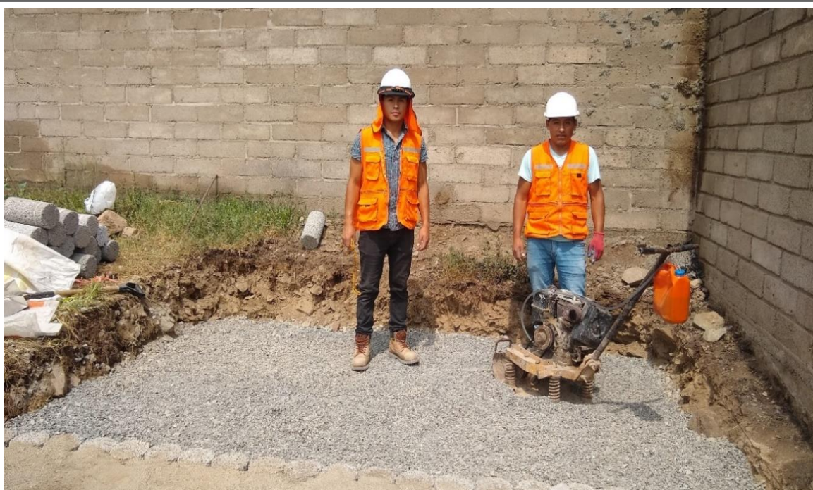
Fotografía N° 38. Base para pavimento permeable compactado con plancha compactadora.
