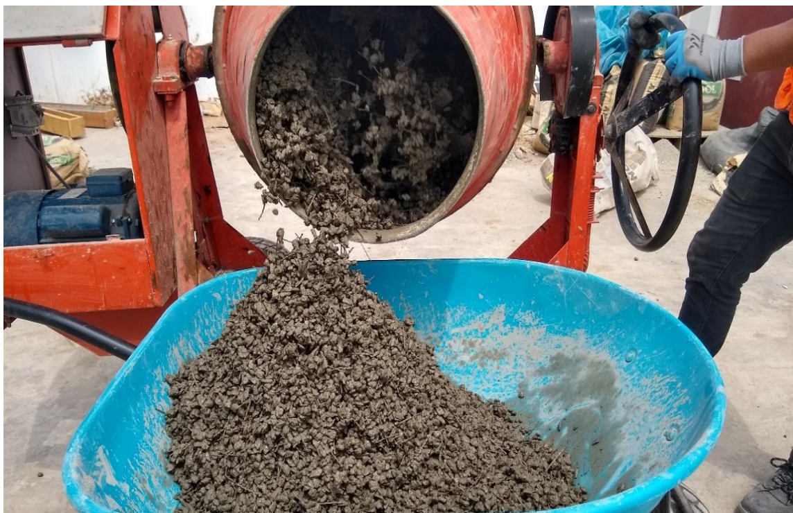
Fotografía N° 12. Mezcla de concreto permeable realizado para elaborar especímenes, viguetas, losas.
