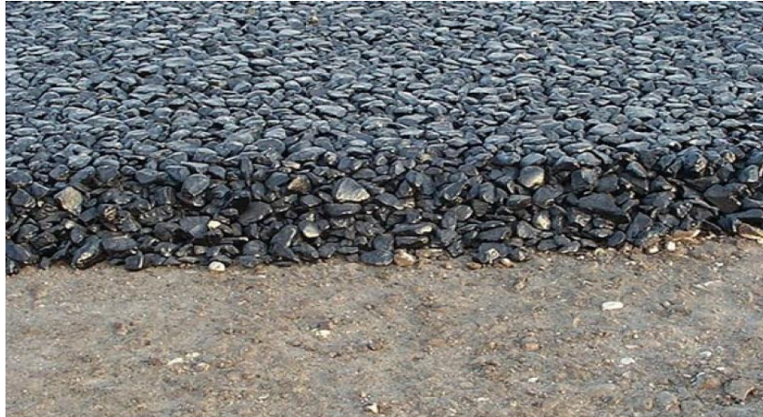
Figura 7. Pavimento permeable construida con un tipo de betún.
