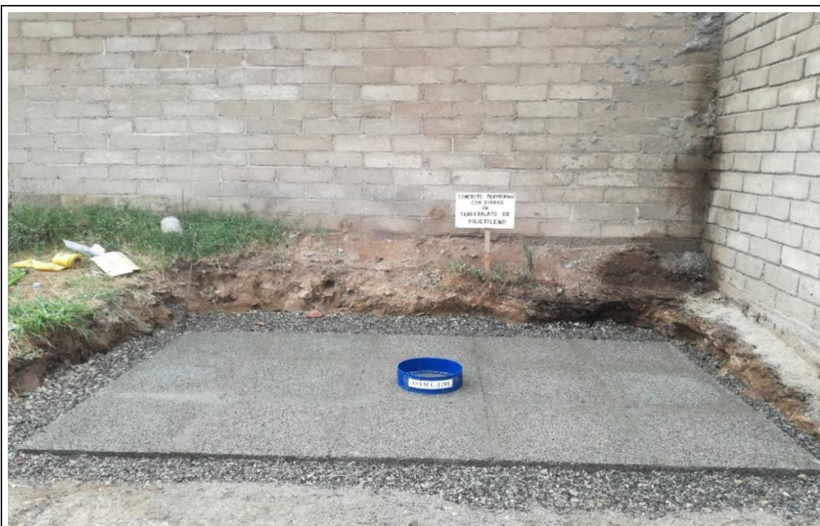
Fotografía N° 39. Pavimento permeable con porcentajes de adición de fibras PET, con un anillo sellado al pavimento.
