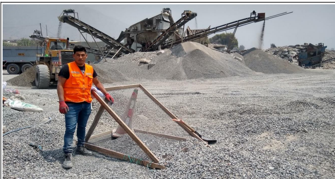
Fotografía N° 01. Tamizando agregado grueso Huso N° 8 (3/8") en la cantera "Moviagregados - Ñaña".
