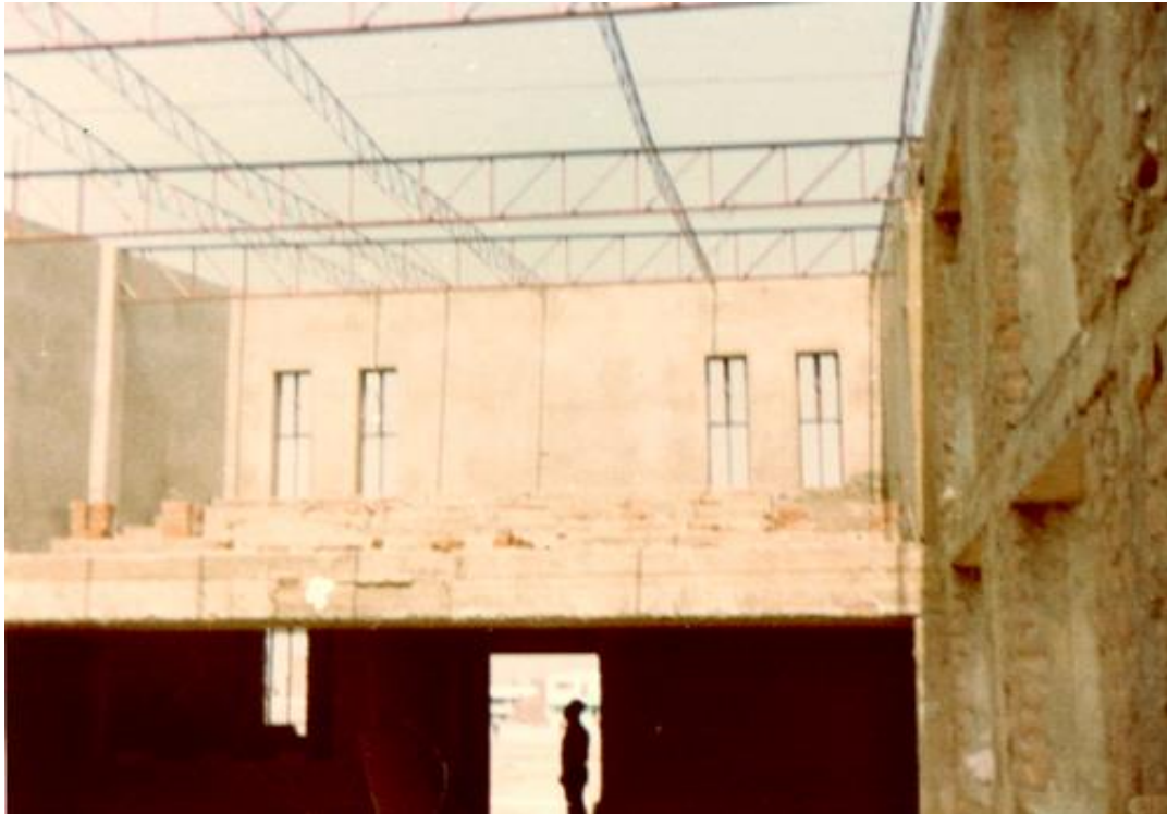
Figura 6. Vista panorámica interna de la construcción del templo de Vitarte Central en 1982.
