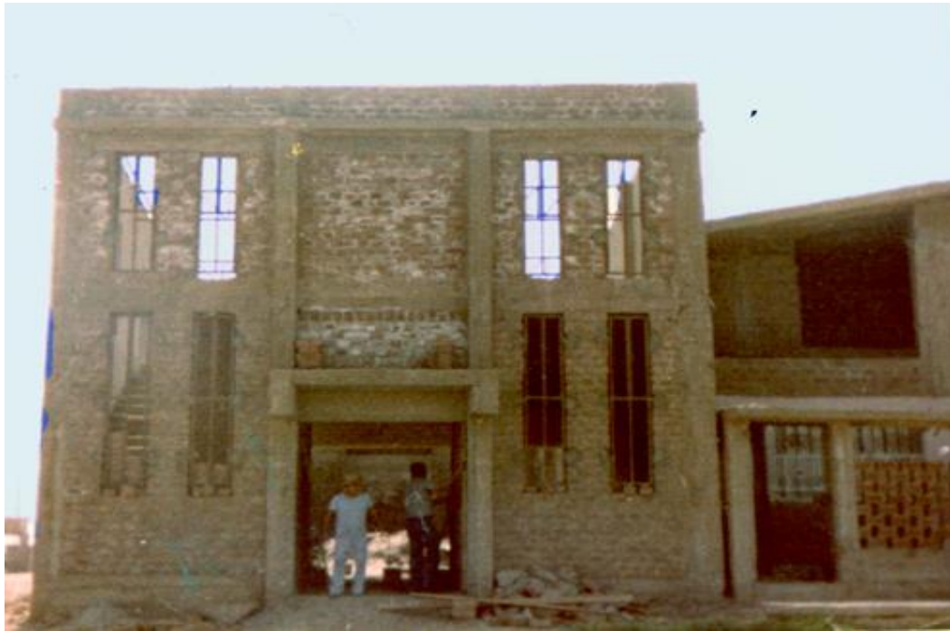
Figura 9. Vista panorámica de la parte frontal del templo de Vitarte Central construido en 1982.
