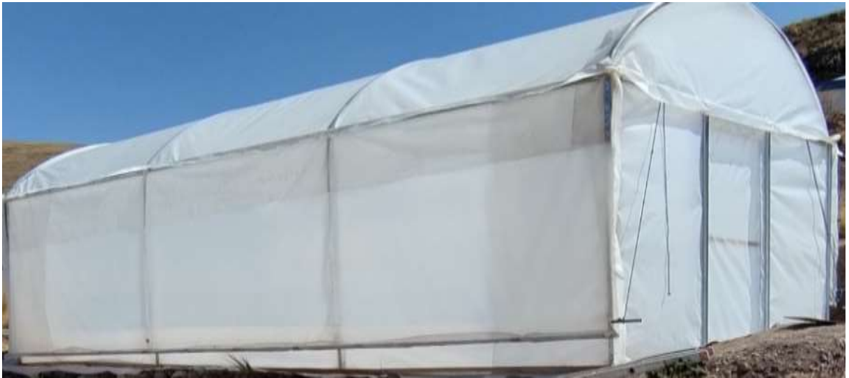
Figura 6. Construcción finalizada del invernadero hidropónico conforme a la normativa nacional E-020, 030 y 090 e internacional ASCE 7:16
