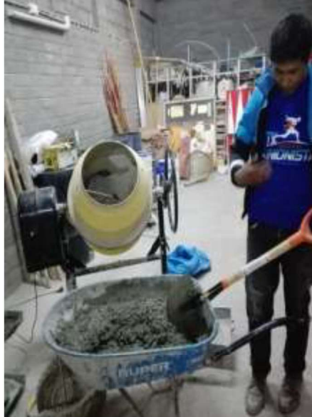
Grafico 11: Mezcla de concretos convencionales
