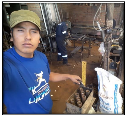
10) Armado del molde EcoBrik
