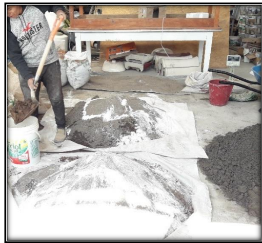
34) Preparación antes del mezclado
