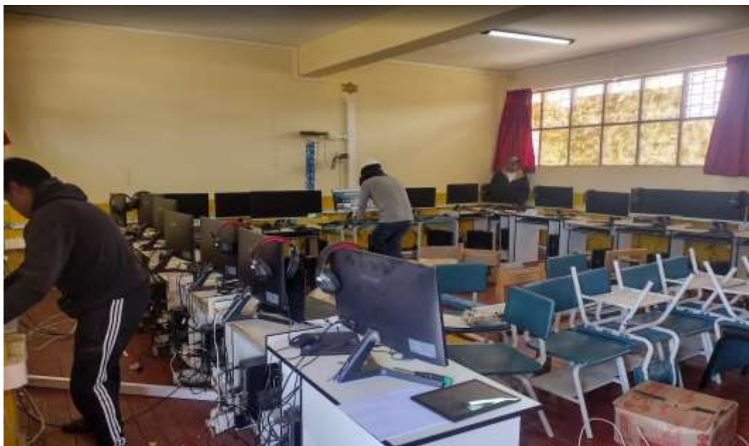
Anexo B.1.2. Instalación y cableado de internet en el centro de cómputo para 35 PC de I.E José Carlos Mariátegui con el apoyo del personal de la Municipalidad Maras, durante el periodo 2023 en el mes de abril, con el objetivo de usar las maquina instaladas para los estudiantes y desarrollen labores educativas.
