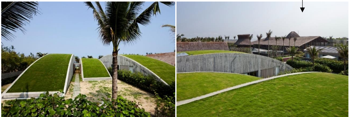
Figura 34. Techos verdes en las Villas de playa VIP – Retreat Resort
