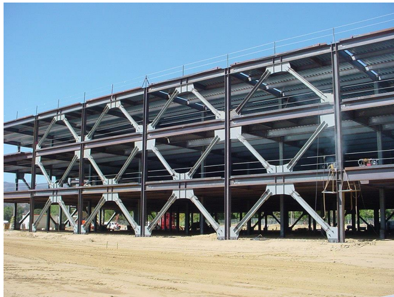
Figura 5: OCBF tipo V-invertida y tipo K.
