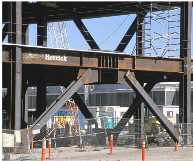
Figura 16 : Pórtico con Arriostres Excéntricos.
