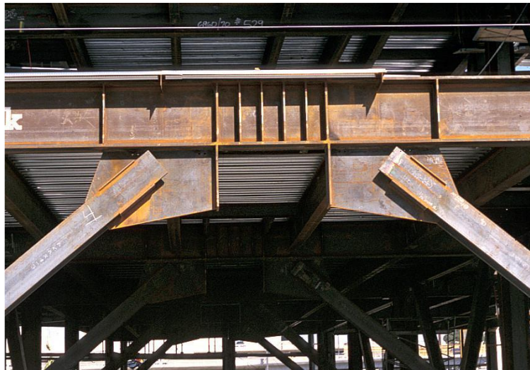
Figura 43: Atiesadores intermedios.
