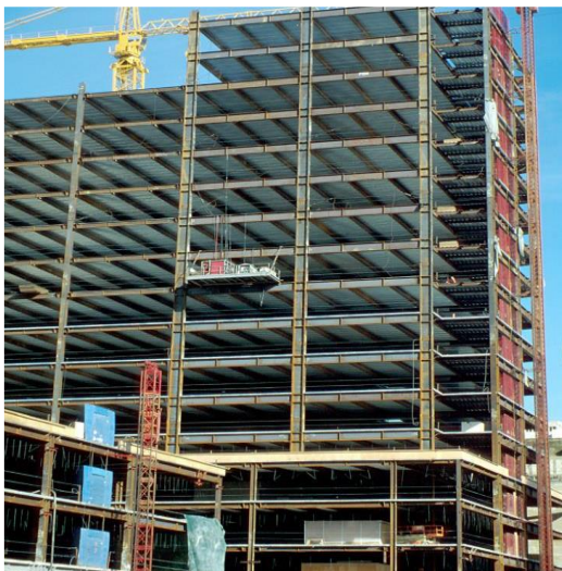
Figura 2: Edificio de acero con (OMF).
