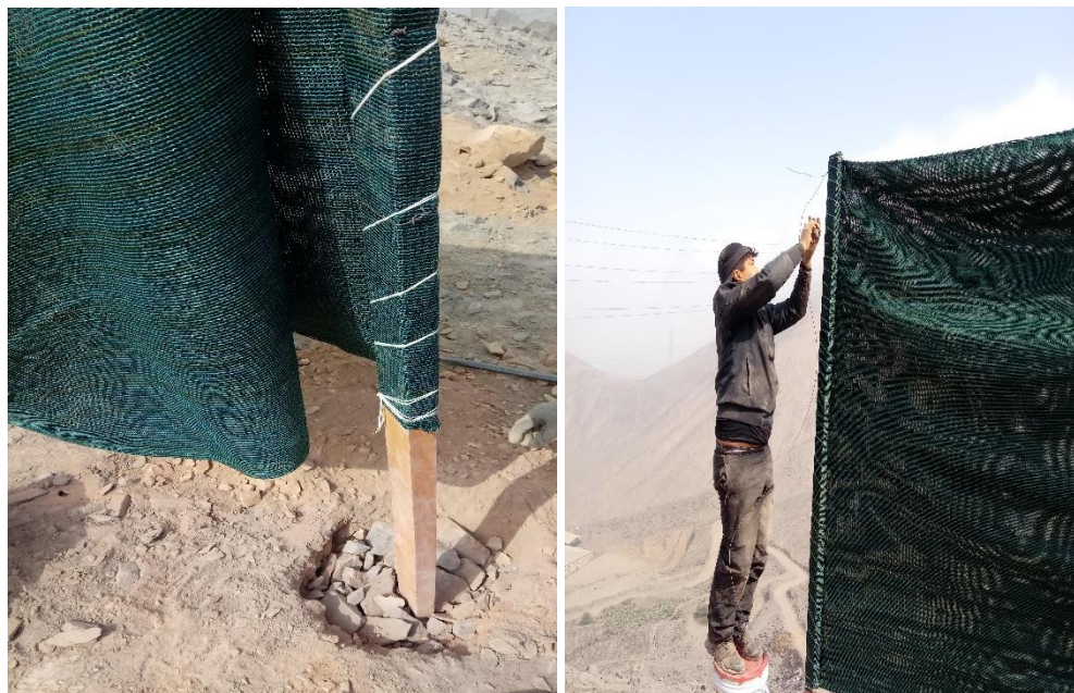
Figura 17 Fijación de los alambres tensores.
