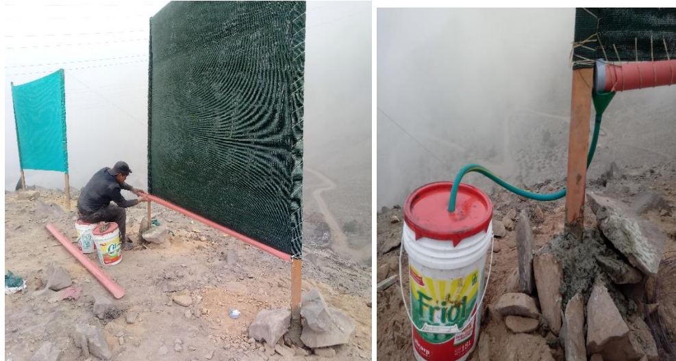
Figura 18 Instalación del sistema recolector.
