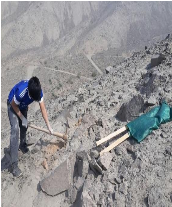
Excavación manual para la instalación del Neblinómetro
