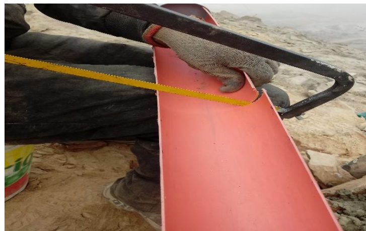
Figura 15 Corte de tubo recolector en campo.
