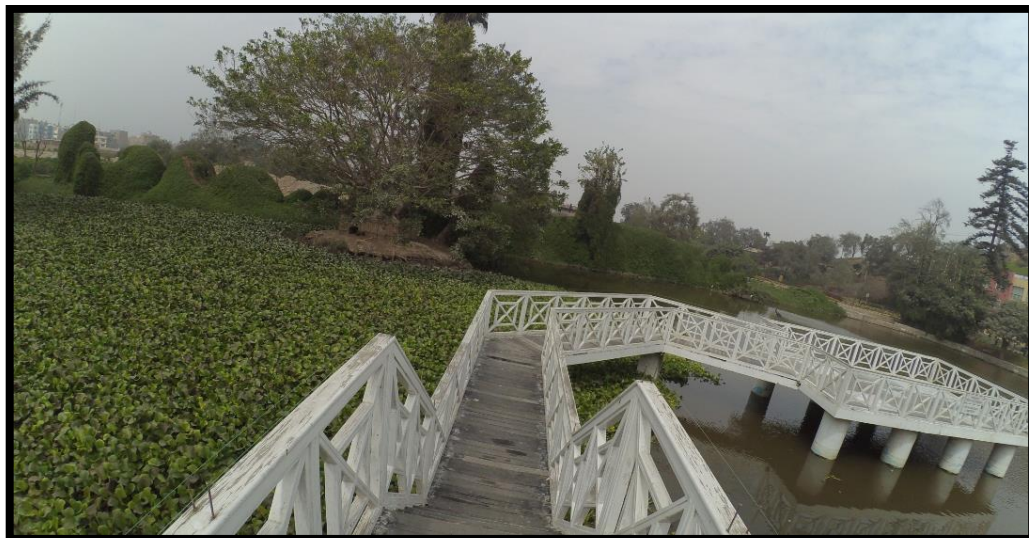
Nota: Incremento de la planta de Jacinto de agua en el espejo de agua.
