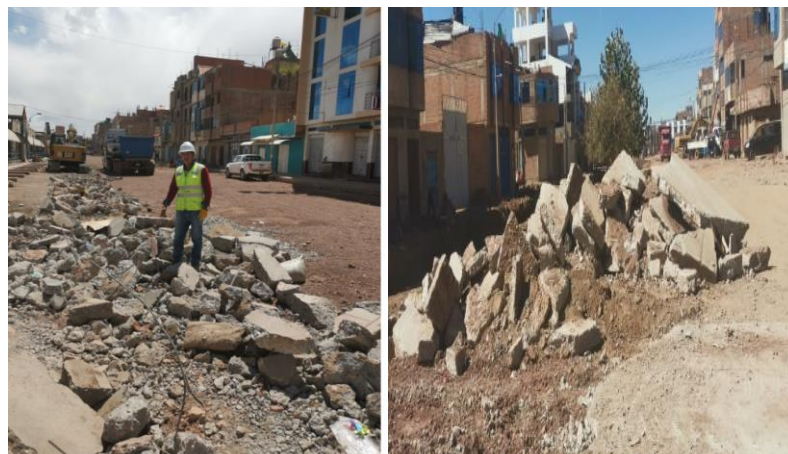
Figura 2. Demolición del concreto, vereda.
