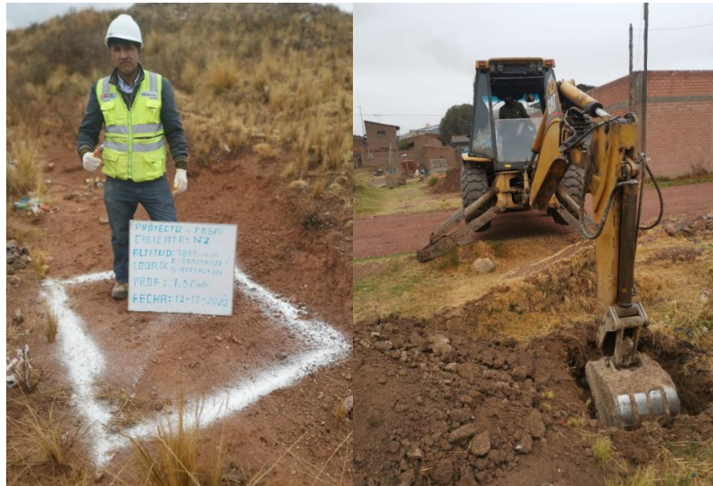
Figura 1. Ubicación y excavación del punto
