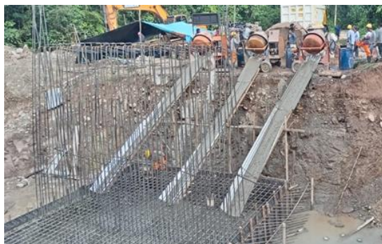
Figura 24: Llenado de concreto f'c=210 kg/cm 2 en zapatas de los estribos.
