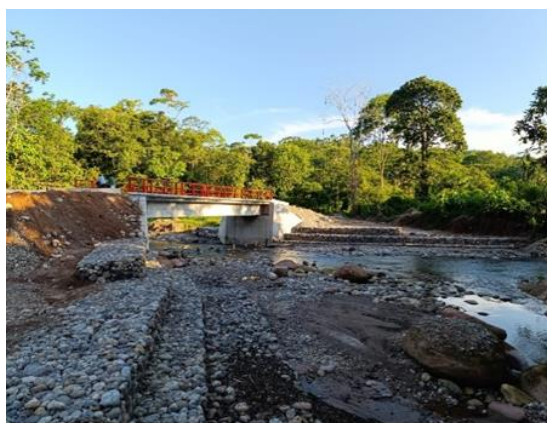
Figura 28: Obra culminada y recepcionada, puente y defensa ribereña.
