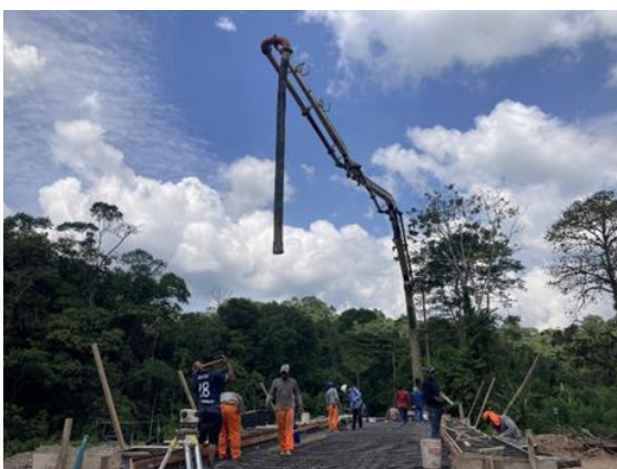
Figura 27: Llenado de concreto f'c=280 kg/cm 2 en vigas y losa del puente.
