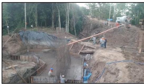
Figura 20: Llenado de concreto f'c=210 kg/cm 2 de zapatas de los estribos.
