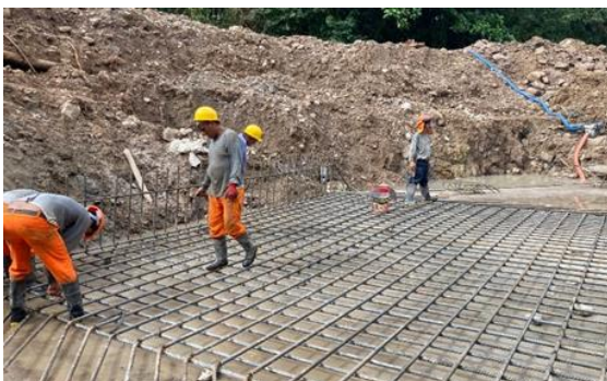
Figura 23: Armado de acero para zapatas de los estribos.
