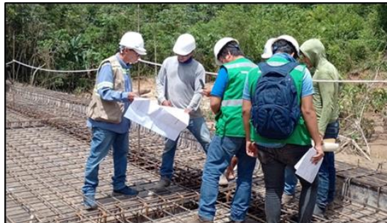
Figura 18: Verificación de los refuerzos estructurales del puente tipo viga losa.
