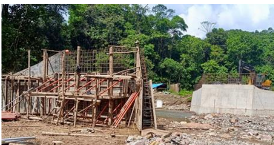
Figura 23: Armado de acero para zapatas de los estribos.
