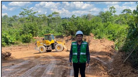
Figura 17: Verificación de los trabajos de perfilado y compactado de la carretera.
