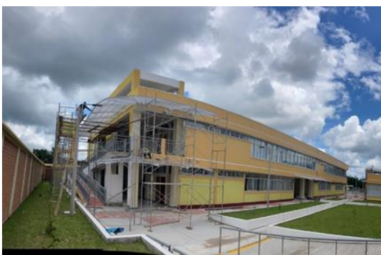
Figura 33: Ejecución del adicional de obra N°04.
