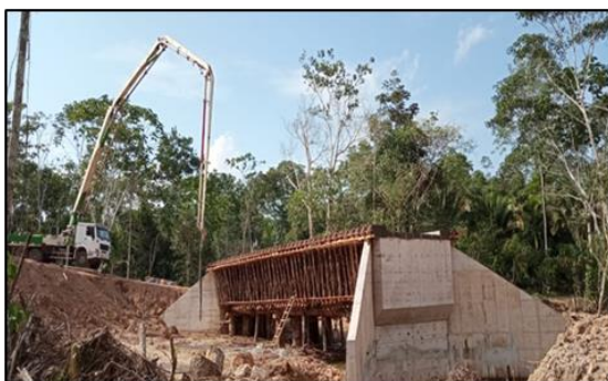
Figura 21: Llenado de concreto f'c=280 kg/cm 2 en vigas y losa del puente.
