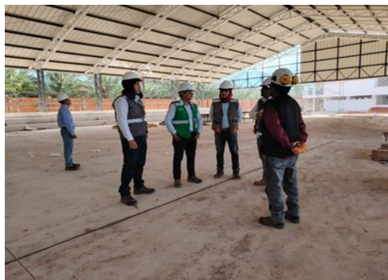
Figura 30: Verificación de los trabajos ejecutados en la losa deportiva techada.
