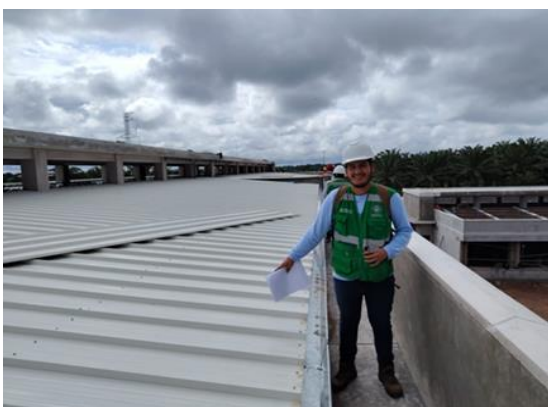
Figura 31: Verificación del techado del módulo A-B.
