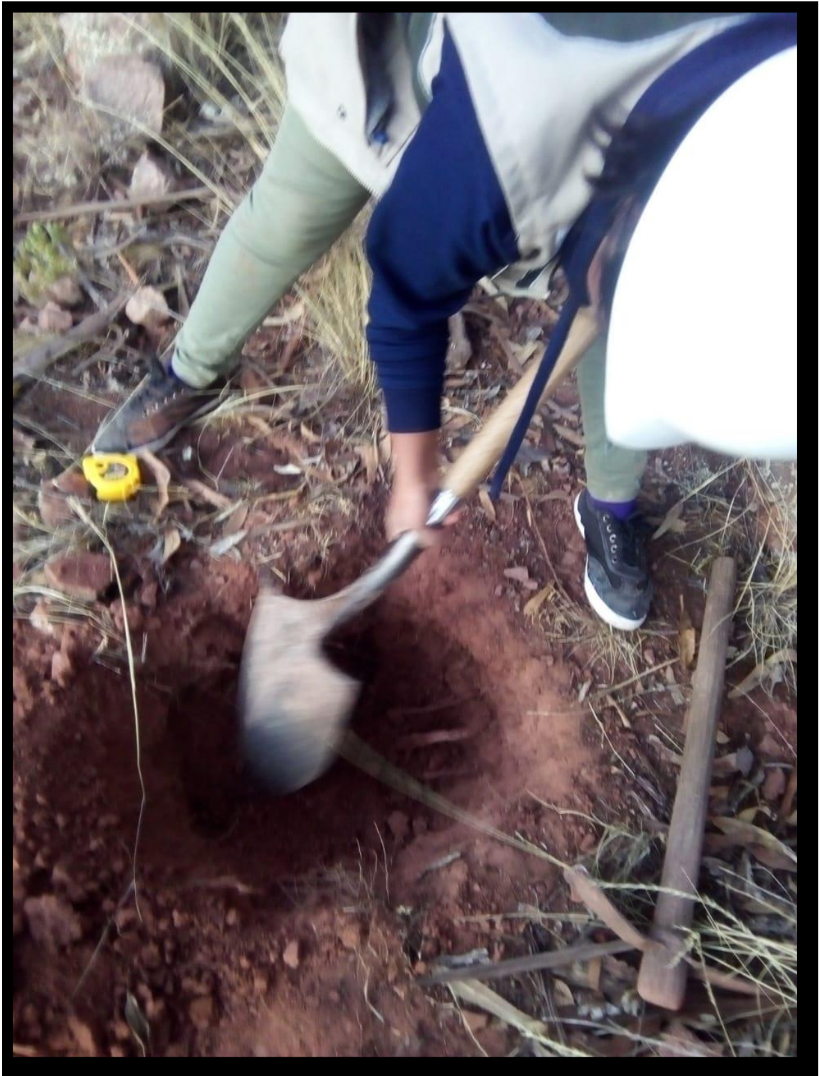
Fotografía 5. Abriendo apertura de calicata.
