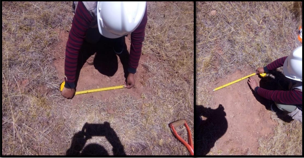
Fotografía 3. Medición para la apertura de calicata.
