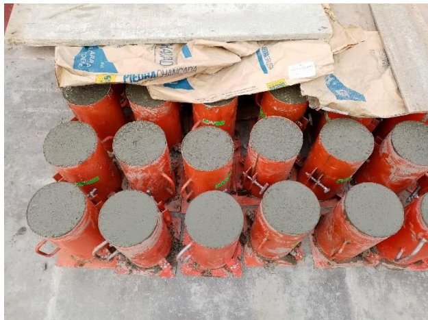
Probetas de concreto
