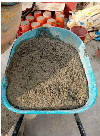
Mezcla del concreto
