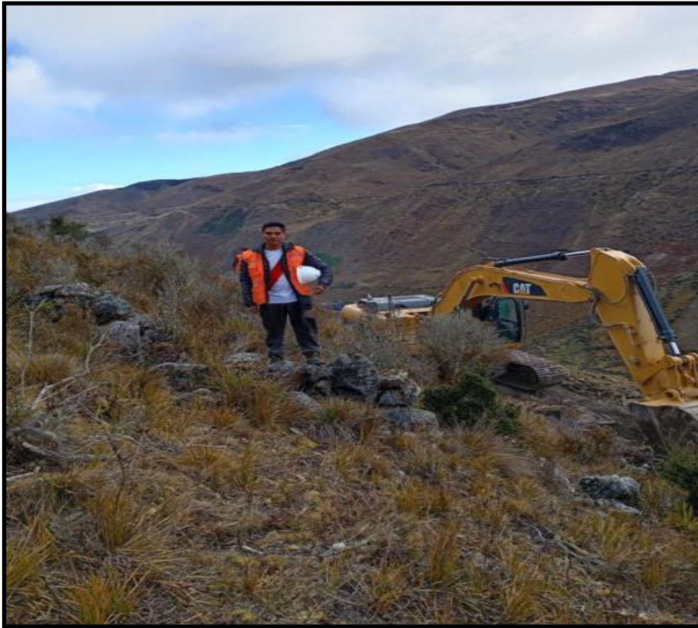
Figura N° 33 Vista de la inspección del corte de carretera.
