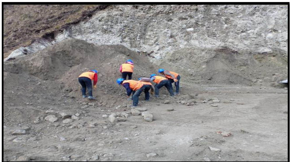
Figura N° 39 Vista del personal realizando sus labores en obra.
