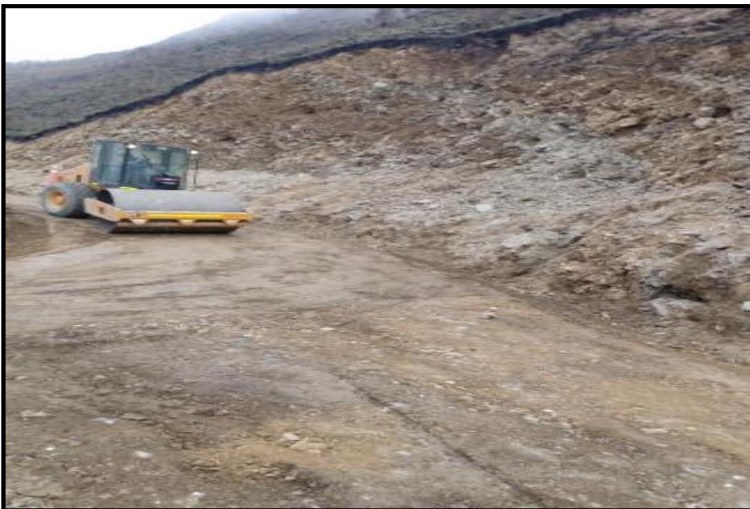
Figura N° 59 Vista del rodillo liso realizando la compactación.
