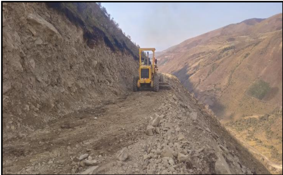
Figura N° 53 Vista de conformación de terraplenes con material propio prog. 0+000 hasta la prog 0+480.
