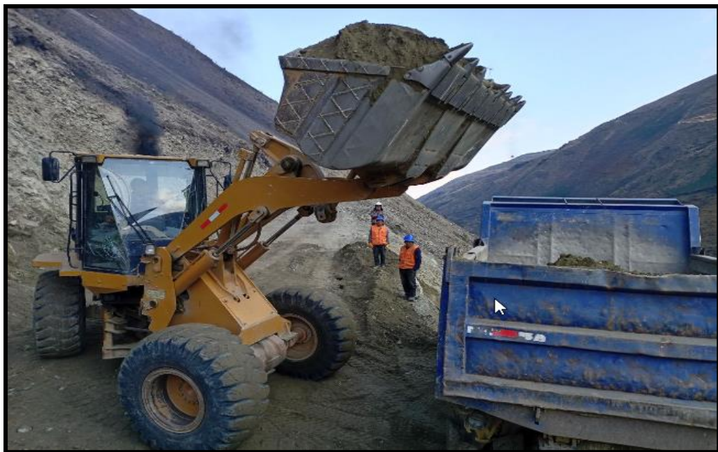
Figura N° 41 Vista del carguío de afirmado en obra.
