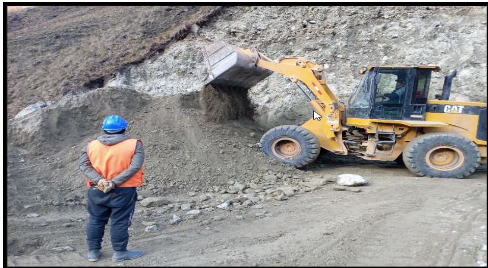
Figura N° 38 Vista del personal de vigía en el coneo de afirmado.
