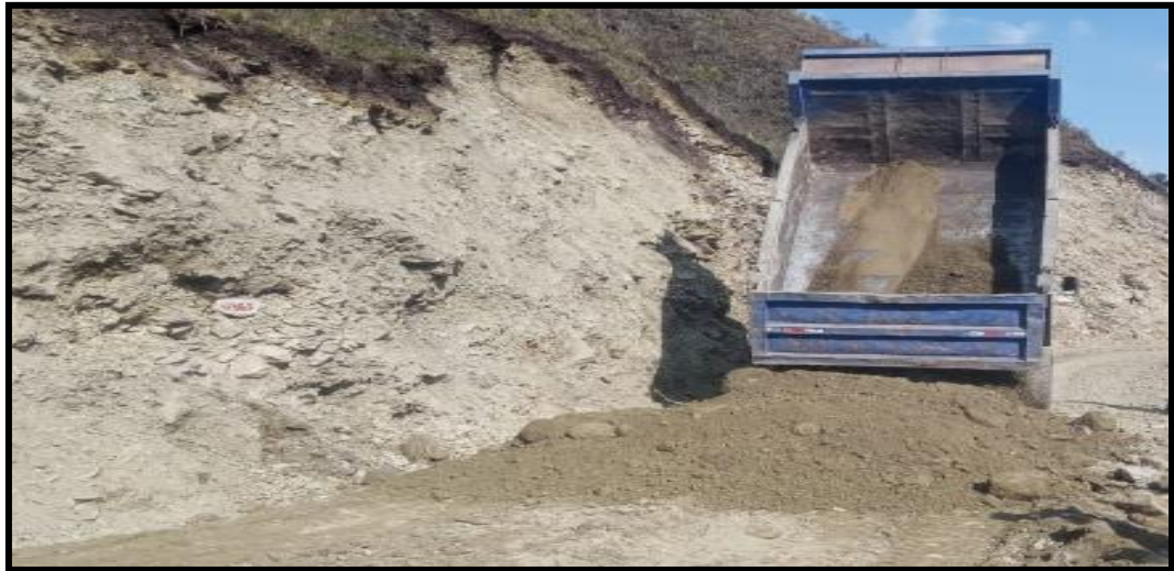
Figura N° 44 Vista del traslado de material
