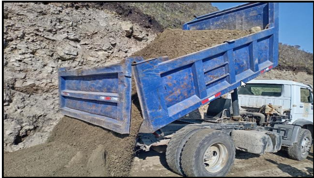
Figura N° 42 Vista del traslado de material.
