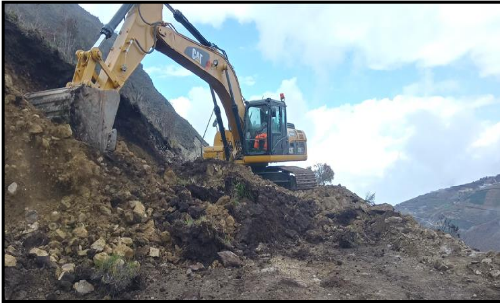
Figura N° 31 Vista de la verificación constante del avance de las partidas.
