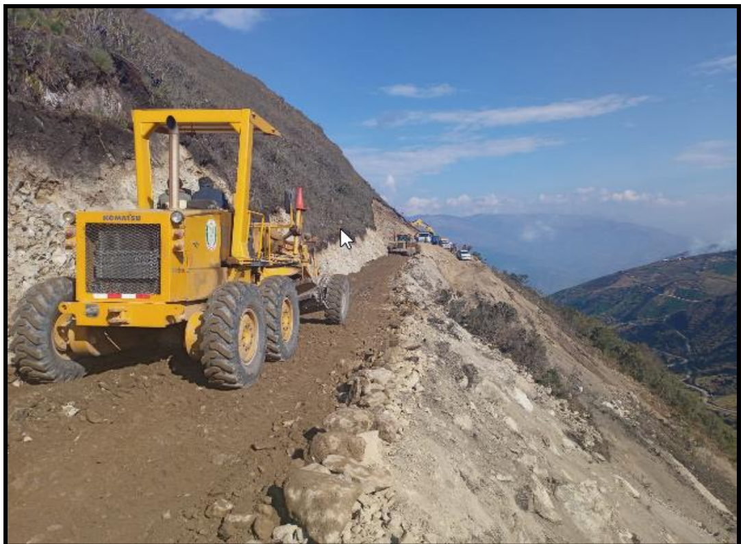
Figura N° 47 Vista de la maquinaria realizando el perfilado de afirmado
