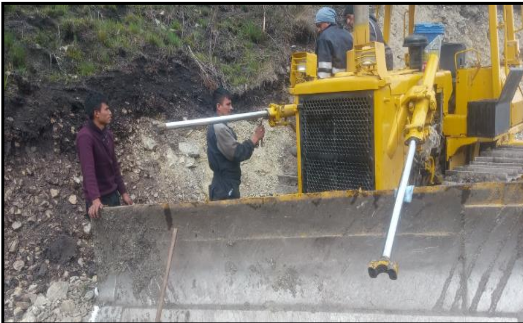
Figura N° 70 Vista de la instalación de rines en el tractor oruga.
