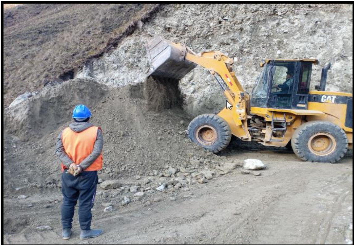
Figura N° 35 Vista de la inspección de extracción y apilado juntamente con el vigía
