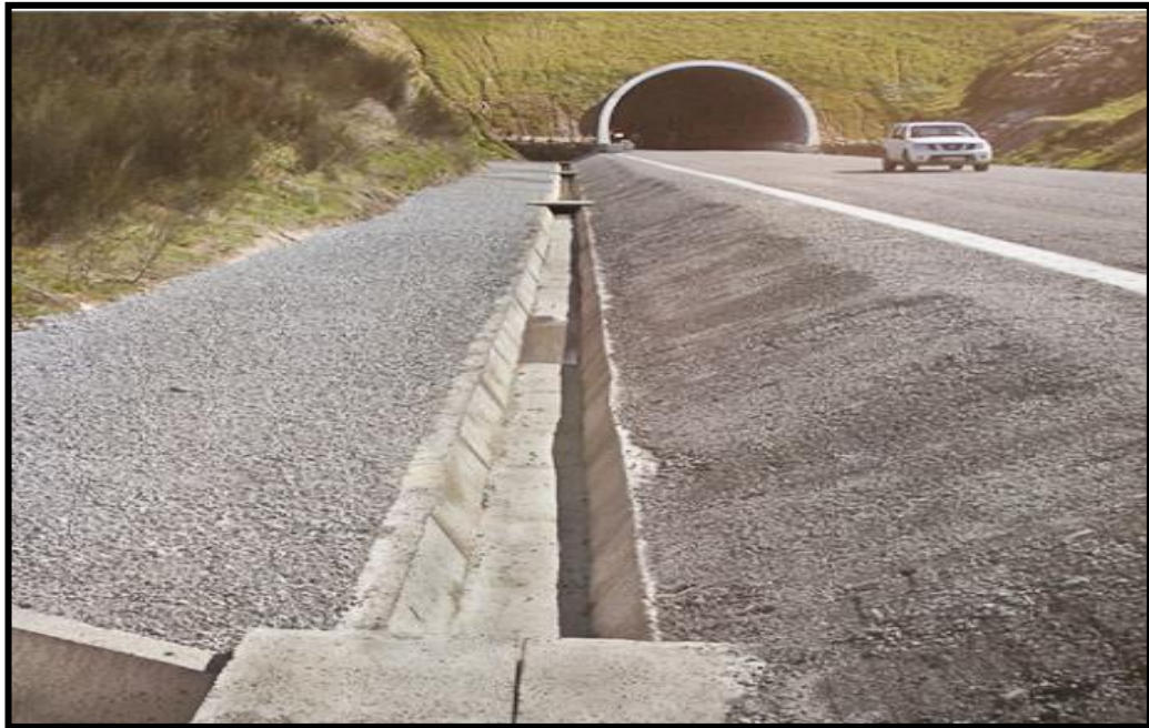
Figura N° 15 Vista de cunetas.
