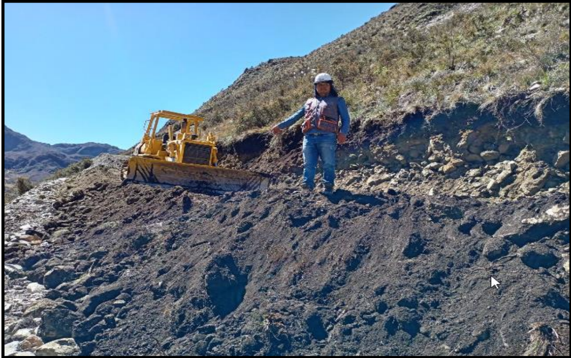
Figura N° 52 Vista de conformación de terraplenes con material propio prog. 1+500 hasta la prog 1+020.
