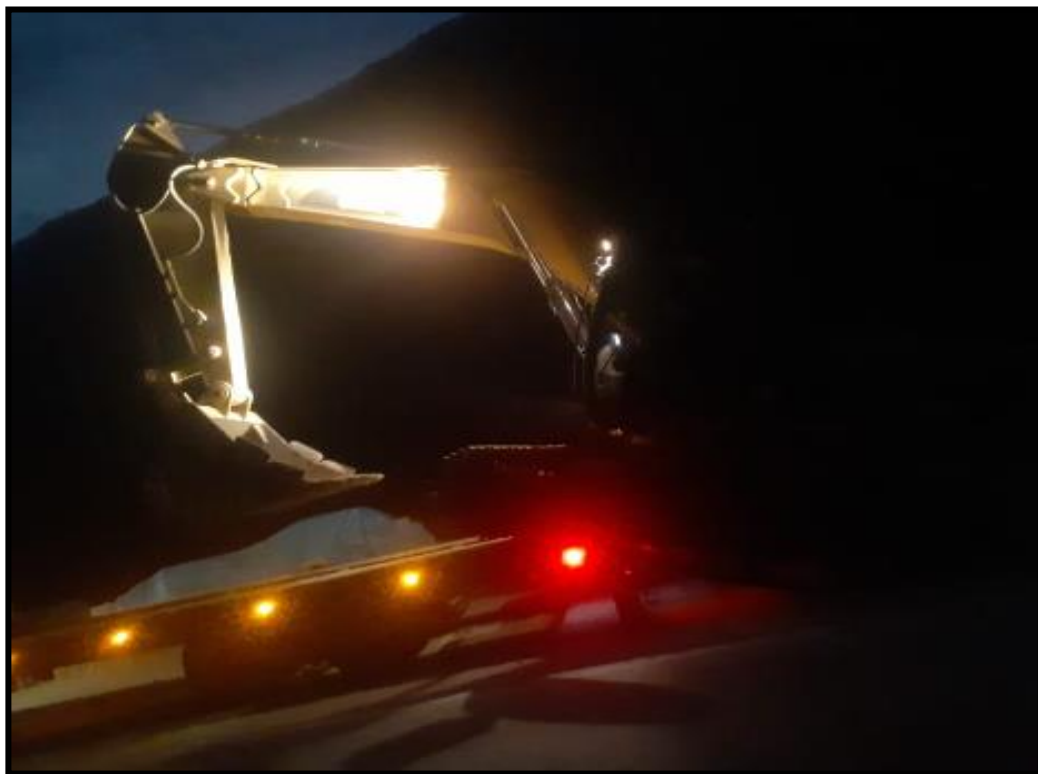
Figura N° 22 Vista de movilización de maquinaria Excavadora.
