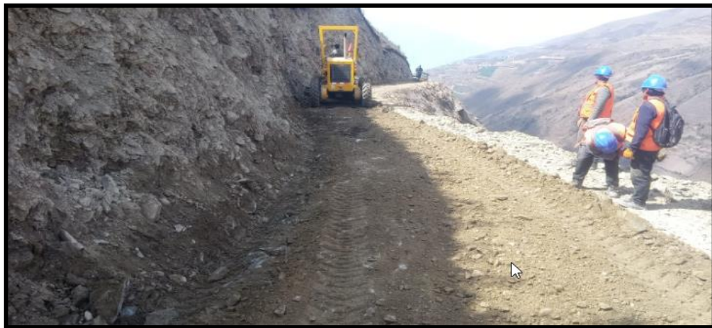
Figura N° 71 Conformación de cunetas de la prog. 1+500 hasta la prog. 1+020.
