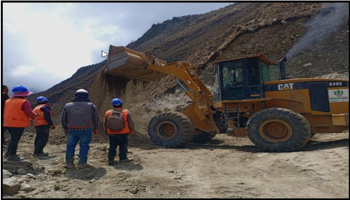
Figura N° 34 Vista de la inspección de extracción y apilado juntamente con el ing. Residente
