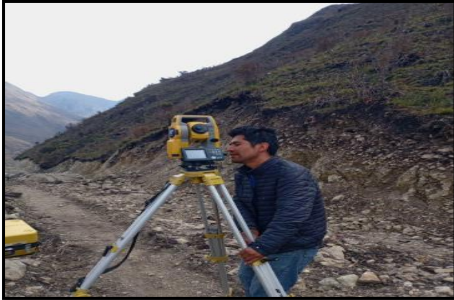
Figura N° 23 Vista del replanteo en obra.
