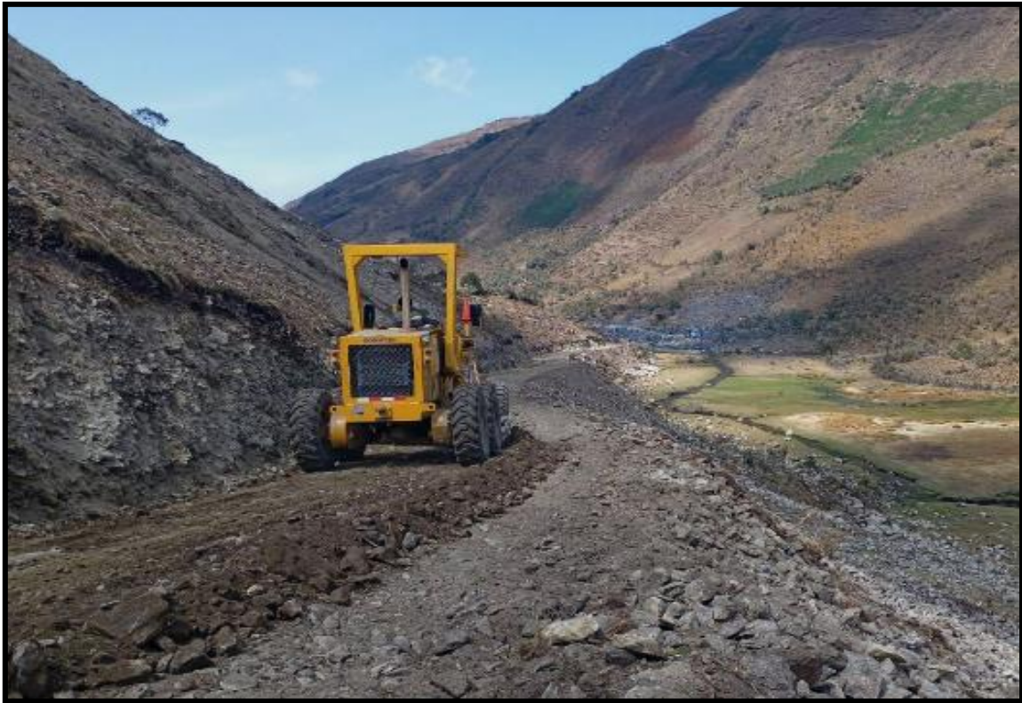
Figura N° 73 Conformación de cunetas de la prog. 0+480 hasta la prog. 0+000.
