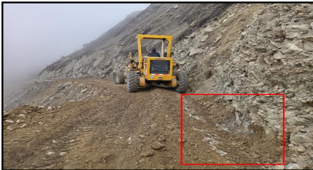
Figura N° 72 Conformación de cunetas de la prog. 1+020 hasta la prog. 0+480.
