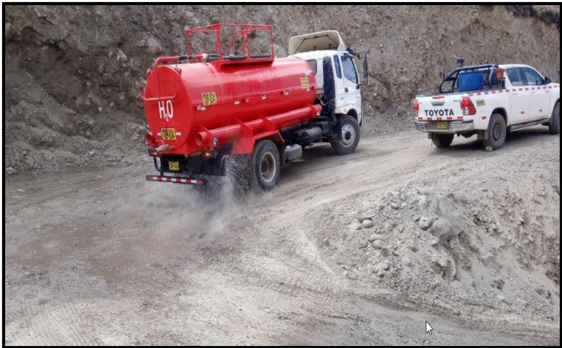
Figura N° 58 Vista de la cisterna dando la óptima humedad para el compactado
