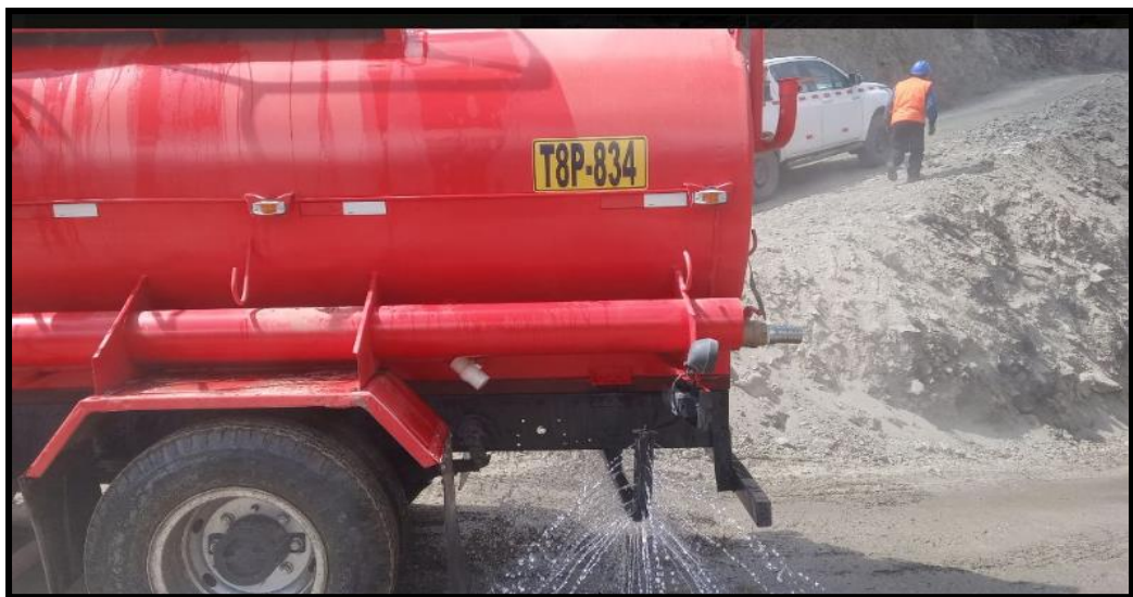
Figura N° 57 Vista de la cisterna dando la óptima humedad para el compactado
