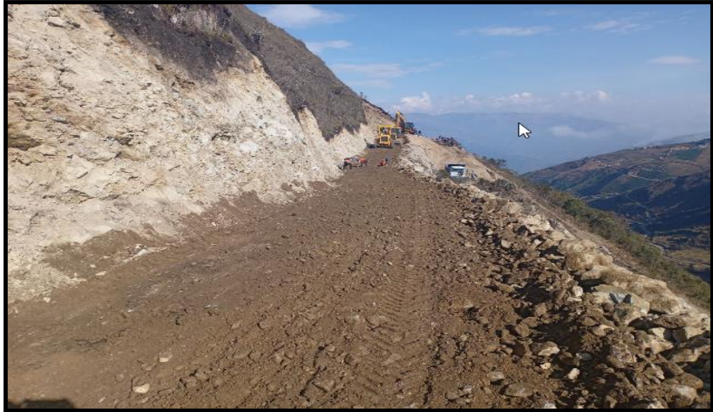
Figura N° 48 Vista de la maquinaria realizando el perfilado de afirmado.
