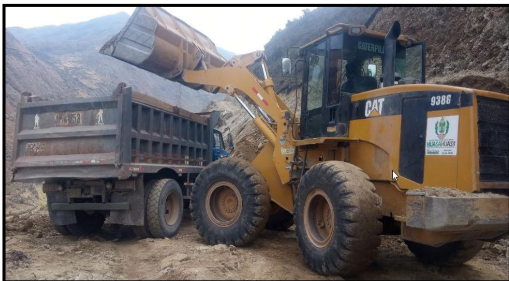
Figura N° 43 Vista del traslado de material con las maquinarias en obra
