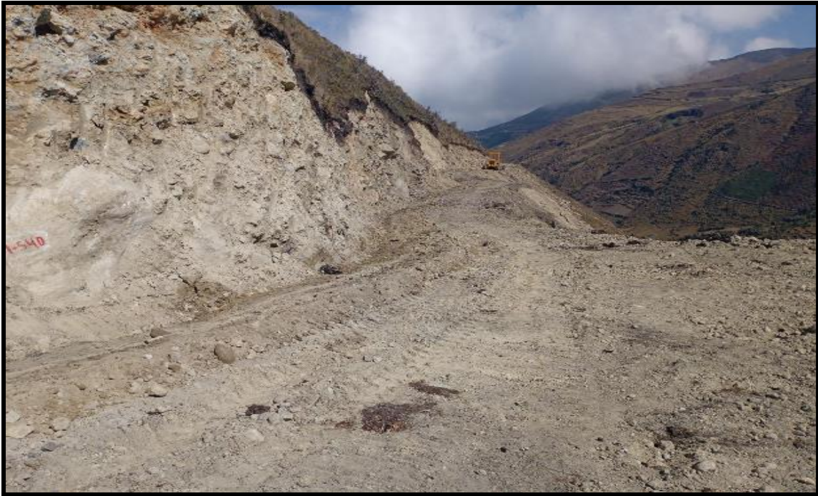
Figura N° 55 Vista de conformación de terraplenes con material propio prog. 1+500 hasta la prog 1+020.
