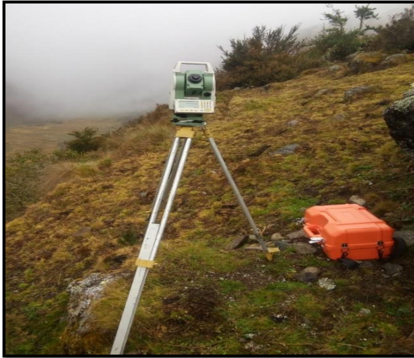
Figura N° 11 Vista del equipo para el trazo de la carretera.
