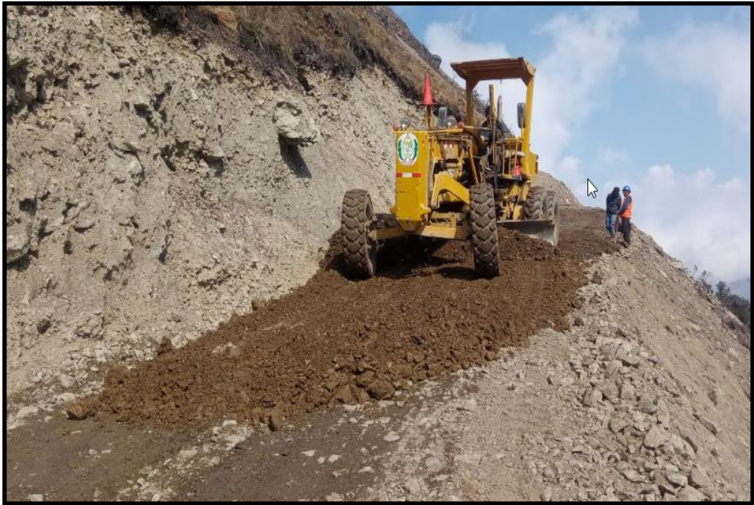
Figura N° 46 Perfilado de afirmado prog. 1+020 hasta la progr. 0+480
