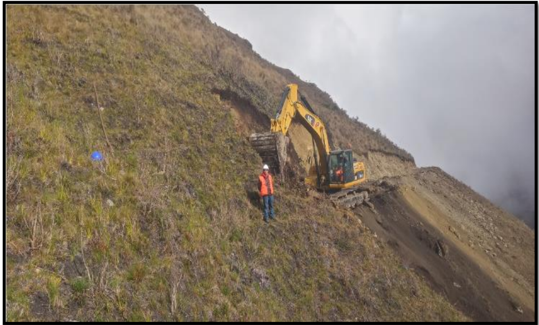
Figura N° 29 Vista de la inspección en campo del corte en suelo suelto.
