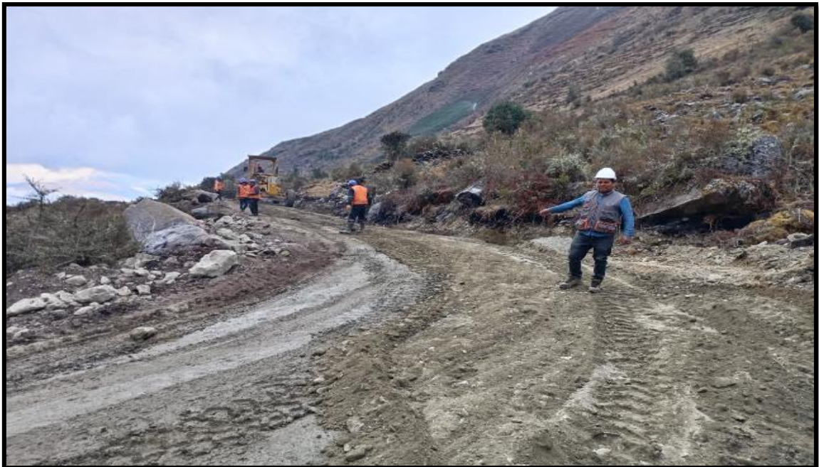
Figura N° 74 Conformación de cunetas de la prog. 0+480 hasta la prog. 0+000.
