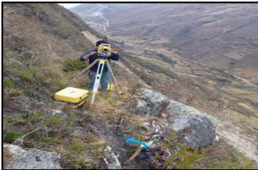
Figura N° 24 Vista del replanteo en obra.
