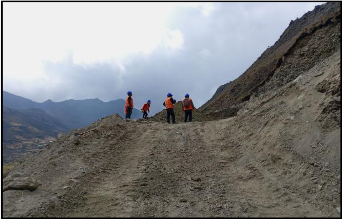
Figura N° 36 Vista del personal en el trabajo del apilonado
