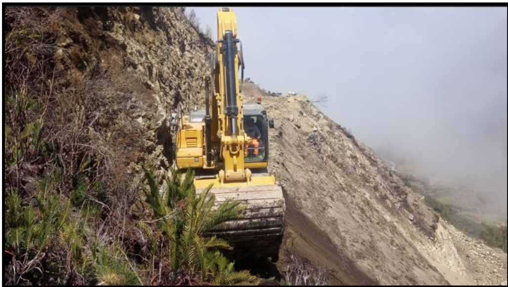
Figura N° 32 Vista del corte de carretera en obra
