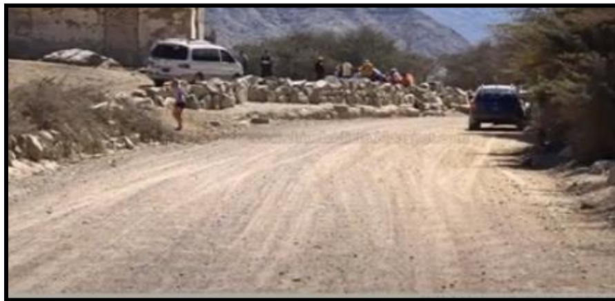
Figura N° 13 Vista de carretera de tercera clase
