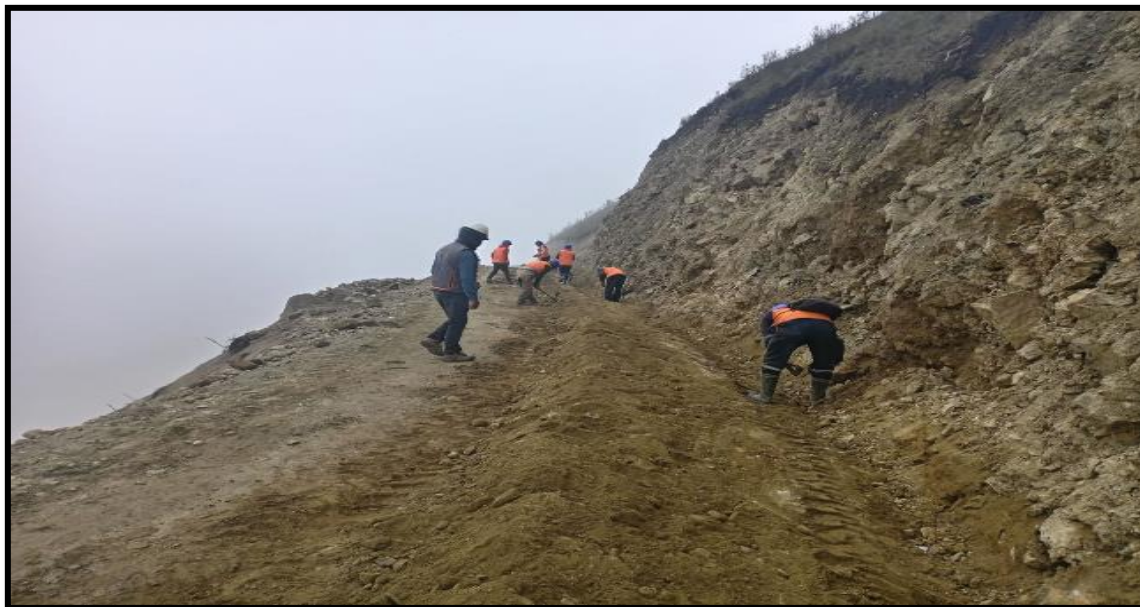
Figura N° 75 Conformación de cunetas de la prog. 1+500 hasta la prog. 0+000.
