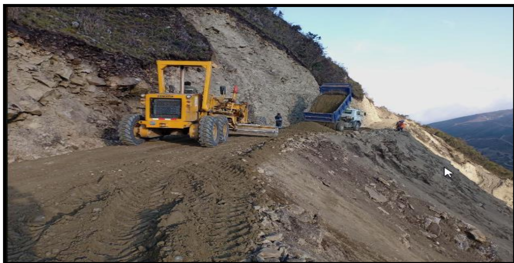
Figura N° 45 Vista del perfilado con motoniveladora de la progr. 1+500 hasta la progr. 1+020.
