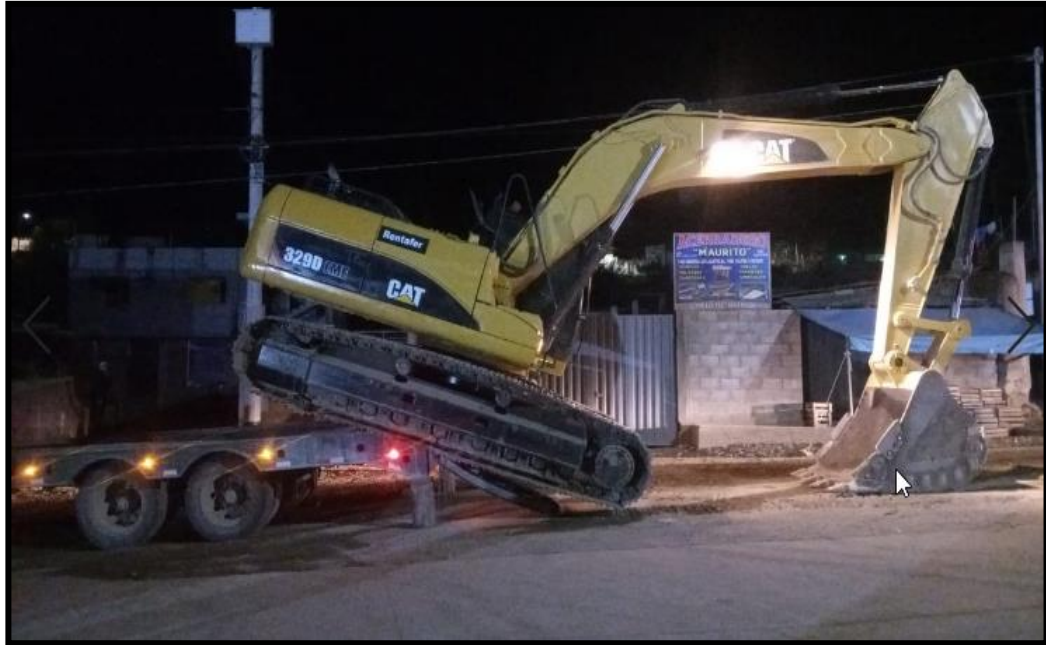
Figura N° 21 Vista de movilización de maquinaria.
