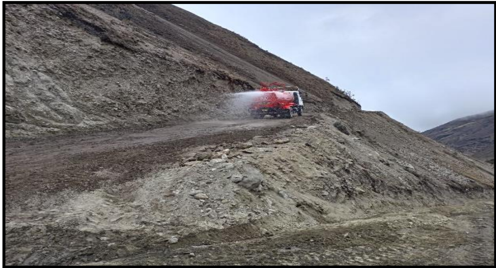
Figura N° 56 Vista de la cisterna dando la óptima humedad para el compactado
