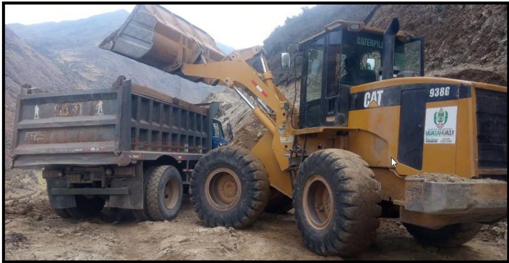
Figura N° 40 Vista del carguío de afirmado en obra.
