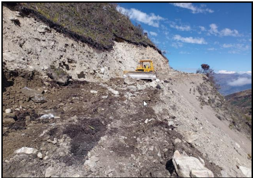
Figura N° 51 Conformación de terraplenes con material propio prog. 0+480 hasta la prog 1+020.
