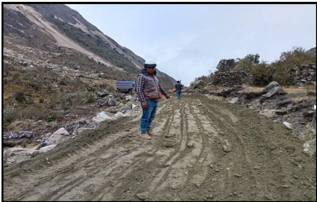
Figura N° 49 Vista de la inspección de los trabajos por parte del bachiller juntamente con el ing. Residente.
