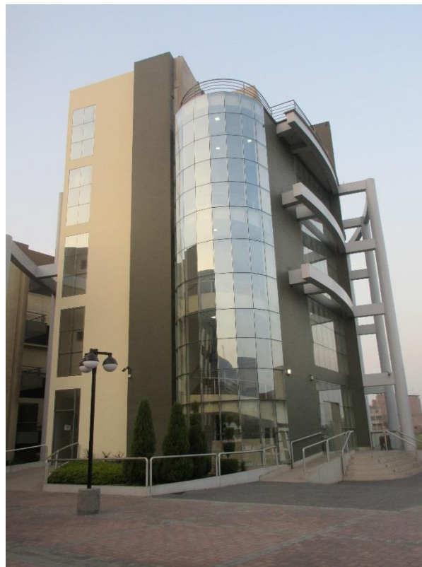
Figura 1. Edificio administrativo de la FIA
