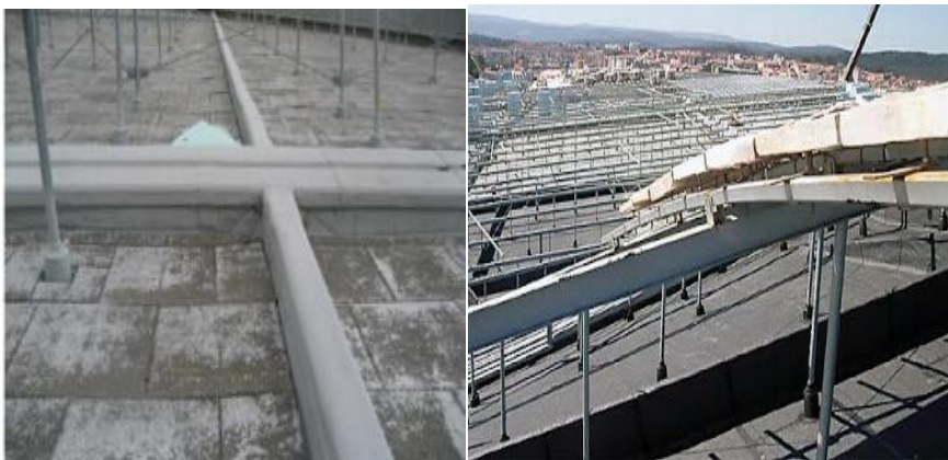
Figura 72. Vista del acabado final de la cubierta impermeabilizada y recubierta con losa de cuarcita
