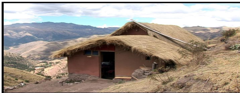
Figura 8. Casas con techo de Chillihua
