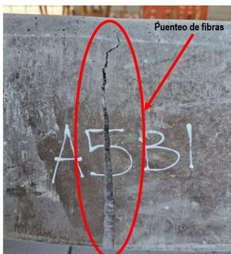
Figura 14. Puenteo de fibras tras la fisuración en ensayo de flexión.
