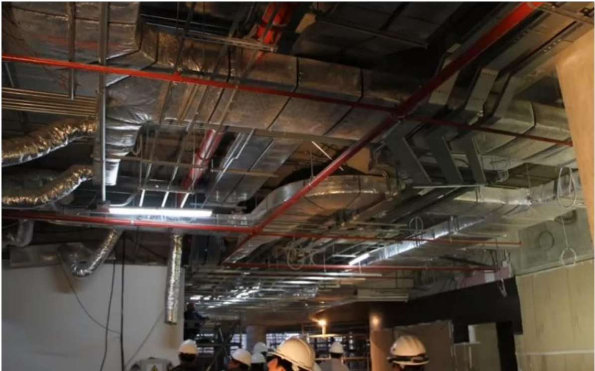
Figura 4. Realidad de la construcción.
