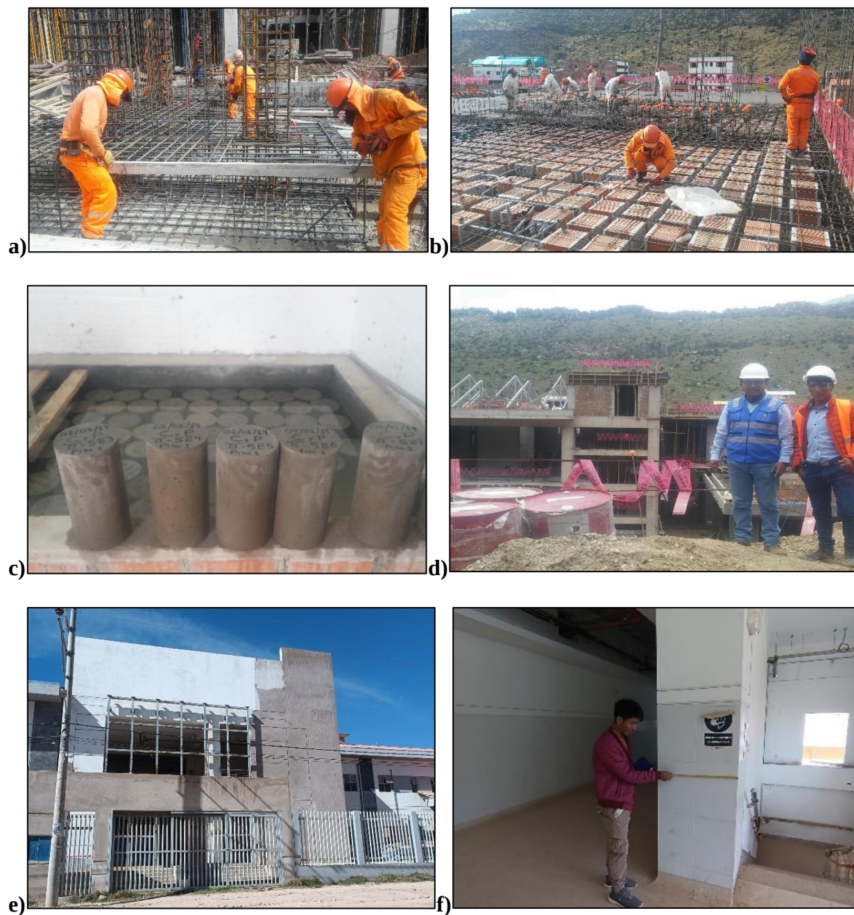
Figura 03. a) Inspección del correcto colocado del acero en zapatas y columnas, b) Inspección del vaciado del concreto pre mezclado en vigas y losas, c) Colocación de probetas en las cámaras de curado, d) Inspección de trabajo en campo, e) Vista frontal del bloque de análisis, f) Medición de las dimensiones del bloque de análisis. Fuente: Los autores.
