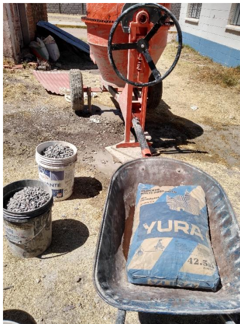
Fotografia 20. Cemento Wari I para elaborar el concreto y el ensayo de calor de hidratación.
