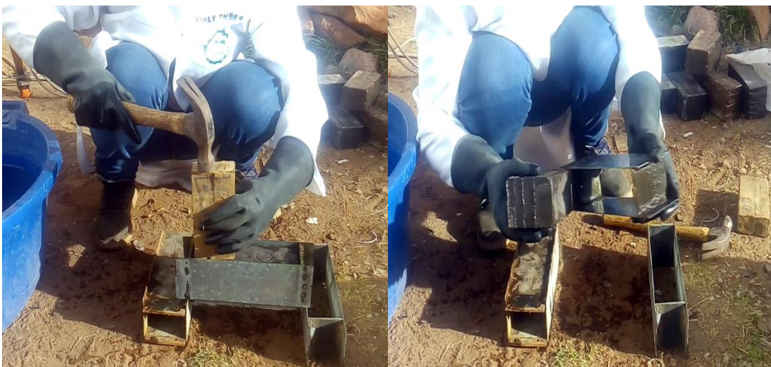
Fotografía 9. Proceso de desmoldado.
