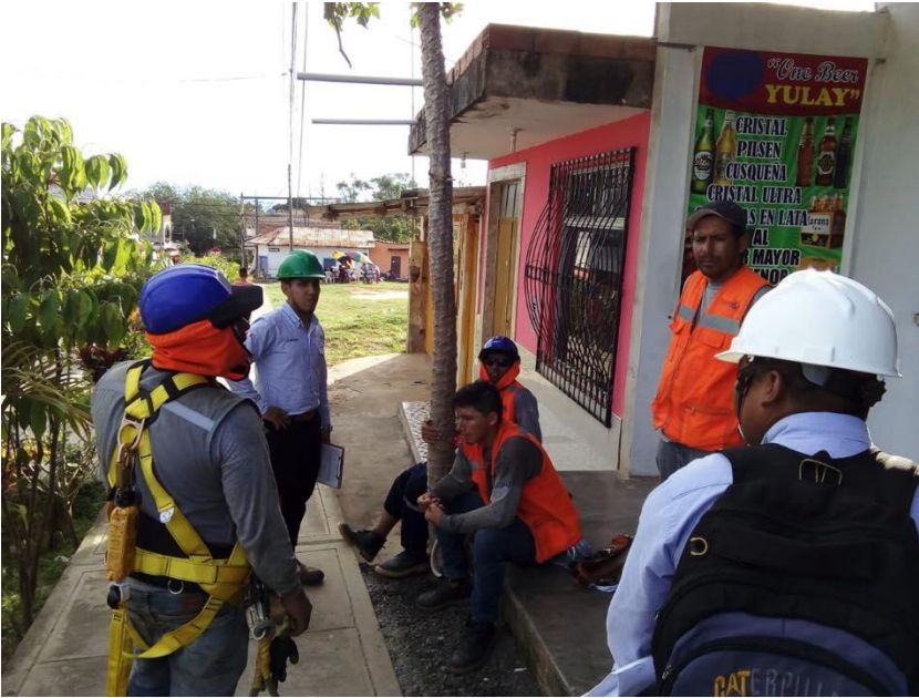
Fotografía N° 03 Inspección inopinada al personal Contratista del Departamento de Comercial en la actividad de Tendido de fibra en las estructuras de Electro Oriente S.A.
