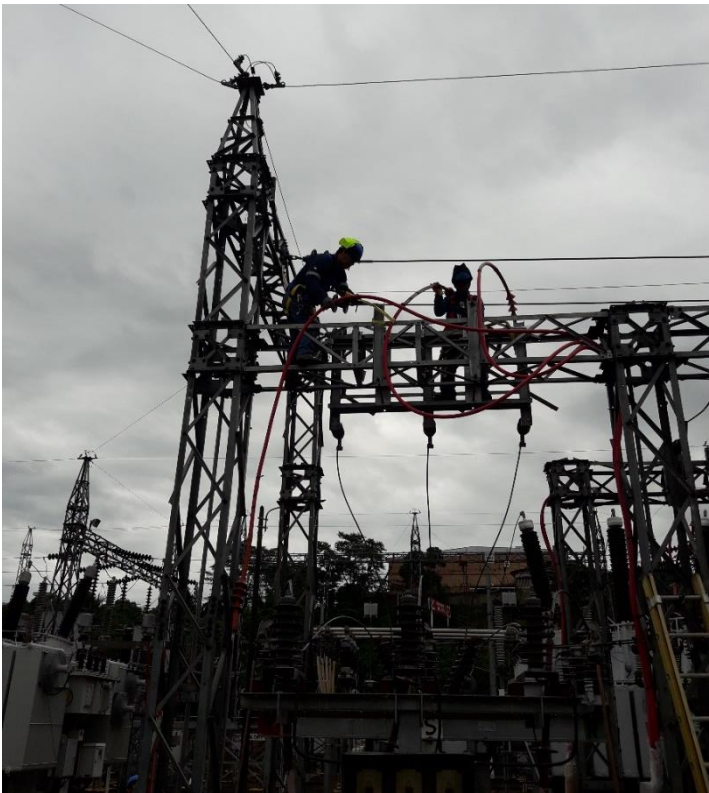
Fotografía N° 06 Supervisión de trabajos de mantenimiento en la Sub Estación Tarapoto
