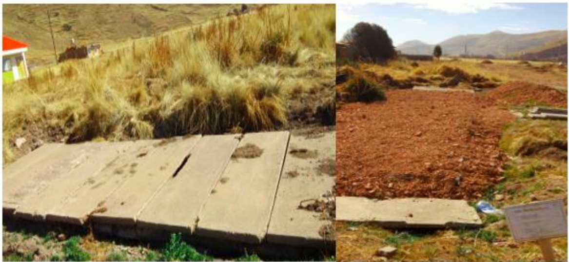
Figura 23. Estado actual de los Tanques Sépticos.
