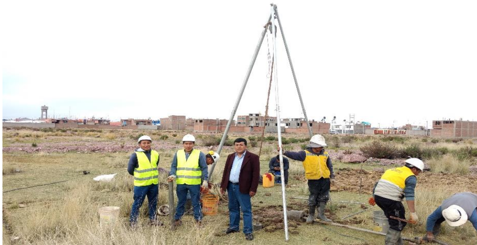
Figura 26. Ensayo de SPT en campo, en la Urb. Los Ángeles de Miraflores.
