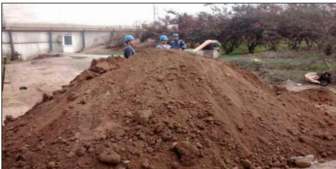
Figura 7. Tierra de Chacra por excavación de zanjas en la zona de Pariachi
