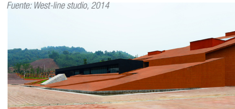
Figura 107. Fotografía posterior del Edificio Fuente: West-line studio, 2014
