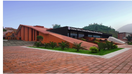
Figura 108. Fotografía plaza de acceso
