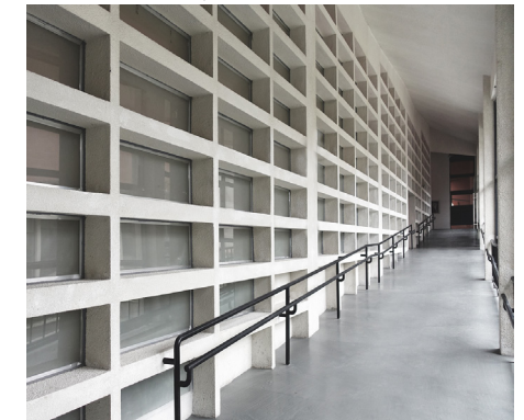
Figura 116. Fotografía rampa de circulación
