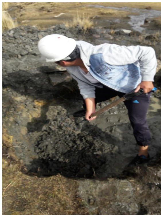
Imagen 04. Excavación de pozo.
