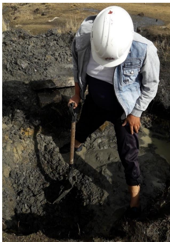
Imagen 06. Excavación de pozo Hahuaruyo.
