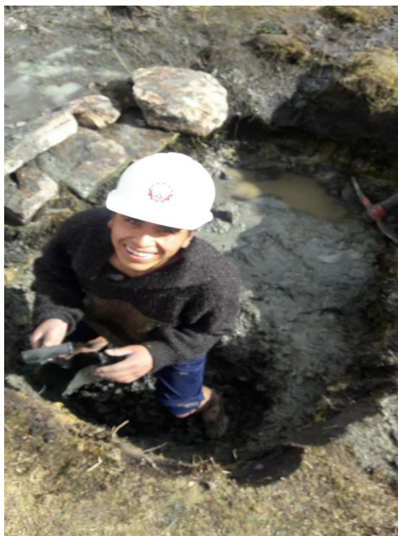
Imagen 03. Excavación de pozo.
