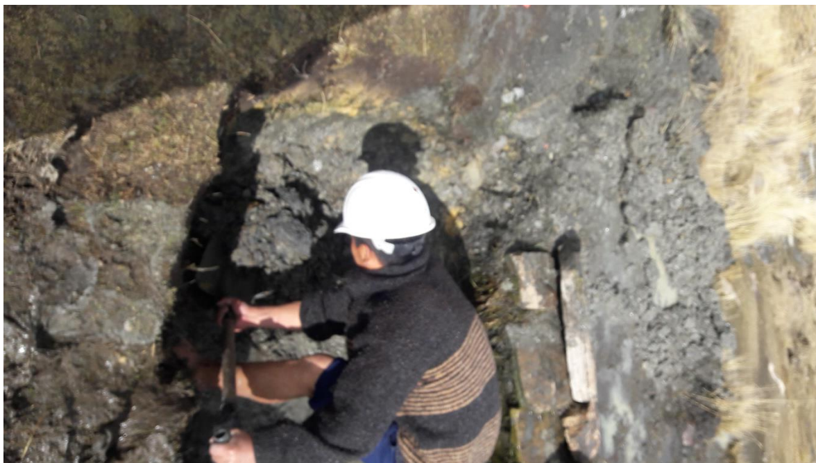
Imagen 01. Excavación de pozo.
