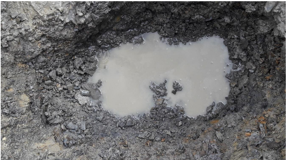
Imagen 08. Afloramiento de agua en el pozo excavado.
