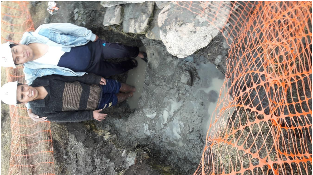
Imagen 10. Excavación de pozo Callpacuyo.
