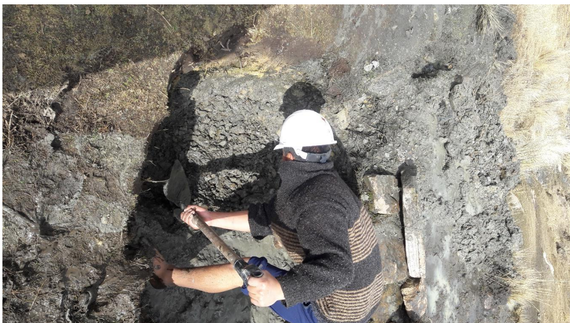
Imagen 02. Excavación de pozo.
