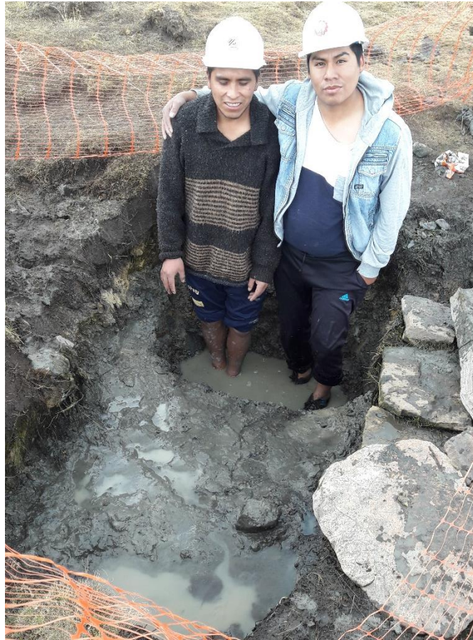
Imagen 11. Afloramiento de agua en el pozo excavado Callpacuyo. Fuente: toma propia.
